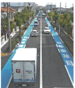
自転車専用通行帯を設けて安全な通行空間を確保
