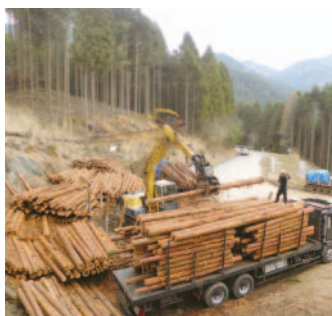
伐採した原木の搬出のための林道や作業道の整備
