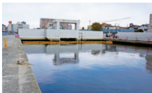
整備された洗戎川水門（西宮市）
