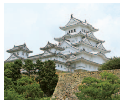
平成の大改修を終え、グランドオープンした姫路城
