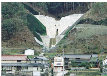
桐谷川砂防えん堤（佐用町）
