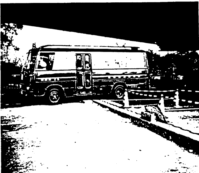
橋梁取り付け部の段差（国道43号）
