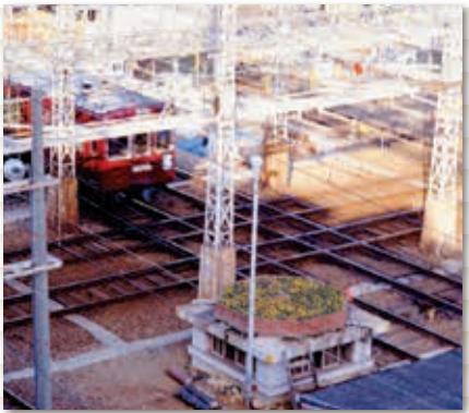
大正15年から昭和59年まで続いた 阪急西宮北口駅の平面軌道交差(ダイヤモンドクロス)
