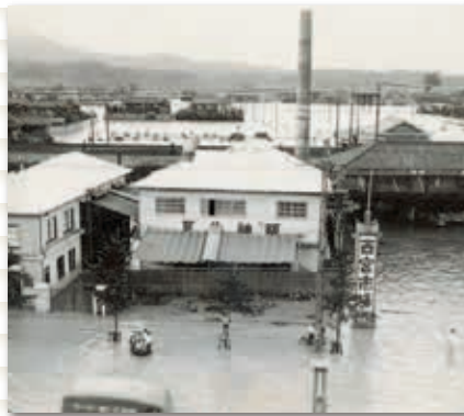
阪神大水害で浸水した市役所周辺
