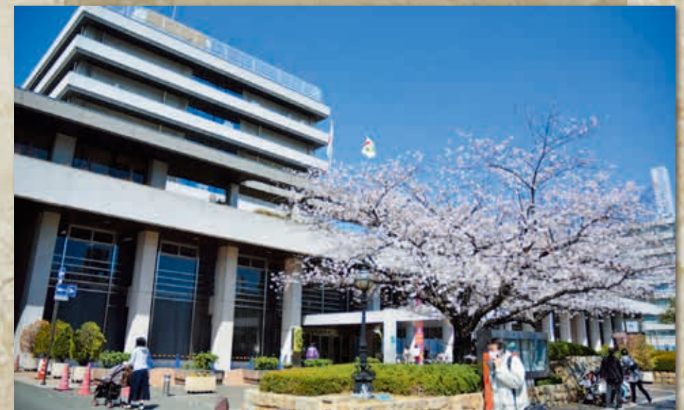
昭和46年に完成した現在の市庁舎
