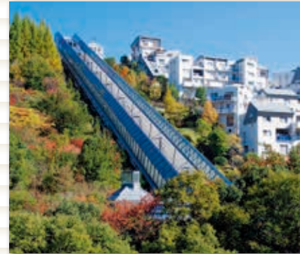
JR西宮名塩駅から住宅街へ続く 高低差約60mの斜高エレベーター
