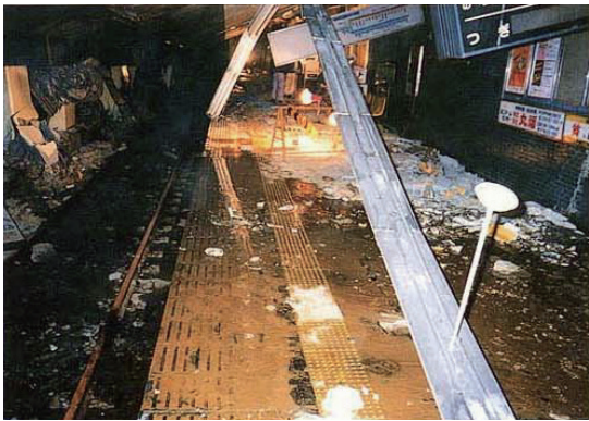
被災した大開駅のプラットフォーム
