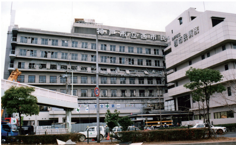
本館5階部分が圧壊した西市民病院（1995年1月19日）
