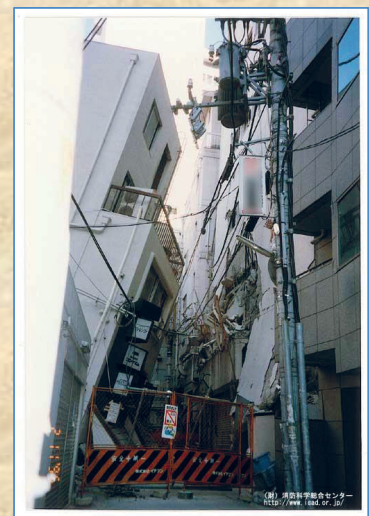
阪神・淡路大震災で倒れた雑居ビル (財) 消防科学総合センター 災害写真データベースより
