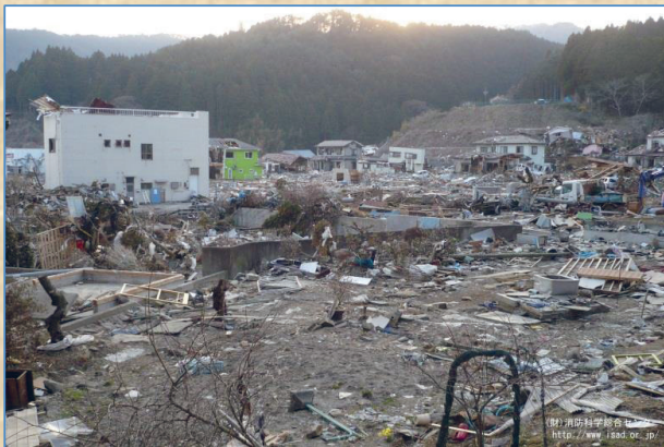
津波で被害を受けた石巻市雄勝地区 (財) 消防科学総合センター 災害写真データベースより
