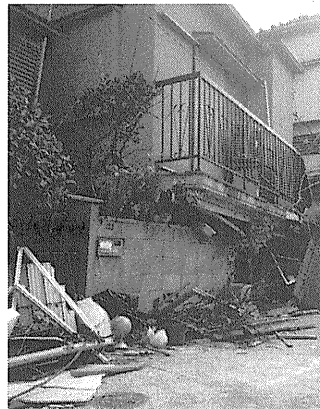
【写真】壊れた自宅
