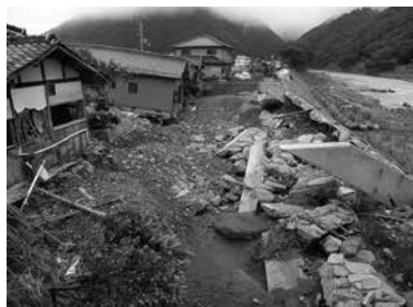
倒壊した佐用川の護岸
