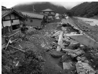
崩壊した佐用川の護岸
