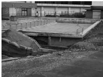
土砂の流出によりプールサイドが崩壊した丹波市立前山小学校のプール
