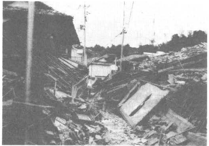
写真5→ 木造家屋の全壊（北淡町富島）
