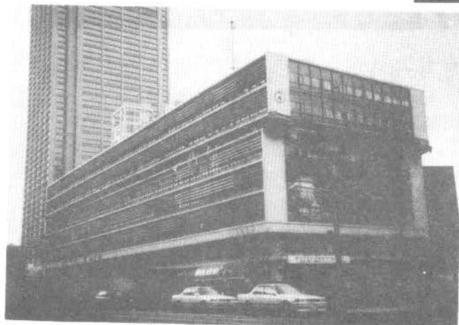
←写真8 中央区神戸市役所2号館 （8階建ての6階がつぶれている）
