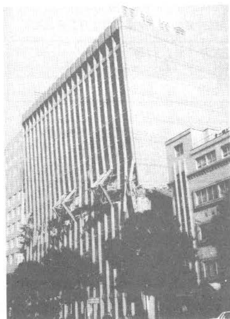
←写真16 三宮駅南側明治生命ビル (12階の5階がつぶれる)
