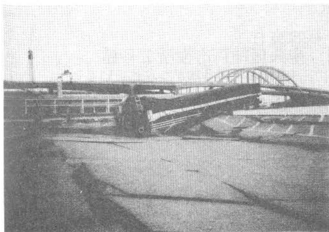
←写真12 神戸新港第三突堤 (陥没によりトラックが動けない状態)
