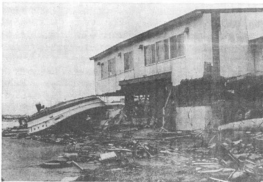
写真「平成5年（1993年）北海道南西沖地震」による津波で被害を受けた建物及び漁船（北海道奥尻町育苗港付近。函館海洋気象台による）
