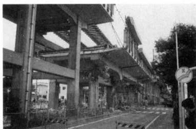
PHOTO8.2.2 SHIN-KANSEN (AMAGASAKI) 写真8.2.2 JR新幹線 (尼崎市武庫の里付近)
