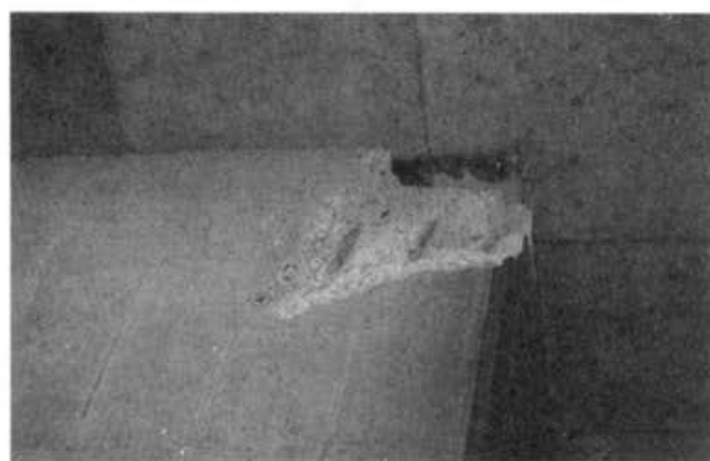
PHOTO7.3.2 CHUGOKU HIGHWAY (ITAMI) 写真7.3.2 中国自動車道 (伊丹市荻野付近)
