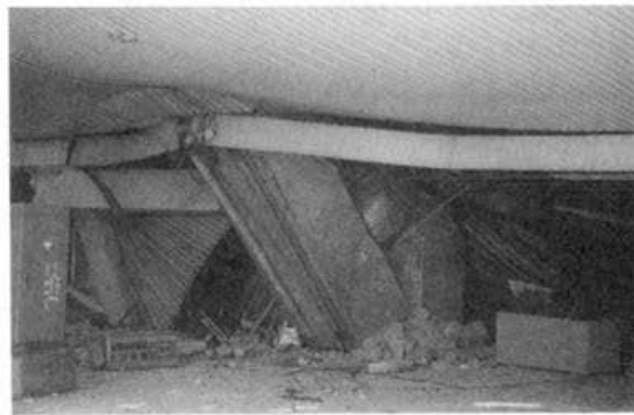
PHOTO8.5.5 HANKYU LINE (ITAMI ST.) 写真8.5.5 阪急伊丹線（伊丹駅）
