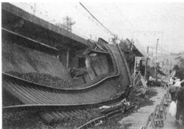
PHOTO8.5.2 HANKYU LINE (NISHINOMIYA) 写真8.5.2 阪急神戸線（西宮市若松町付近）
