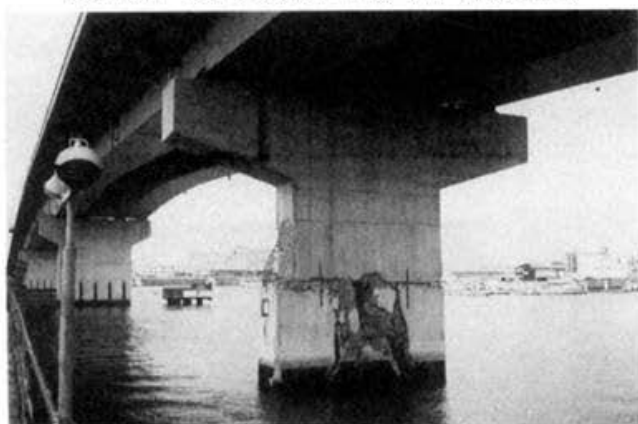
PHOTO7.6.2 NISHINOMIYA OHASHI BRIDGE 写真7.6.2 西宮大橋（西宮浜）
