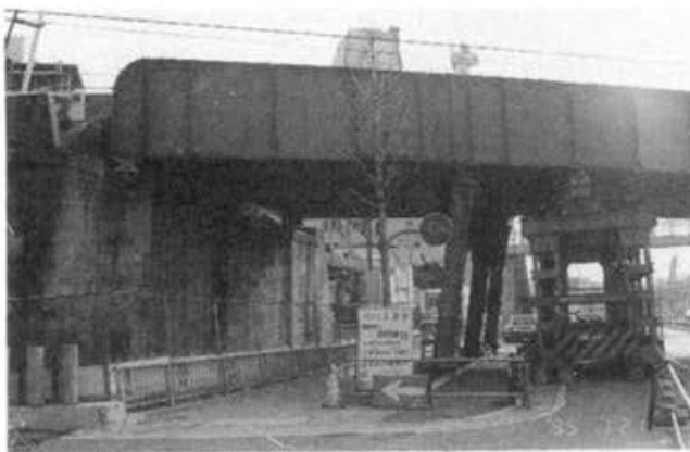
PHOTO8.4.11 HANSHIN LINE (NISHI-NADA ST.) 写真8.4.11 阪神本線 (西灘駅)
