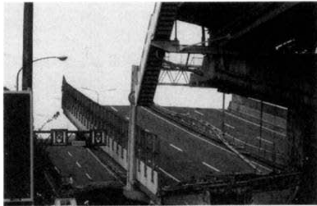
PHOTO7.1.2 HANSHIN EXP.WAY (NISHINOMIYA) 写真7.1.2 阪神高速道路 (西宮市鞍掛町付近)
