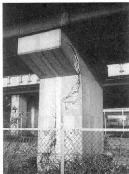
PHOTO7.5.1 ROUTE 176 (ITAMI) 写真7.5.1 国道176号線 (伊丹市荒牧天王寺川橋梁)
