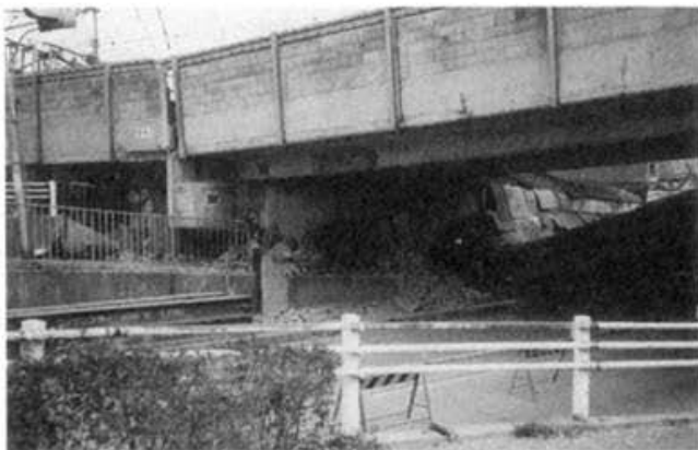
PHOTO8.3.1 JR-TOKAIDO LINE (NADA-KU, KOBE) 写真8.3.1 JR東海道線 (灘区河原通二丁目)
