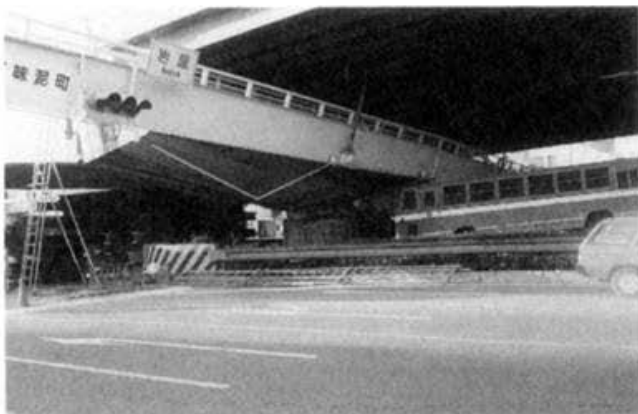
PHOTO7.5.2 ROUTE 43 (NADA-KU, KOBE) 写真7.5.2 国道43号線岩屋陸橋（神戸市灘区都通）
