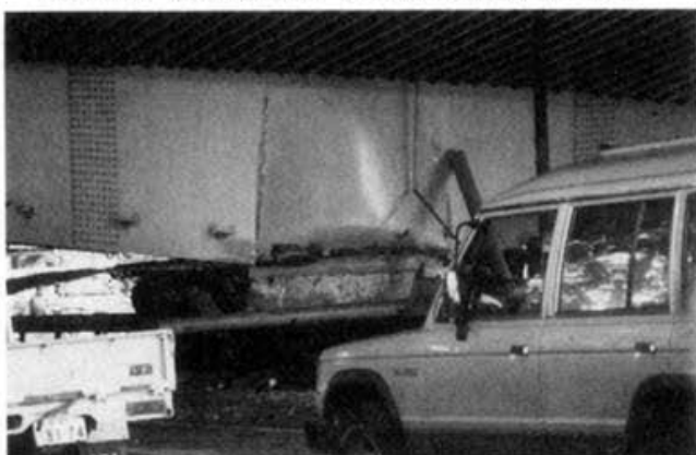
PHOTO7.1.3 HANSHIN EXP.WAY (NISHINOMIYA) 写真7.1.3 阪神高速道路 (西宮市香炉園付近)
