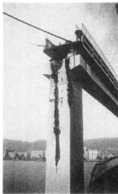
PHOTO8.7.2 ROKKO LINER 写真8.7.2 六甲ライナー（六甲大橋 六甲アイランド側取付部）
