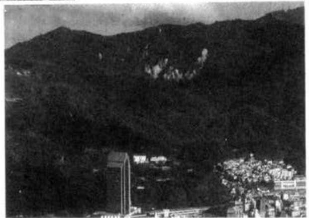
写真4. 3 神戸市中央区苧川上流 の露頭崖の崩壊状況
