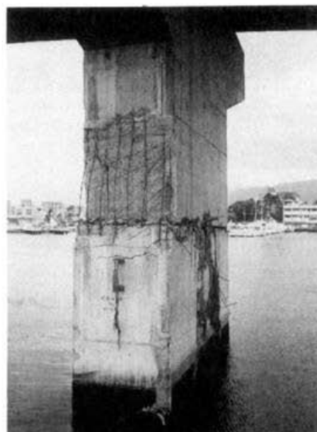
PHOTO7.6.3 NISHINOMIYA OHASHI BRIDGE 写真7.6.3 西宮大橋（西宮浜）
