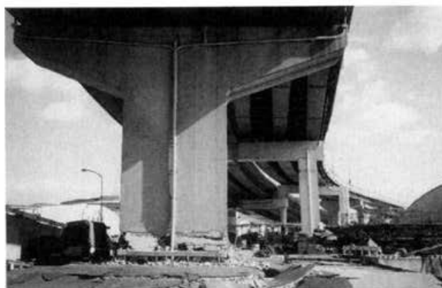
PHOTO7.7.2 KOBE HARBOUR HIGHWAY 写真7.7.2 神戸ハーバーハイウェイ
