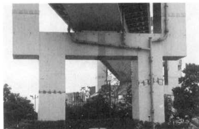
PHOTO7.4.4 ROUTE.2 HAMATE BYPASS (CHUO-KU, KOBE) 写真7.4.4 国道2号線浜手バイパス (中央新港町付近)
