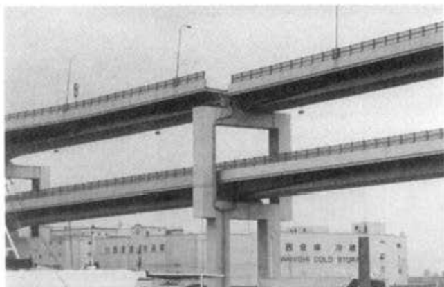
PHOTO7.4.2 ROUTE.2 HAMATE BYPASS (CHUO-KU, KOBE) 写真7.4.2 国道2号線浜手バイパス (中央区浜辺通)
