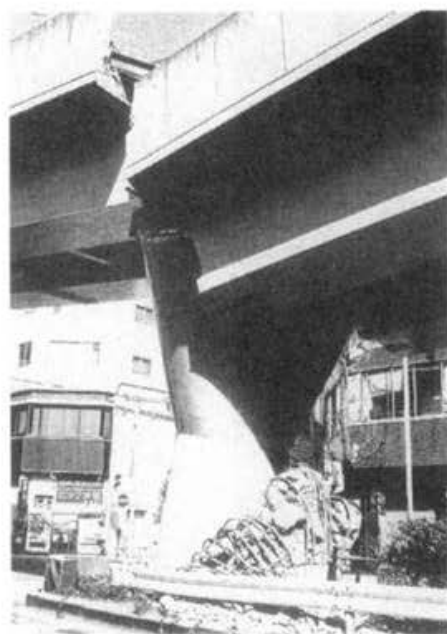
PHOTO8.6.1 PORT LINER 写真8.6.1 ポートライナー （中央区御幸通6丁目）
