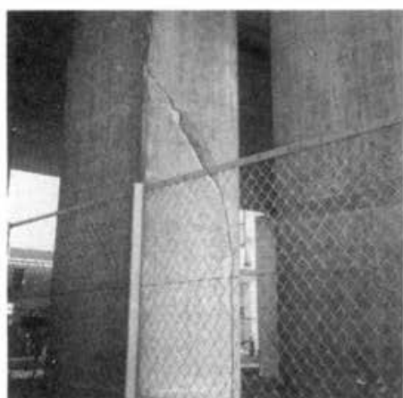
PHOTO7.3.1 CHUGOKU HIGHWAY (ITAMI) 写真7.3.1 中国自動車道 (伊丹市荻野付近)
