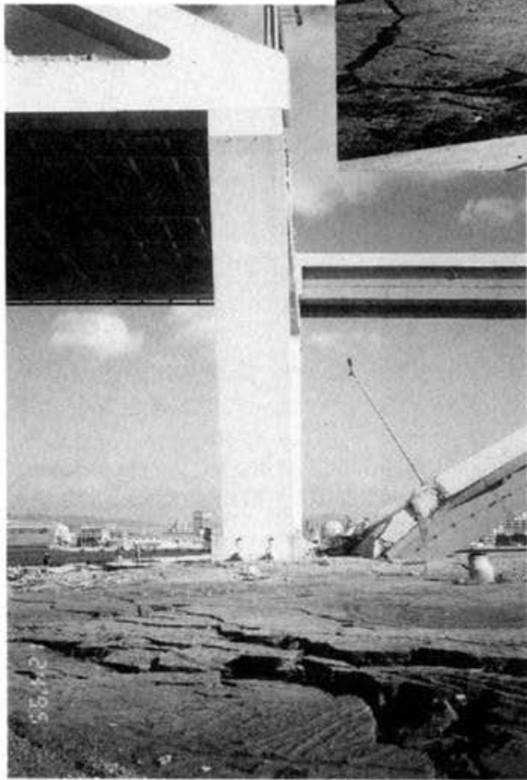
図-5.4 阪神高速橋脚の落橋及び地面の側方流動 (Collapse of Hashin Express Way and Lateral Movement of Ground)
