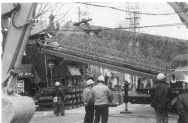
PHOTO8.4.7 HANSHIN LINE (NADA-KU, KOBE) 写真8.4.7 阪神本線 (灘区大石東町3丁目付近)
