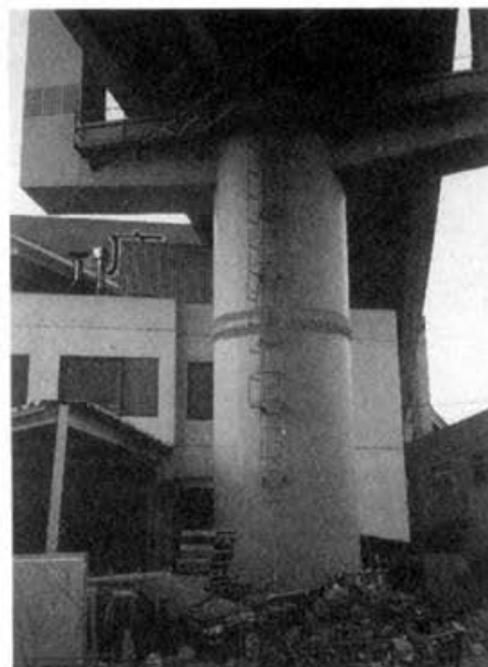
PHOTO7.4.1 ROUTE.2 HAMATE BYPASS (CHUO-KU, KOBE) 写真7.4.1 国道2号線浜手バイパス (中央区浜辺通)
