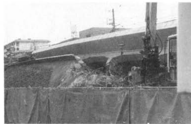
PHOTO8.5.1 HANKYU LINE (NISHINOMIYA) 写真8.5.1 阪急神戸線 (西宮市室川町付近)
