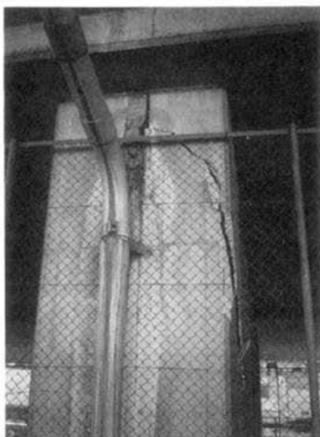
PHOTO7.3.3 CHUGOKU HIGHWAY (ITAMI) 写真7.3.3 中国自動車道 (伊丹市荻野付近)
