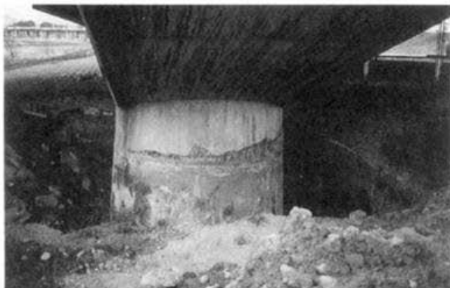
PHOTO7.2.3 MEISHIN HIGHWAY (MUKOGWA BRIDGE) 写真7.2.3 名神高速道路 (武庫川橋梁)
