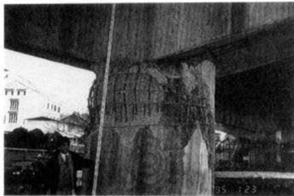
PHOTO7.6.1 ITAMI-TOYONAKA ROUTE (ITAMI) 写真7.6.1 伊丹豊中線天津陸橋（伊丹市天津）
