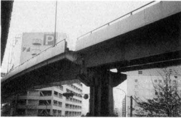
PHOTO7. 1. 9 HANSHIN EXP.WAY (CHUO-KU, KOBE) 写真7. 1. 9 阪神高速道路 (中央区磯上通/生田川入出路)
