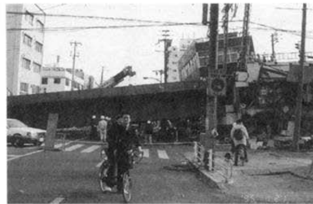
PHOTO8.4.8 HANSHIN LINE (NADA-KU, KOBE) 写真8.4.8 阪神本線 (灘区大石東町5丁目付近)
