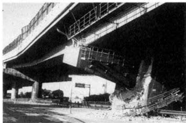
PHOTO7.1.4 HANSHIN EXP.WAY (HIGASHI-NADA-KU, KOBE) 写真7.1.4 阪神高速道路 (東灘区深江本町付近)
