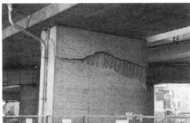
PHOTO7.2.5 MEISHIN HIGHWAY (AMAGASAKI) 写真7.2.5 名神高速道路 (尼崎市水堂町付近)
