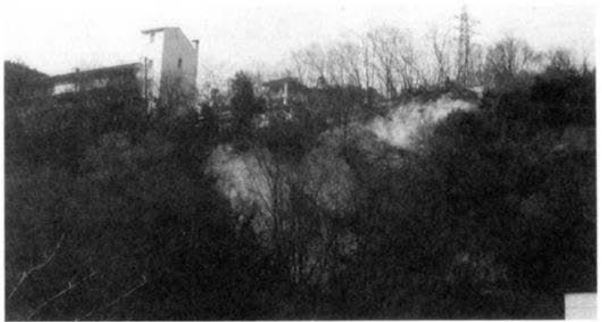
写真4. 1 神戸市灘区 鶴甲老人ホーム東斜面の 崩壊状況
