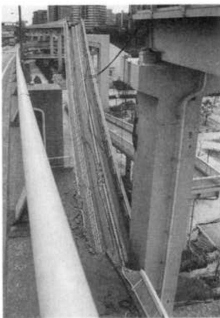
PHOTO8.7.1 ROKKO LINER 写真8.7.1 六甲ライナー（六甲大橋 六甲アイランド側取付部）
