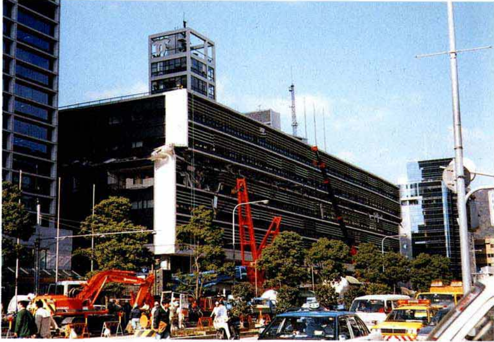
中間階の崩壊
