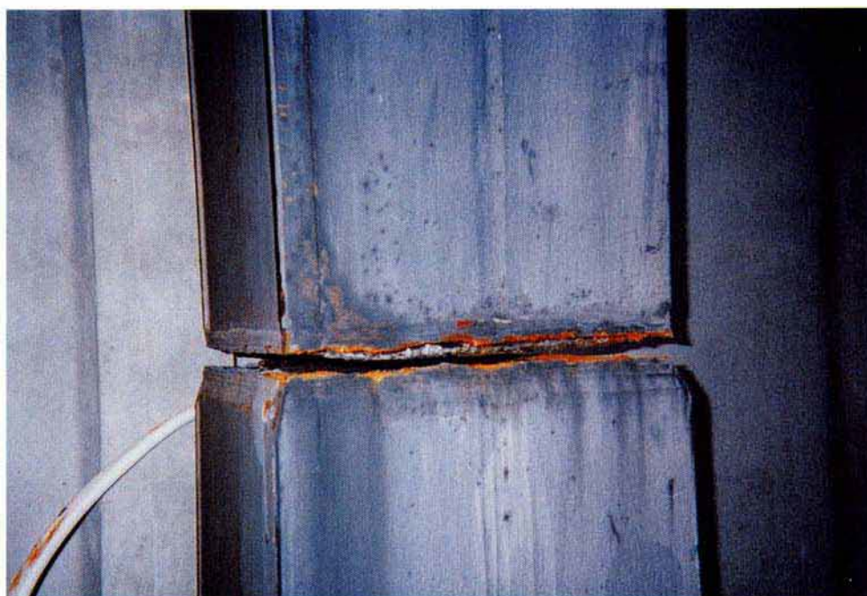
柱の破断
