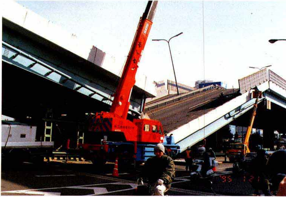
高架道路の橋桁落下
