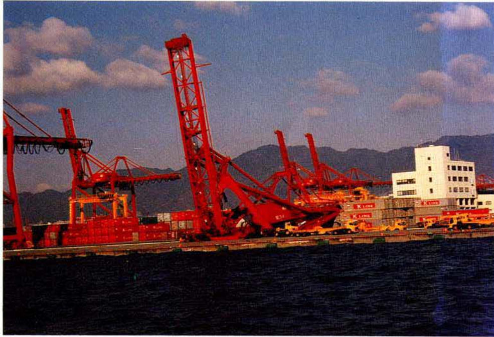
ガントリークレーンの倒壊
