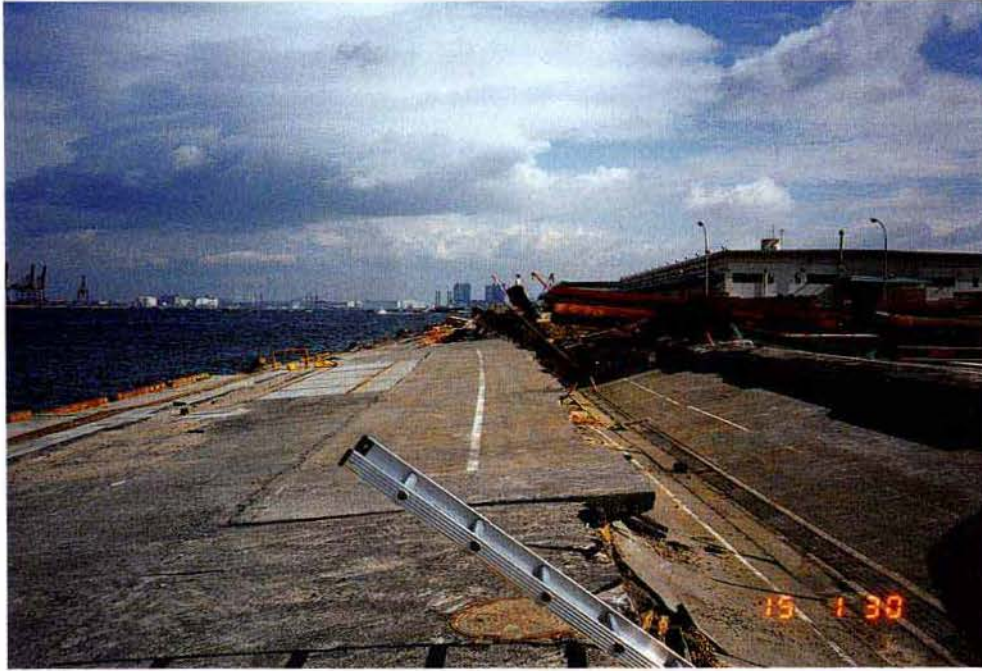
岸壁の被害
