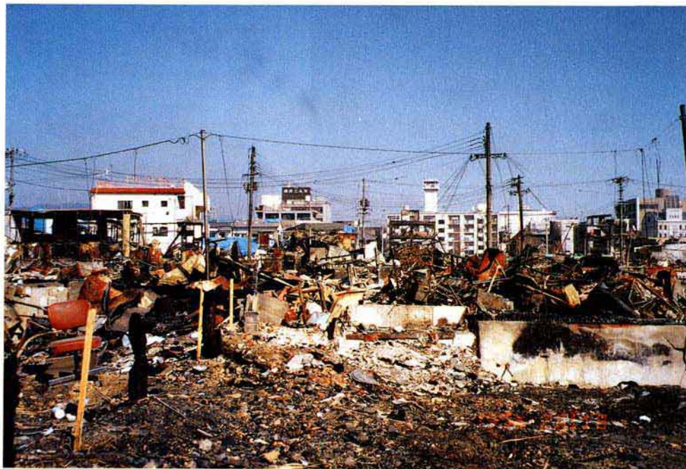
火災による被害
