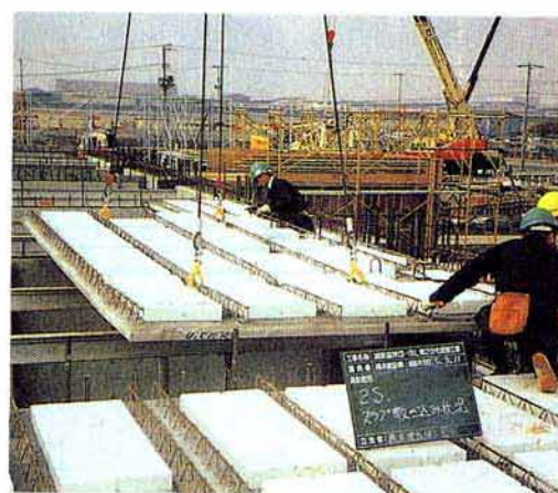
PC床板の吊り込み, セット
