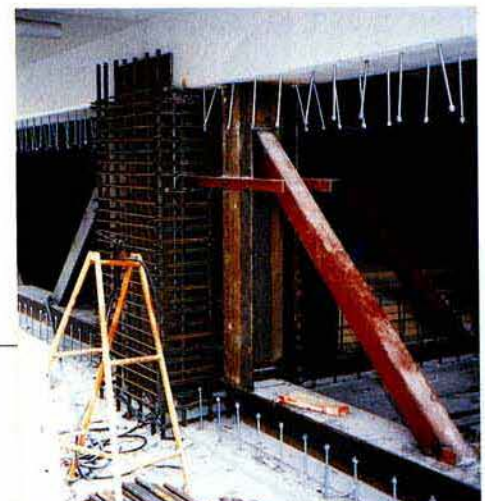
壁, 柱による耐震補強
