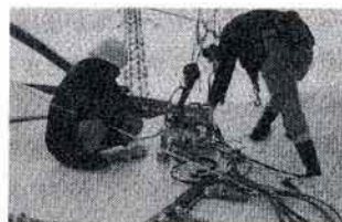
現場膜体補修技術
