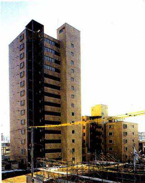
メイゾン琴似新築工事：Hi-W構法 地上14階 延床面積3,741㎡ 1990年3月竣工
