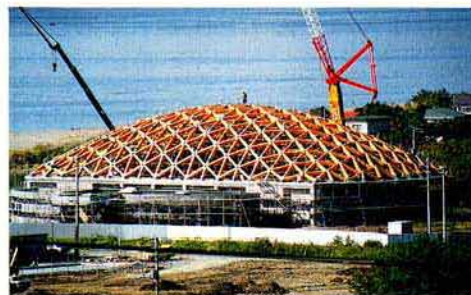
③支保工撤去して完成
