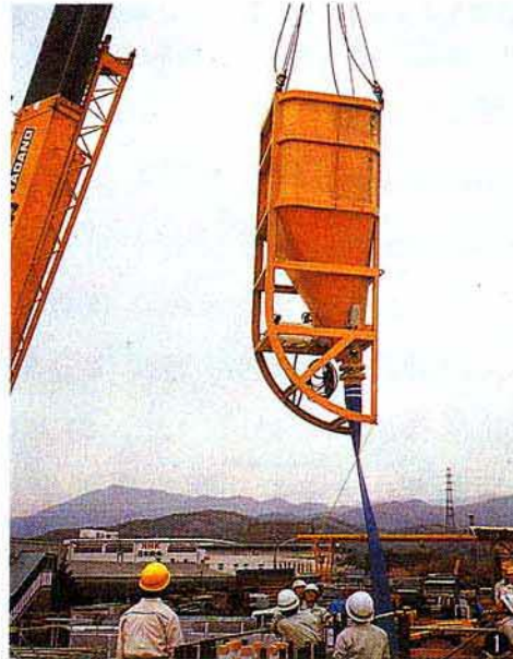
コンクリートバケット揚重
