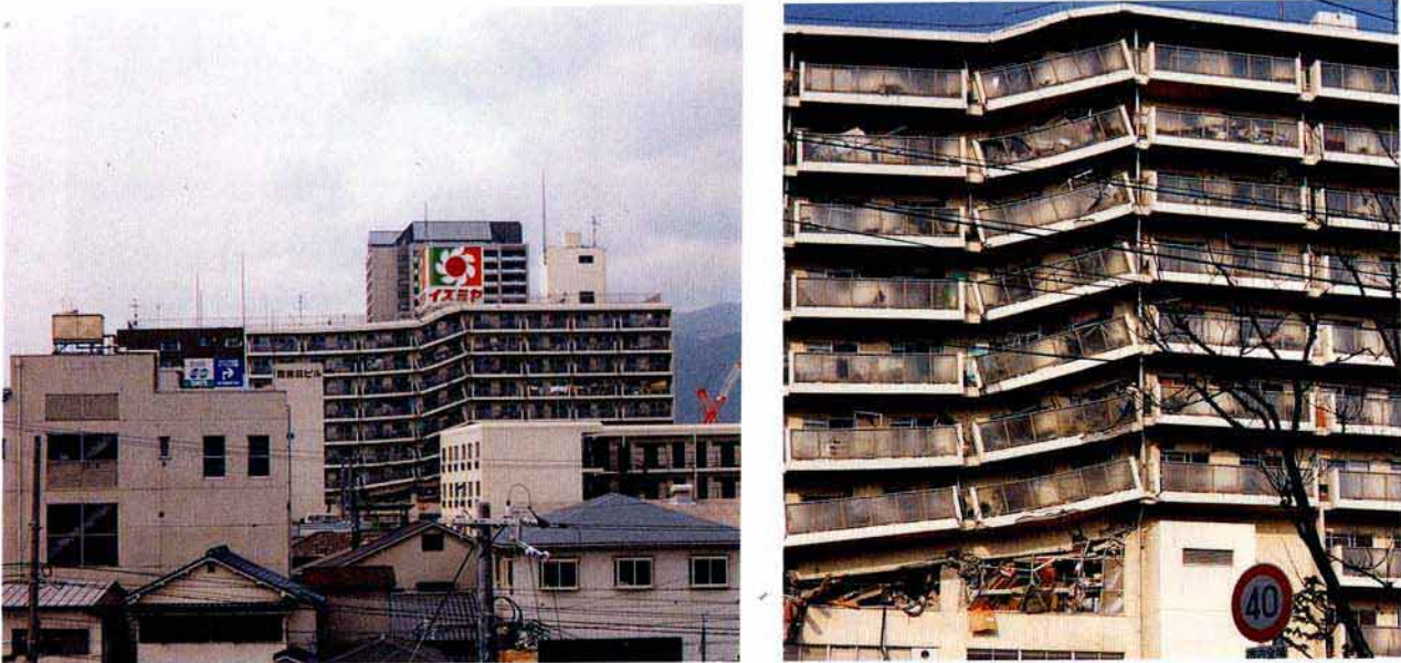
東側崩壊状況
