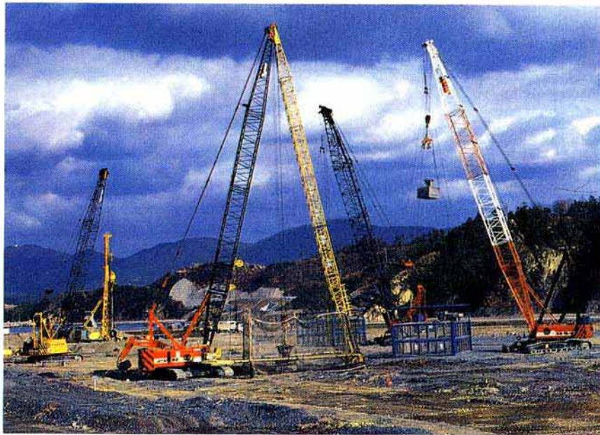
写真-3 三隅火力発電所での動圧密工法施工風景
