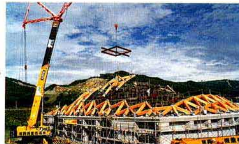
②ユニットによるドーム建て方
