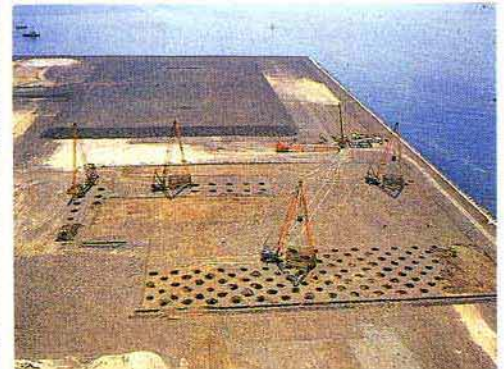
関西国際空港の地盤改良風景
