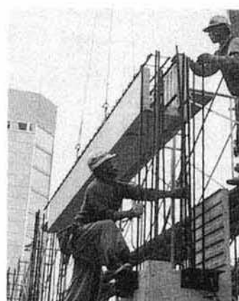
梁リブフォーム建込み
