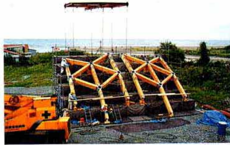
①特設ステージで建て方ユニットの地組
