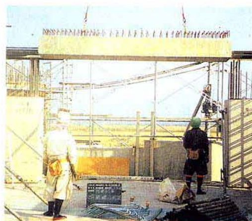
PC梁の吊り込み, セット
