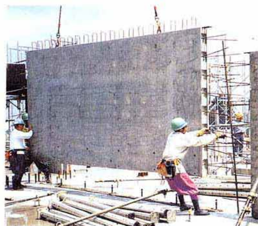
PC耐力壁の吊り込み, セット
