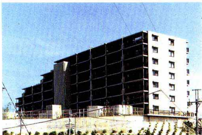
伊勢原住宅新築工事：Hi-W構法 地上7階 延床面積5,401㎡ 1991年6月竣工
