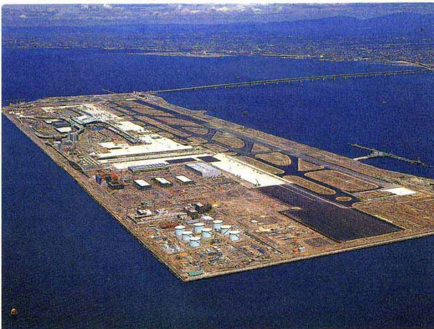
写真-1 関西国際空港 (滑走路を含む約 61 万 m 2 の岩砕埋立地盤を動圧密工法で地盤改良)
