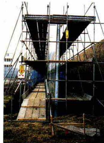
写真-2 スレンダーな壁部材の施工事例
