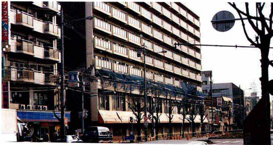
前面道路側層崩壊状況
