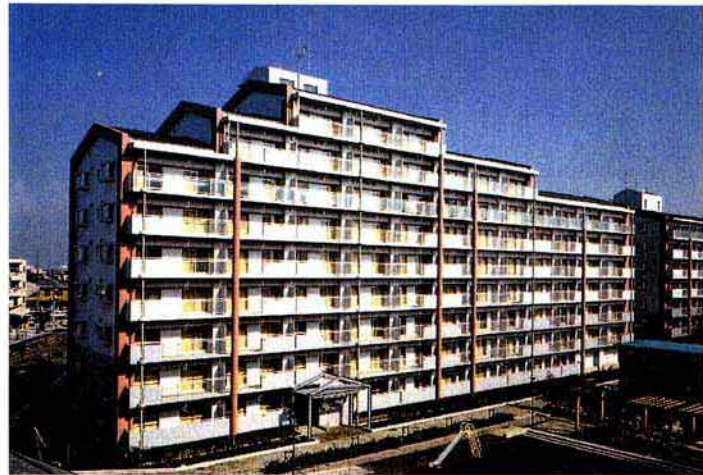
住公東新小岩建設工事：PARC-14構法 地上9階 延床面積5,291㎡ 1993年10月竣工
