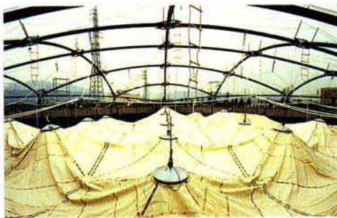
②膜体現場融着後リフトアップ
