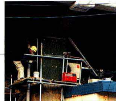
RC造柱の鉄板巻き補強
