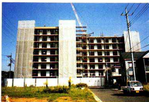
写真-3 草加手代町住宅建設工事 （フレキャスト型枠工法）
