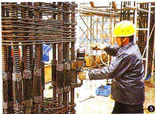
柱筋の継手工事
