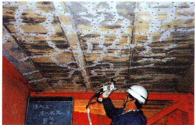
床板ヘアクラック注入(ADOX工法)
