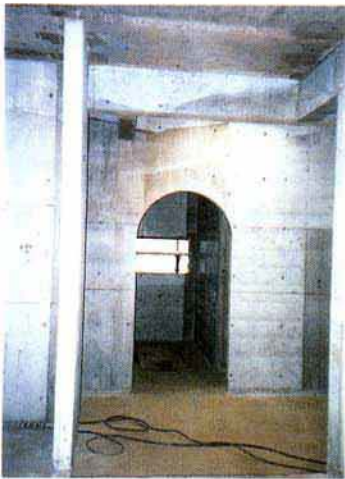
写真-1 薄壁のRC建物の施工事例
