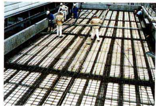
実施工時の締固め作業の省力化状況 (バイブレーター不要)
