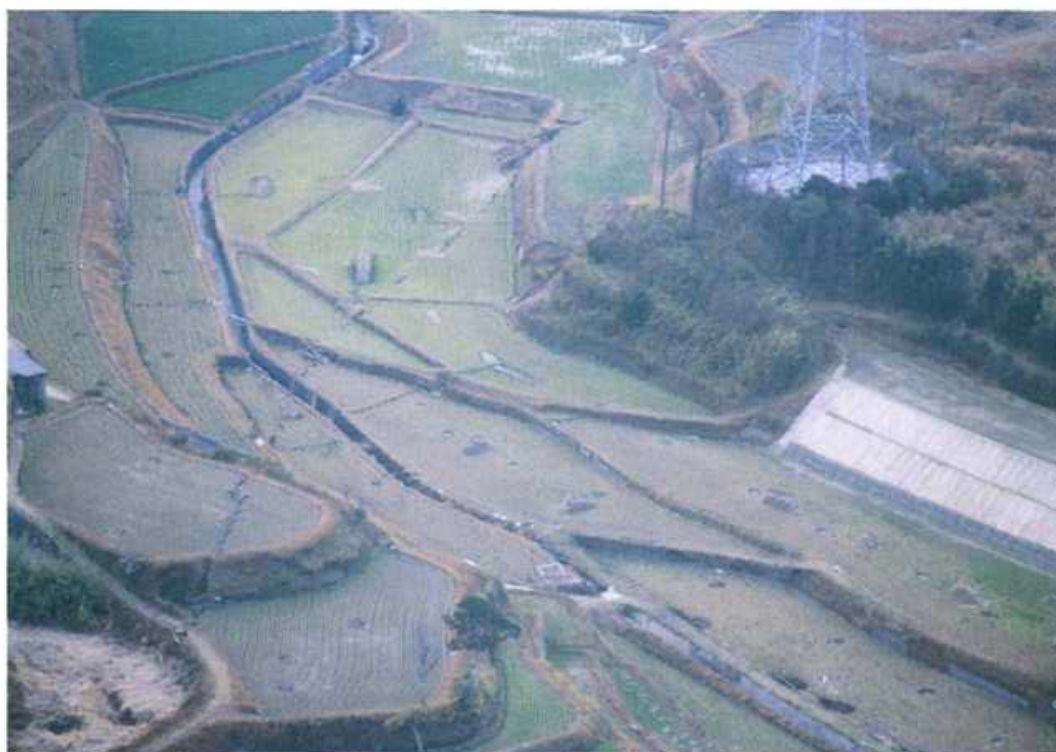
写真5 地表に現れた断層 (淡路島北淡町、航空写真)
