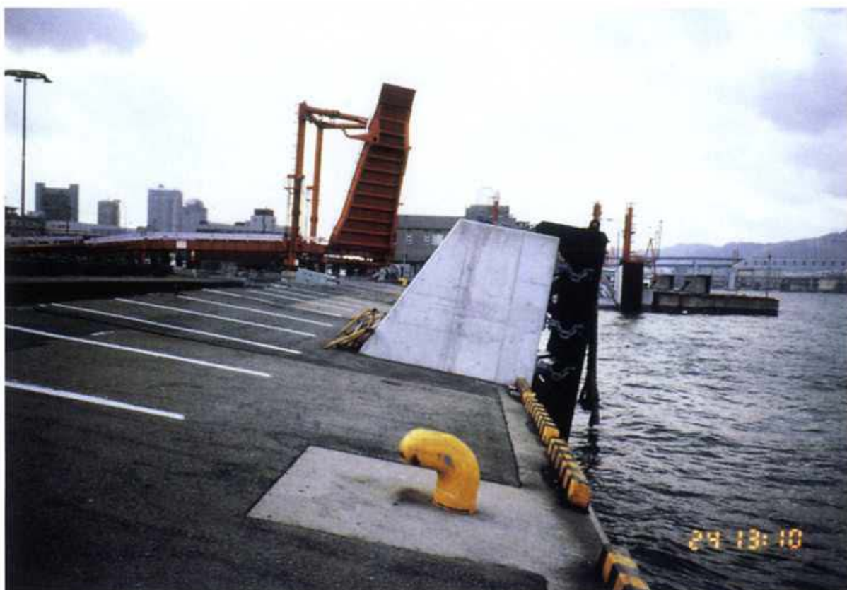
写真59 六甲アイランド東北端関西汽船フェリーバス (ケーソンの滑動・沈下・前ノメリの状態)
