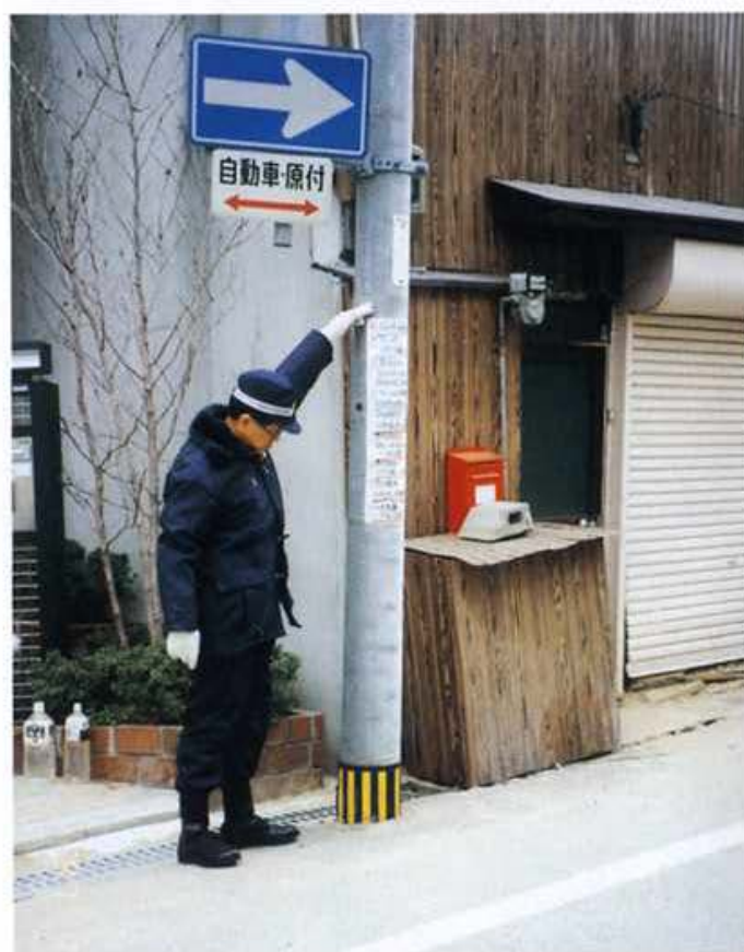
写真40 液状化による電柱の沈下
