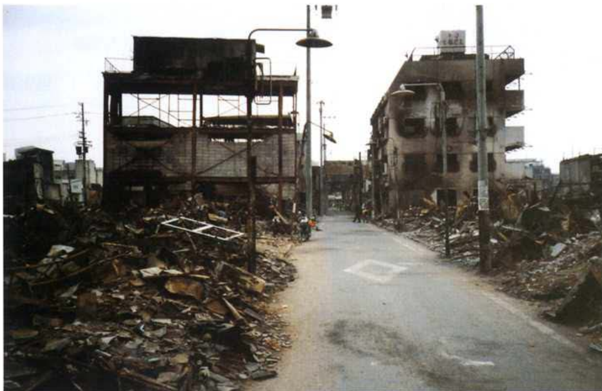
写真7 長田区の被災現場
