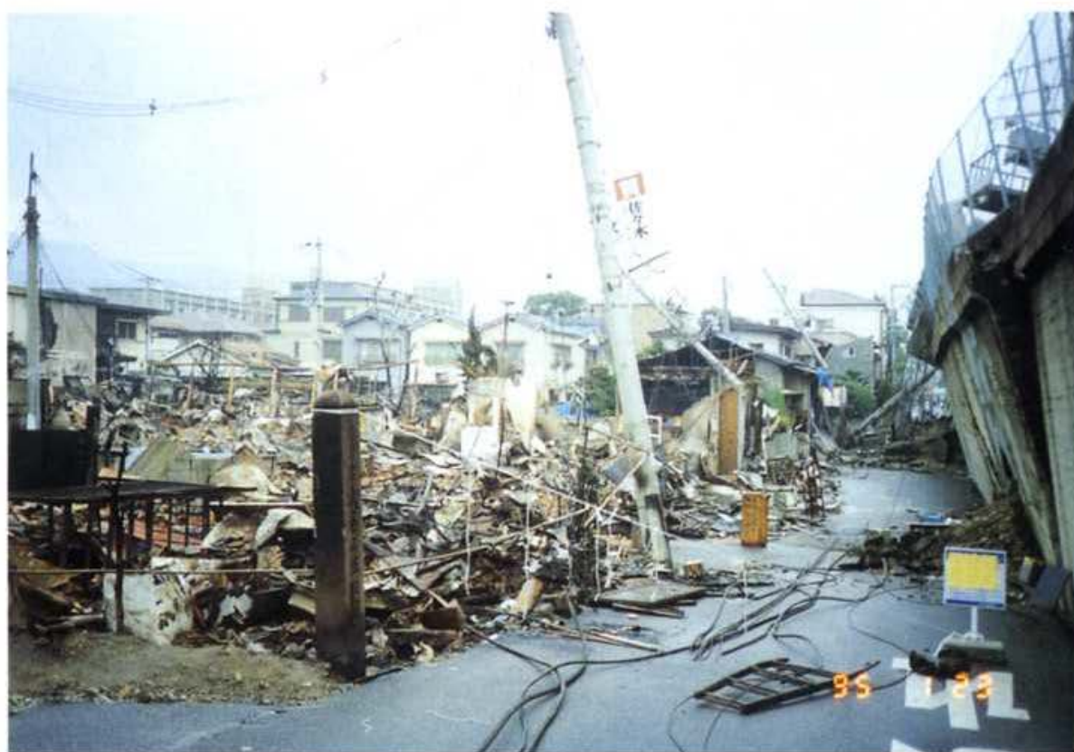
写真8 灘区の被災現場
