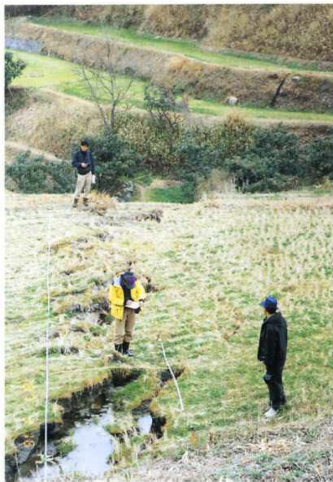
写真1 地表に現われた野島断層
