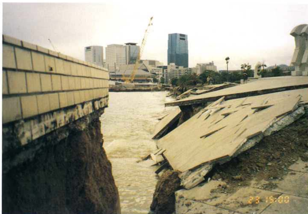
写真57 メリケンパーク南側ブロック護岸の崩壊
