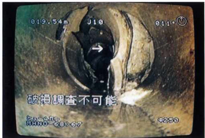
写真36 下水管内のテレビカメラ調査
