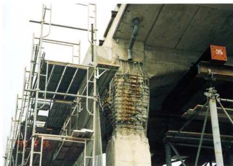
写真33 JR山陽新幹線の復旧（帯筋施工）
