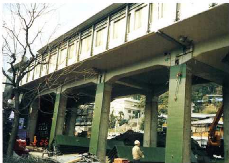
写真32 JR山陽新幹線の復旧（鋼板巻立て）
