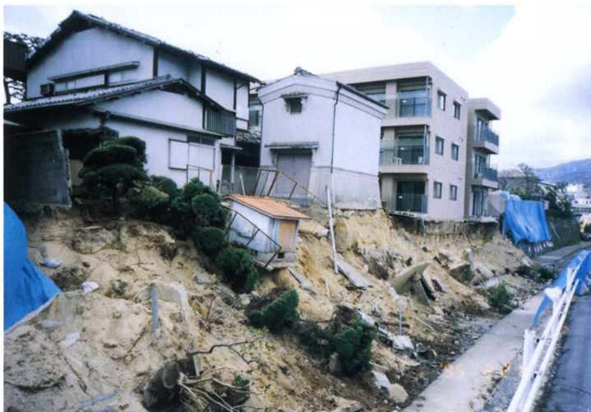
写真56 小仁川の住宅連胆地域の法面崩壊
