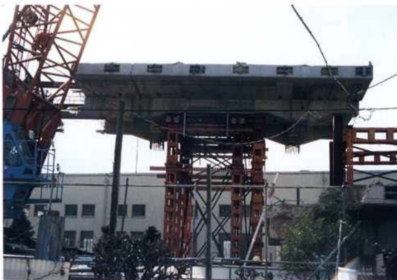
写真31 JR山陽新幹線の復旧（ジャッキアップ工法）
