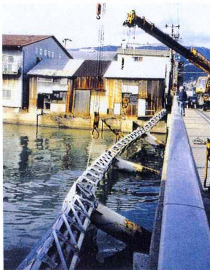
写真39 東灘線専用橋の被害
