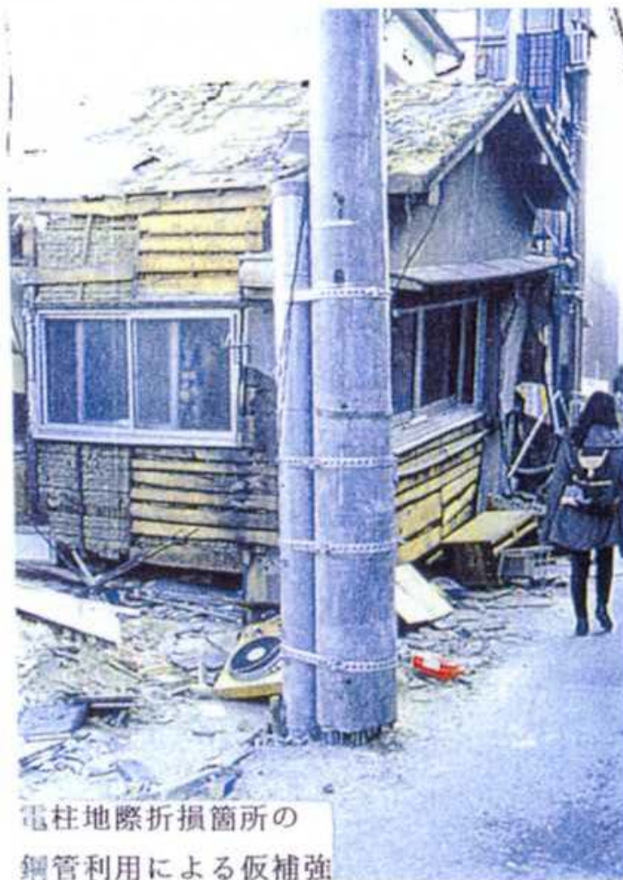
写真38 電柱の仮補強
