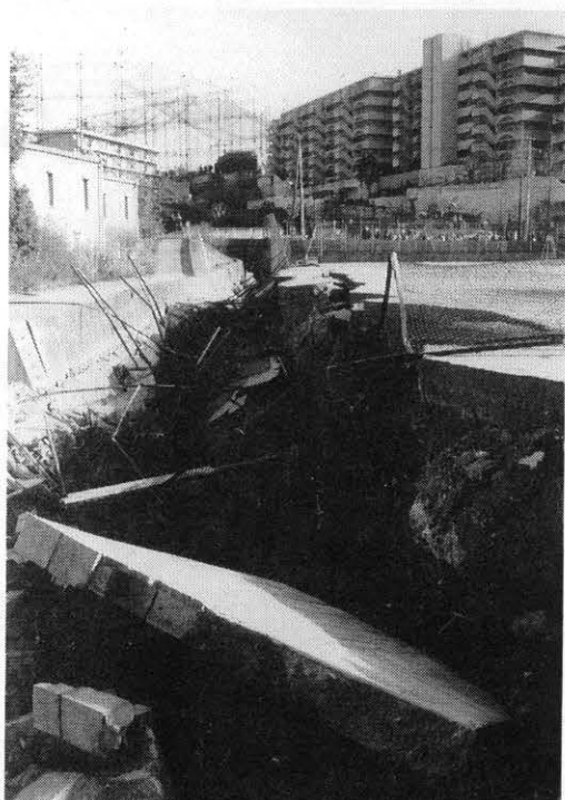
亀裂が入り陥没した テニスコート
