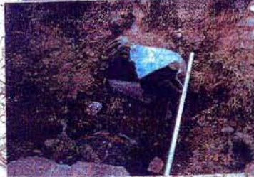
① 垂水区中道4丁目 (上图) φ800 割れ ② 東灘区御影本町 (下图) φ300 継手抜付
