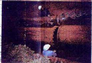
④ ポートアイランド (上图) SP φ600 断裂 ⑤ 中央区加納町6丁目 (下图) φ800、φ200 継手抜付
