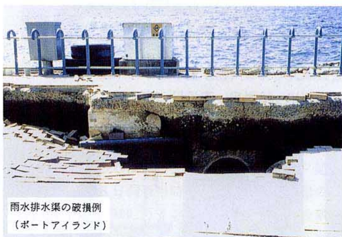
護岸が横にずれて大きな損傷を受けているが、排水溝は横にずれただけで大きな損傷を免れる
