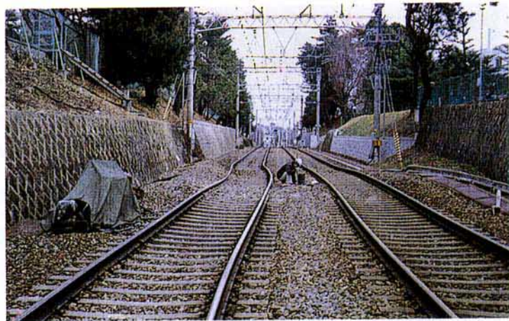
写真-10 岩園町の地すべり状況
