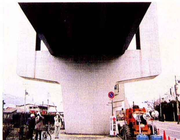
H 6 隣にある健全なRC橋脚
