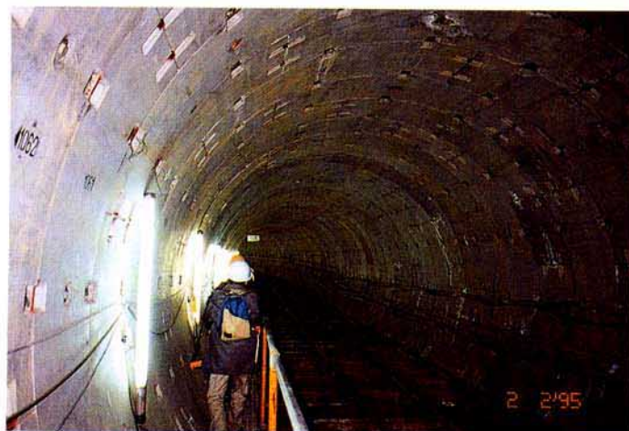
写真－11 関西電力磯辺通シールドトンネルの状況
