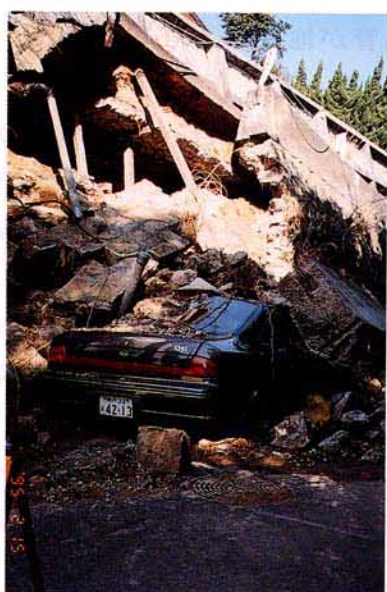
写真－３ 石積み擁壁の倒壊
