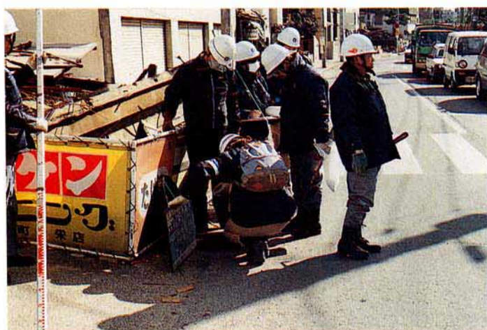
写真-17 下水管の調査
