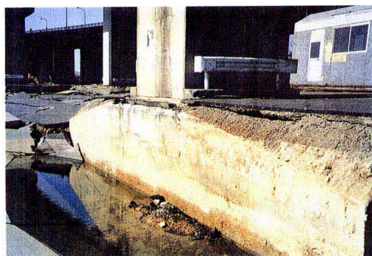
写真-14 第二摩耶大橋に連続する高架橋の基礎
