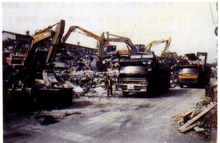
写真－2 建築系災害廃棄物の撤去現場
