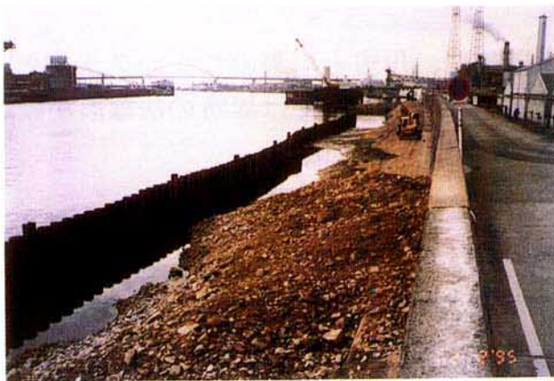
(a) 矢板による緊急漏水防止対策
