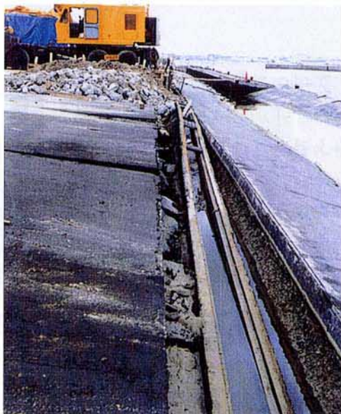
護岸が横にずれて大きな損傷を受けているが、排水溝は横にずれただけで大きな損傷を免れる
