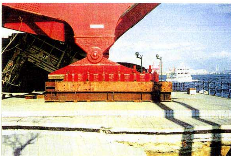
写真-8 神戸大橋の神戸側の支承
