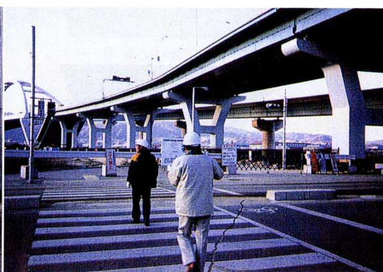
K 1 1 健全な湾岸線の鋼橋脚
