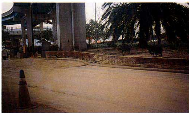
写真3 路面の波状変形（その2）
