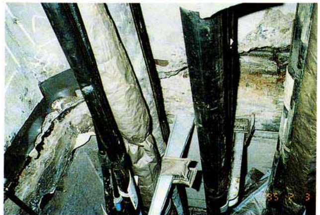
写真-7 エキスパンションジョイント部の 開口破損状況
