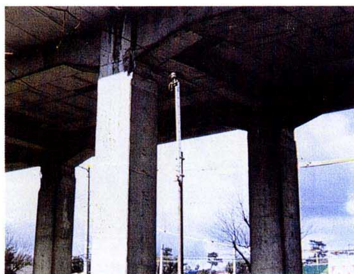
S 4 中間ばりを有しないラーメン高架橋 ハンチ直下での曲げ降伏
