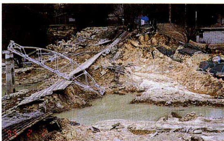
写真-12 ニテコ池堤防の被災状況
