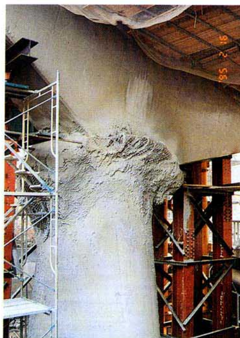
写真4 コンクリート製橋脚のモルタル吹き付け
