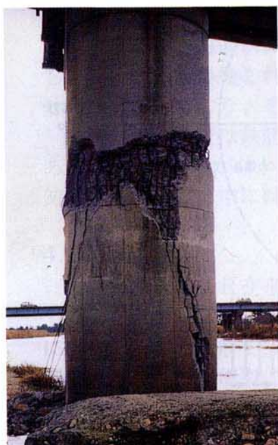
写真-1 矢印の先の柱がこの方向の面でせん断破壊している。
