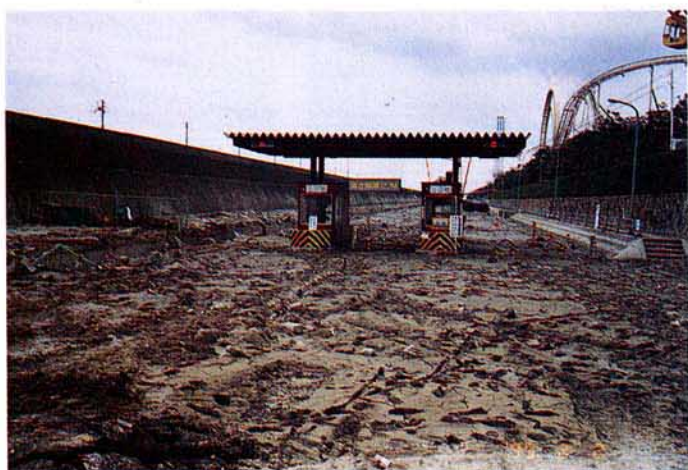
写真-13 ポートアイランドの液状化
