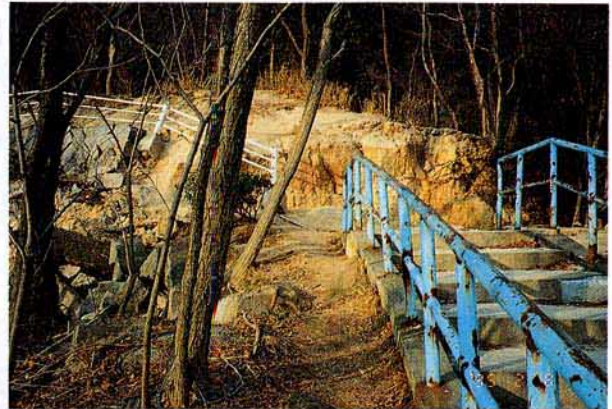
写真－2 灘区鶴甲地区の斜面状況
