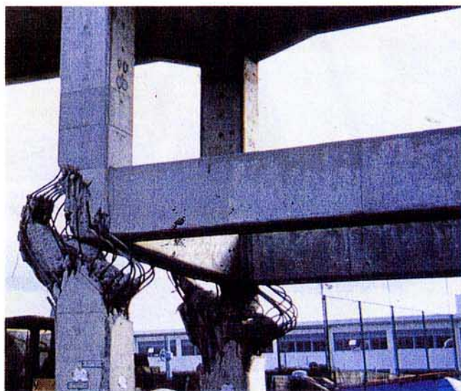
S 2 中間ばり直下のせん断ひびわれ
