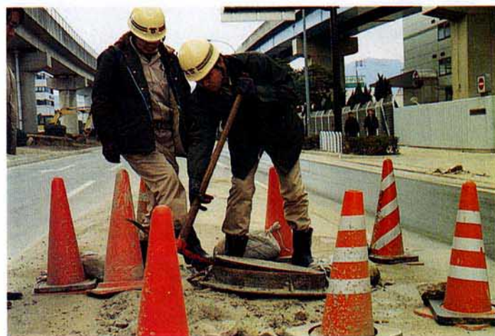
写真-18 下水管の調査
