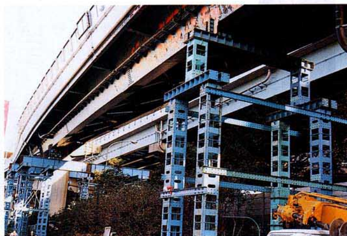
写真 8 上部工の落橋防止(1)
