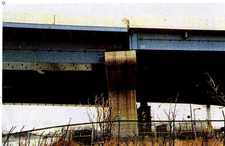
写真－5 新夙川橋の西宮浜側の橋脚
