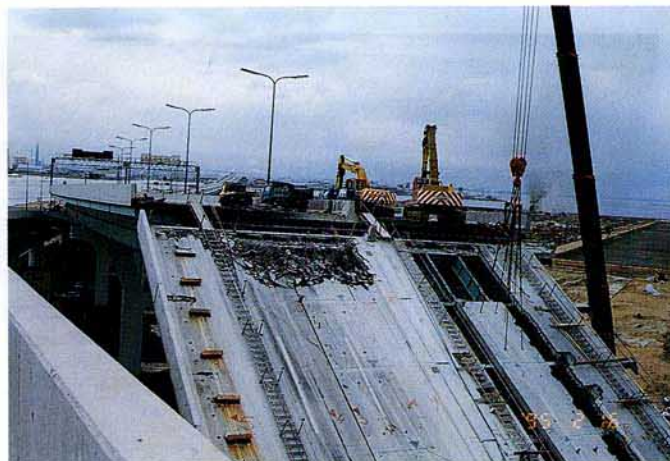
写真 12 西宮港大橋の側径間部の床版の撤去
