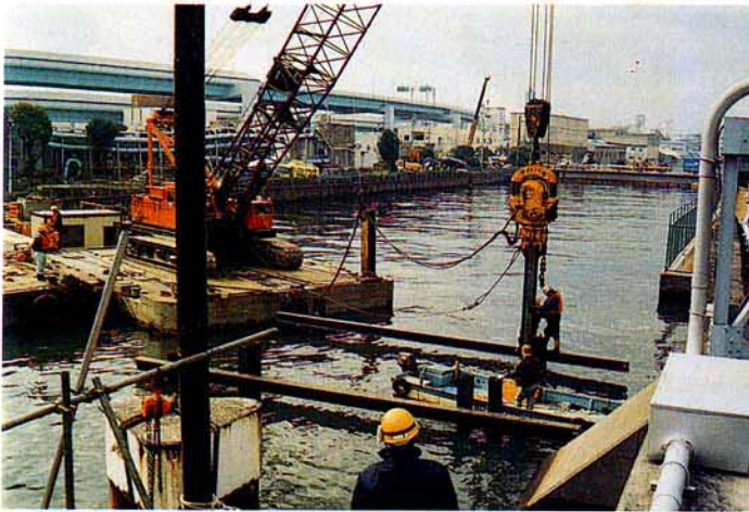
写真-7 運河の閉め切り工事
