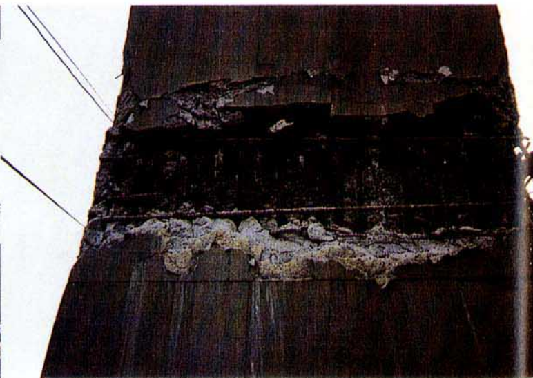
H 8 ガス圧接継手の破断、 不十分な帯鉄筋の定着
