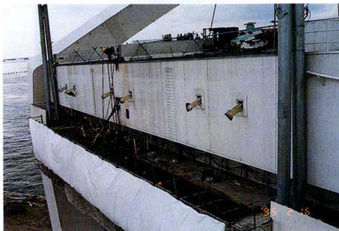
写真 11 西宮港大橋の側径間の修復状況
