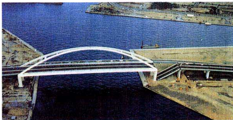
写真-1 西宮港大橋の甲子園浜側における桁の落下現場
