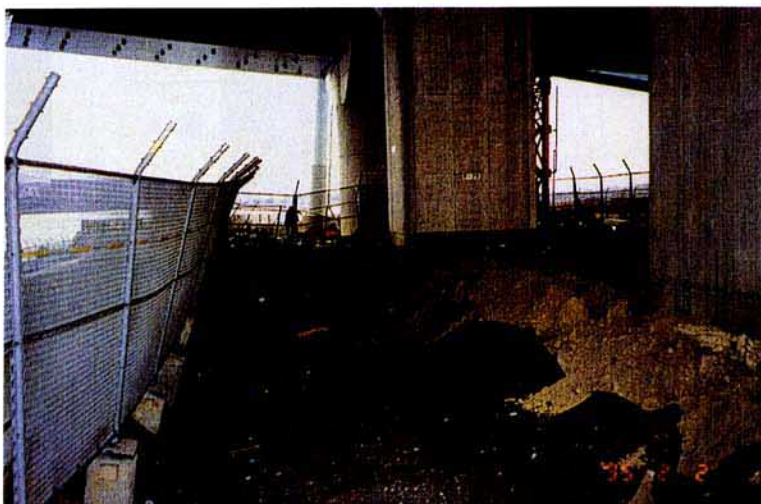
写真－7 護岸と橋脚の間の地盤状況
