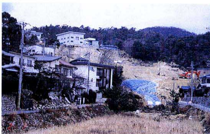
写真-7 仁川の地すべり崩壊全景
