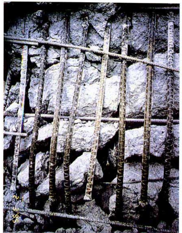
H 1 0 離れた位置における圧接部の破断
