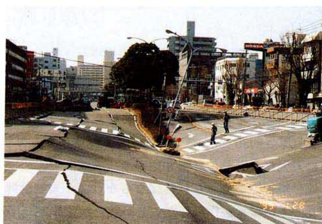
写真-4 大開駅地表面の道路陥没状況
