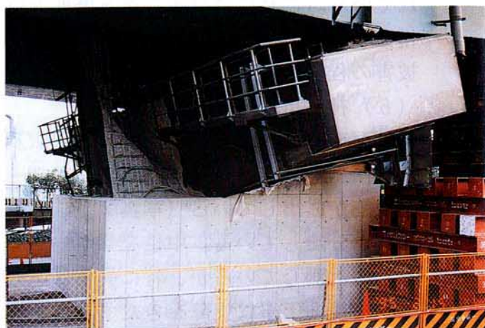
写真 6 コンクリート製橋脚の倒壊防止(2)
