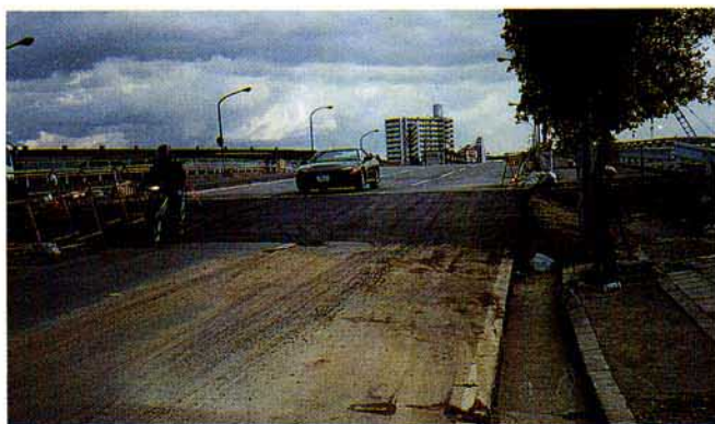
写真1 橋台背後の路面すり付け状況
