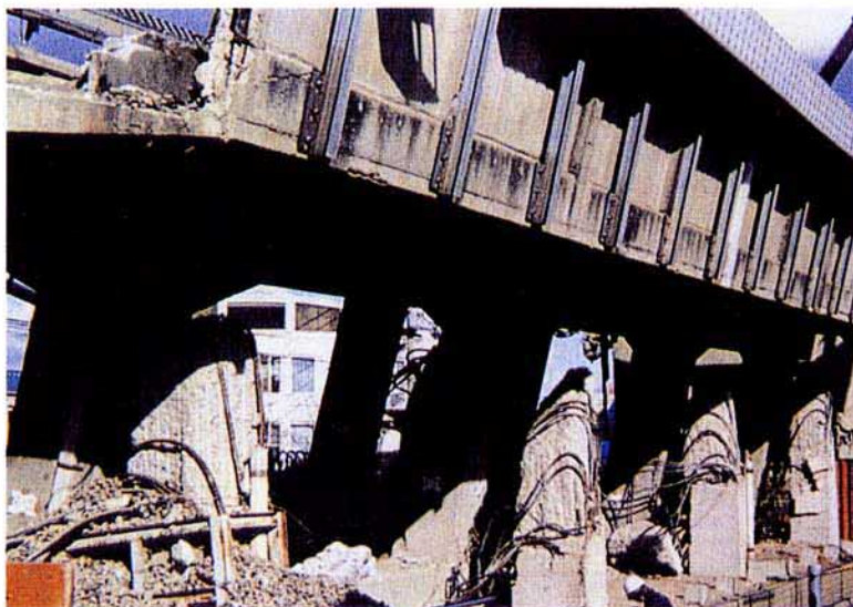
S 3 上部が橋軸直角方向北側に落下
