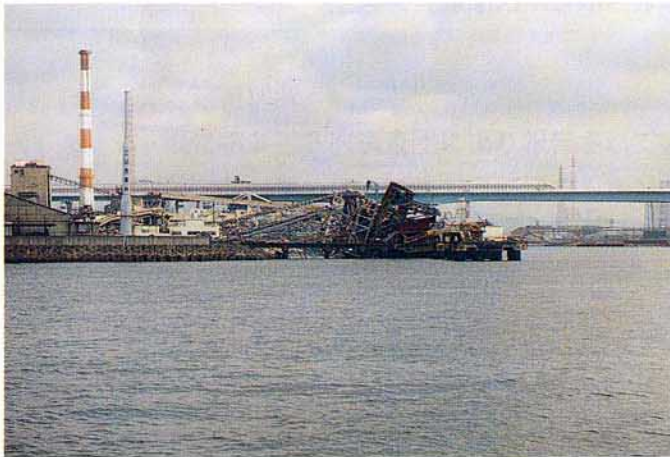
写真-3 尼崎港内におけるクレーン倒壊
