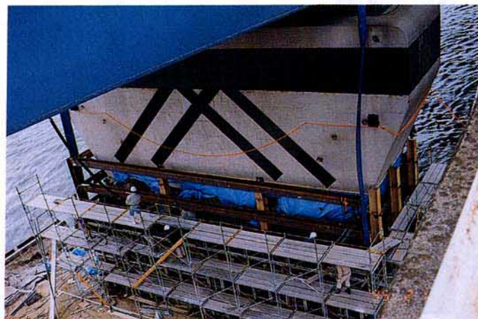
写真 20 第2摩耶大橋の橋脚部の修復
