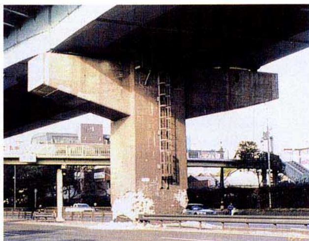
K 5 矩形断面の橋脚 曲げ降伏
