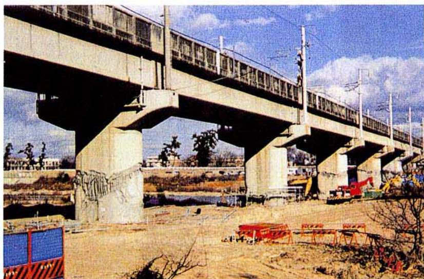
S 9 武庫川橋梁小判型橋脚の全景
