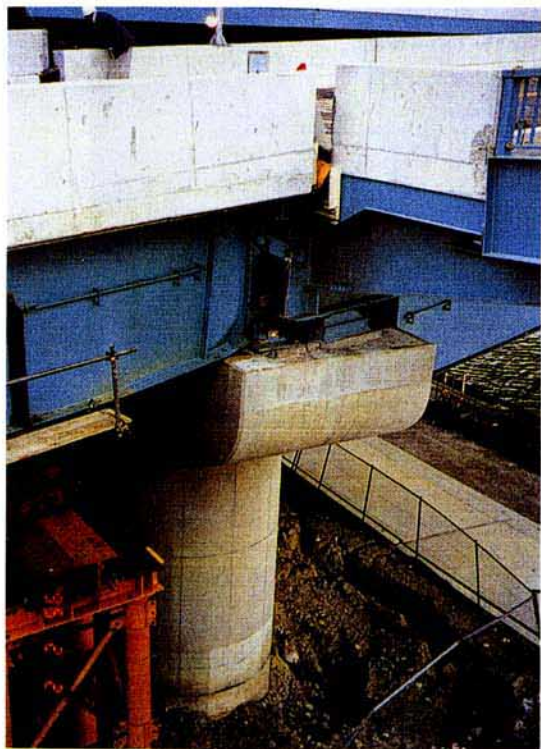
写真－6 橋梁端とそれに連続する桁との連結部分
