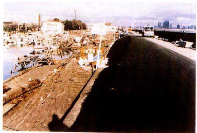
(b) 緊急復旧後の堤防天端の状況
