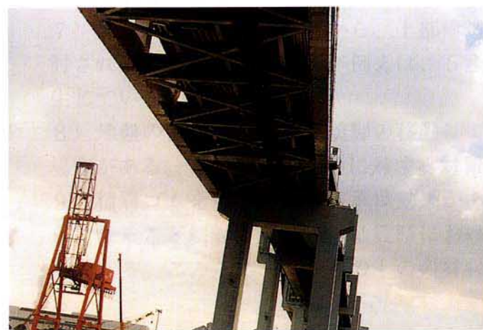
写真 15 六甲アイランド大橋の橋軸直角方向の移動
