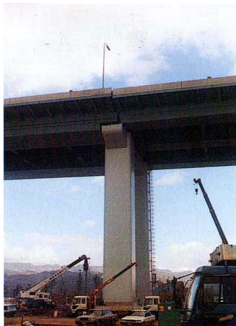
写真-7 阪神高速湾岸線橋梁基礎の 水平移動（南芦屋浜埋立地西護岸）
