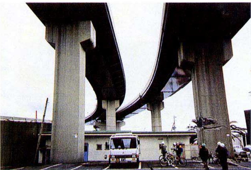
H 7 高さの高い単柱式橋脚の被害 段落とし部での鉄筋降伏
