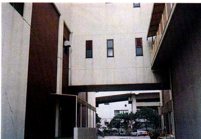
写真-11 ポートアイランド下水処理場
