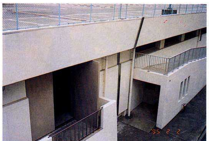
写真-12 ポートアイランド下水処理場
