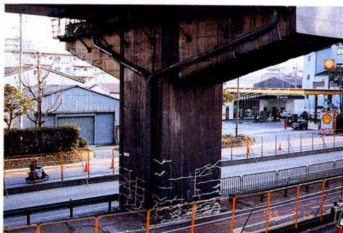
写真2 コンクリート製橋の樹脂注入による修復
