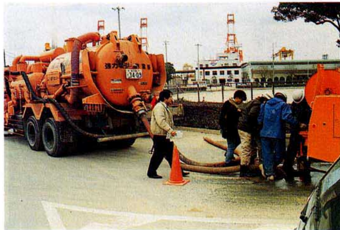
写真-16 下水管の調査
