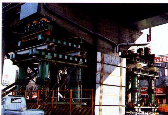
写真3 コンクリート製橋脚の修復
