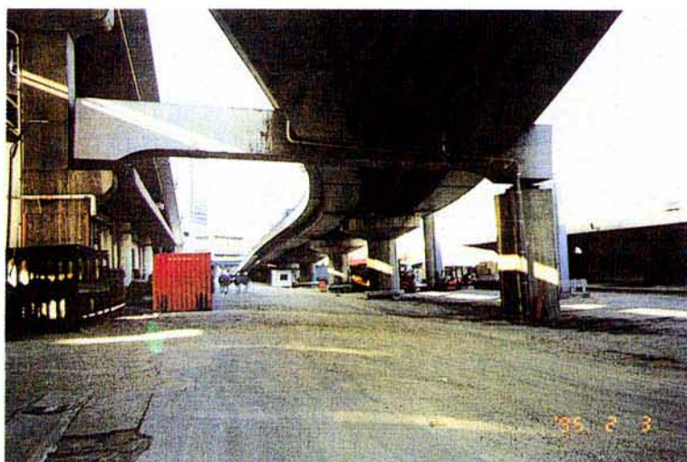
写真-11 神戸大橋に連続する高架橋の橋脚
