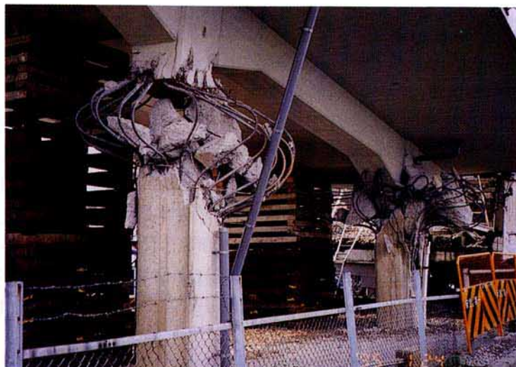
写真-2 写真-1の状態が進行してずれ落ちた状態
