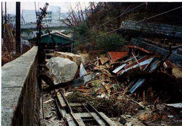
写真－1 六甲ケーブル土橋駅の落石
