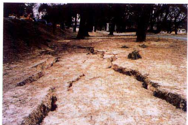
(b) 高水敷の地割れ
