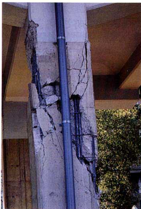
写真-1 矢印の先の柱がこの方向の面でせん断破壊している。
