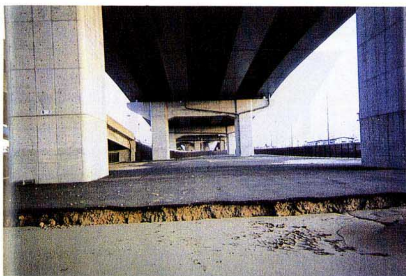
K 1 0 健全な湾岸線のRCラーメン橋脚
