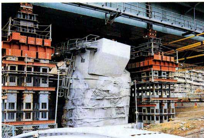
写真 5 コンクリート製橋脚の倒壊防止(1)
