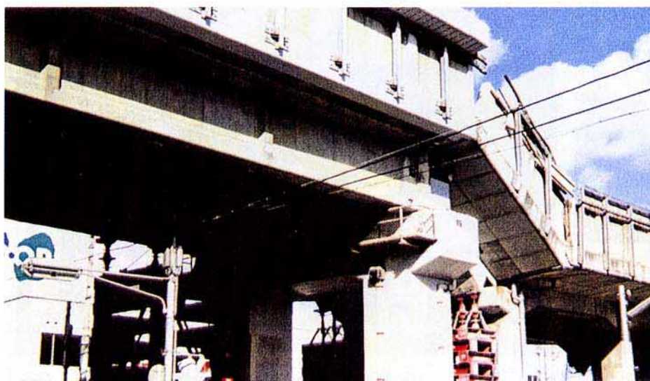
S 8 PC 桁を支える健全なラーメン橋脚
