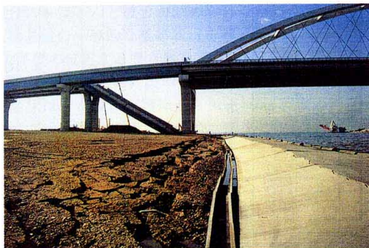
写真-2 橋脚の前面の護岸の状況
