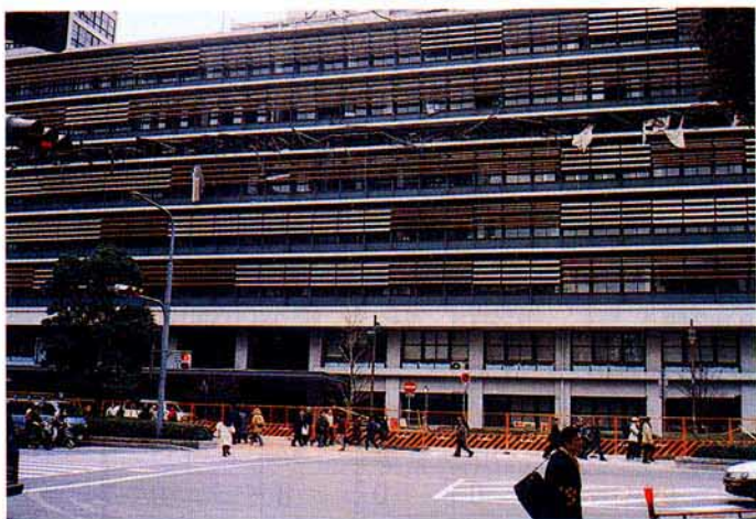
写真－1 被害を受けた神戸市第二庁舎
