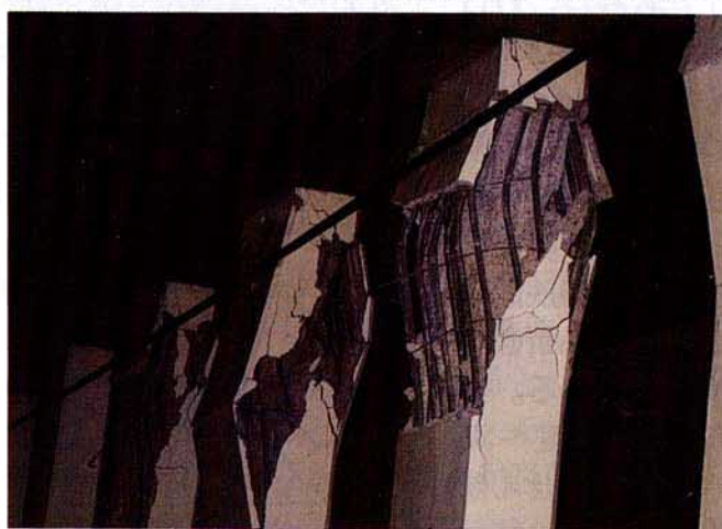
写真-4 矢印の先の柱がこの方向の面でせん断破壊している。
