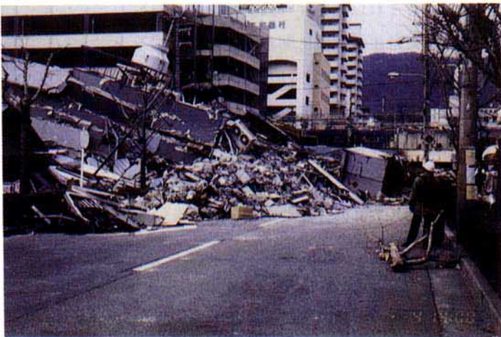
写真－1 倒壊した駐車場ビルにより通行不能な街路（JR芦屋駅前）
