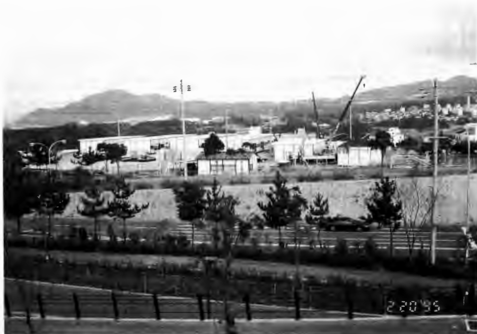
兵庫県病院付近に建設中の仮設住宅
