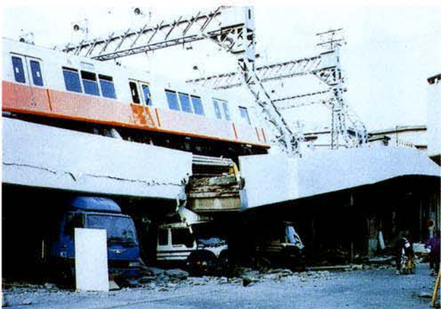
写真11 阪神電車高架橋の倒壊状況
