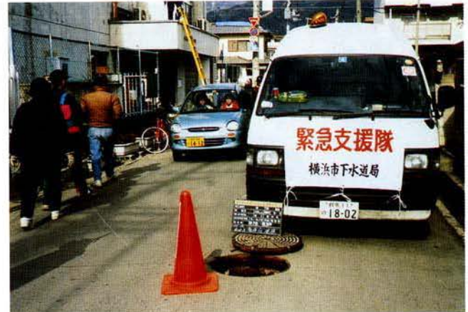
写真72 大都市の管路施設被害調査支援隊の作業状況（東灘区）
