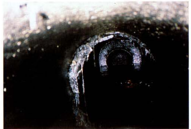
写真37 西部処理場エアレーションタンク流入管の破壊
