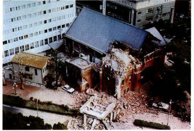
写真5 中央区の教会の倒壊状況
