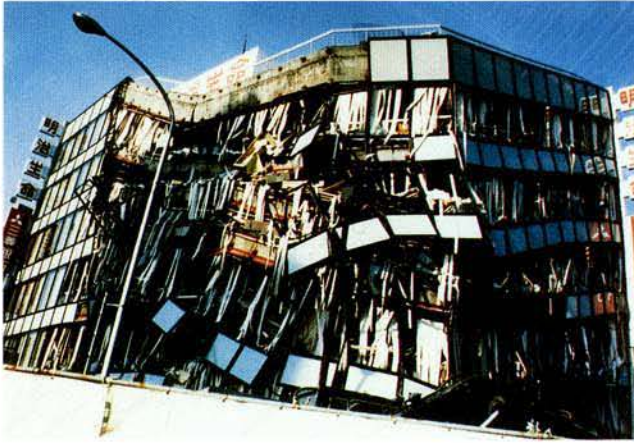
写真1 ビルの倒壊状況
