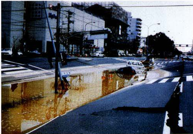
写真63 高速鉄道（地下鉄）大開駅の崩壊による路面の沈下
