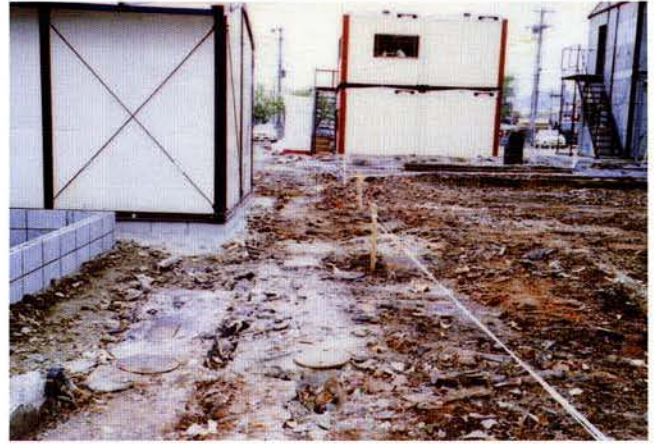
写真77 共同排水管の被災状況（須磨区）
