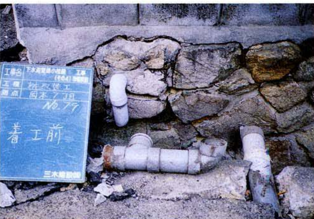
写真80、81 排水設備（取付部）と接続ますの損壊（東灘区）
