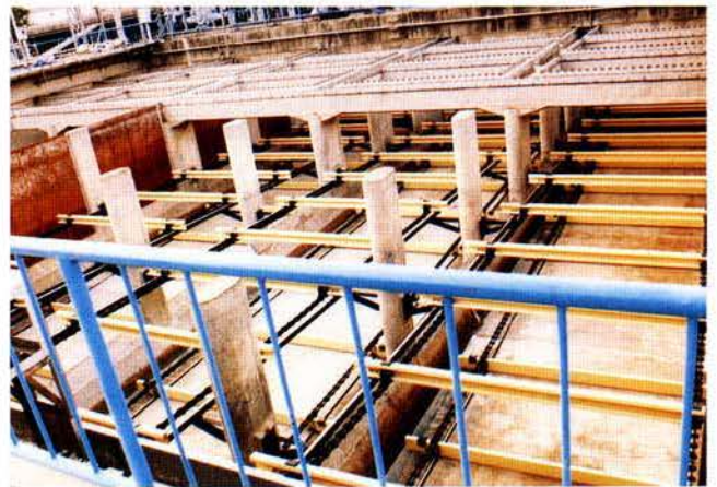
写真49 東灘処理場最終沈殿池の復旧状況
