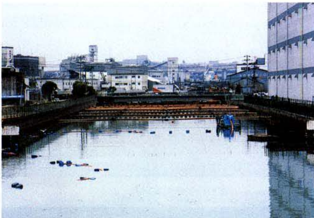
写真45 東灘処理場仮処理施設の仮設沈殿池
