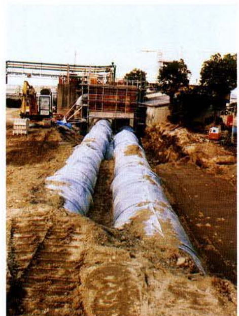
写真50 東灘処理場最初沈殿池流入管の復旧状況
