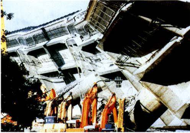
写真9 阪神高速道路高架橋の倒壊状況
