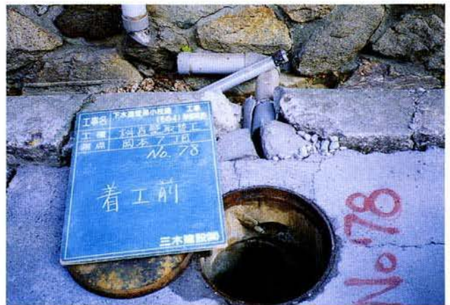
写真80、81 排水設備（取付部）と接続ますの損壊（東灘区）
