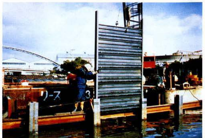
写真43 東灘処理場仮処理施設締切り板の設置状況
