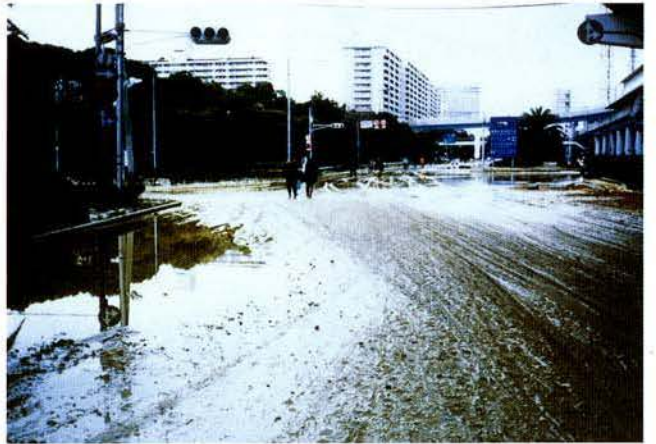
写真7 ポートアイランドの液状化の状況
