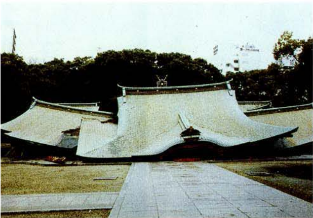
写真4 三宮生田神社社殿の倒壊状況
