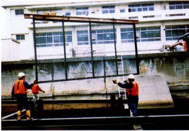
写真44 東灘処理場仮処理施設スクリーンの設置
