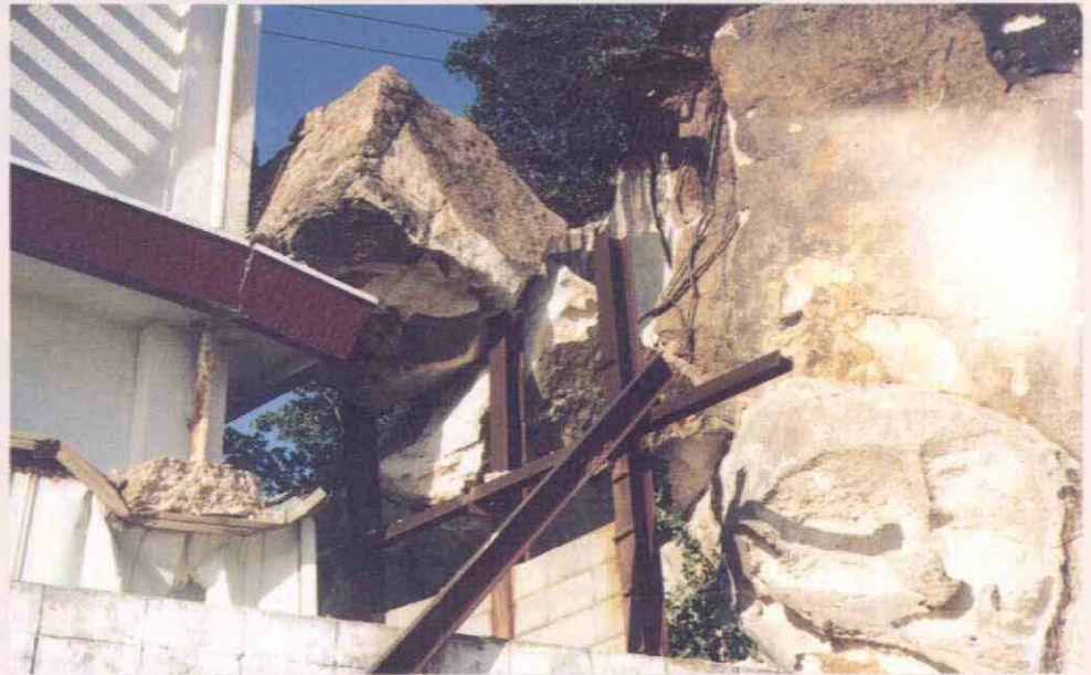
▲民家の庇を直撃した巨大な転石(県民サンビーチの裏山で)
