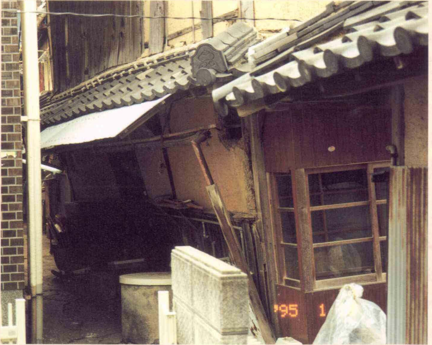
▲隣家にもたれかかるように 倒れ込んでいる民家(東の町地区)
