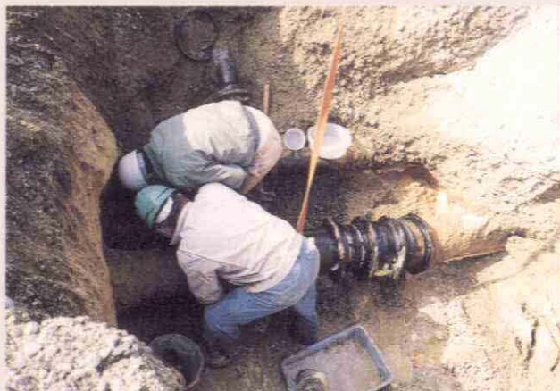
地震発生直後から上水道の復旧作業が続けられた
