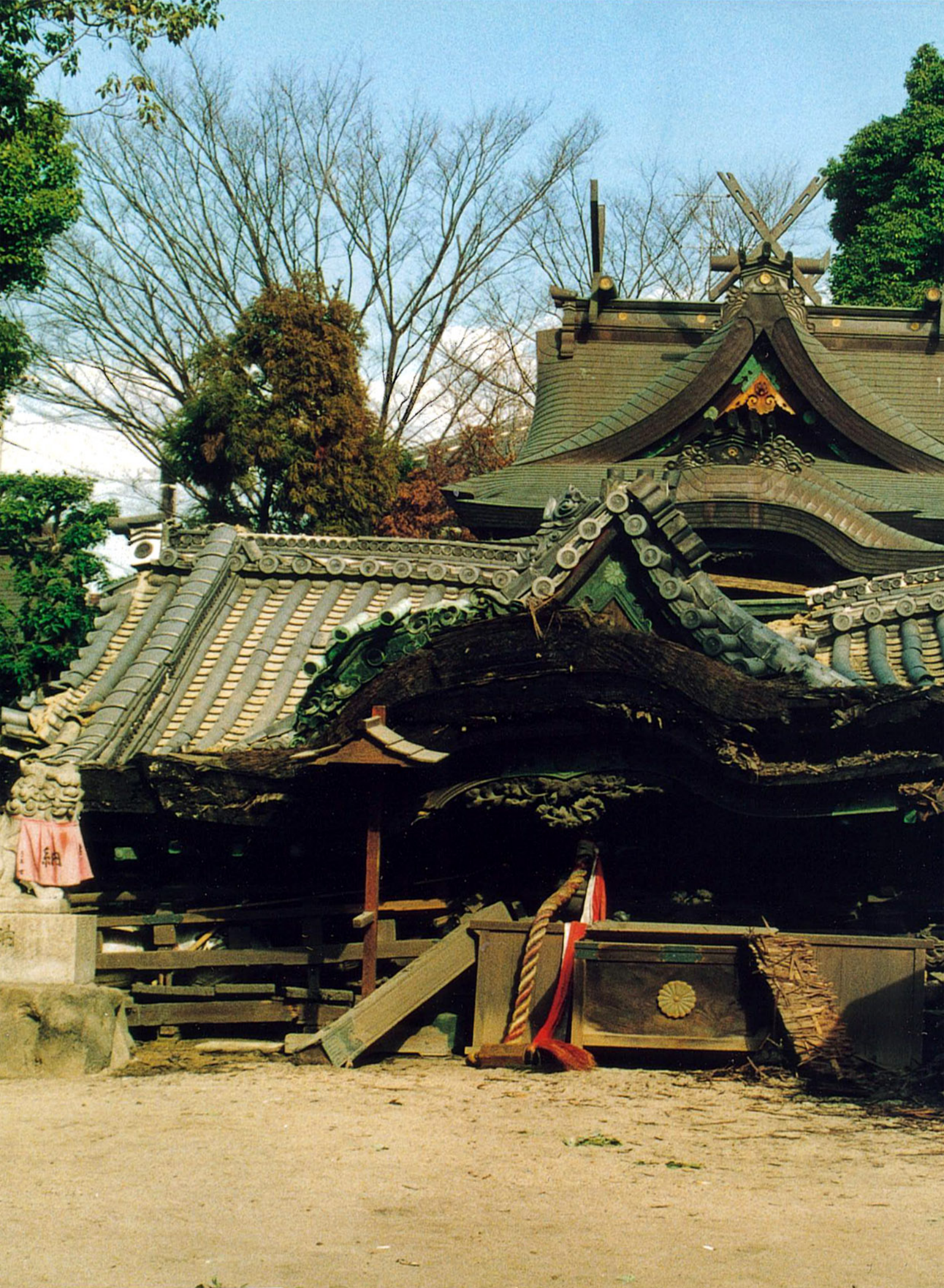
全壊した築地南浜1丁目の初島神社
