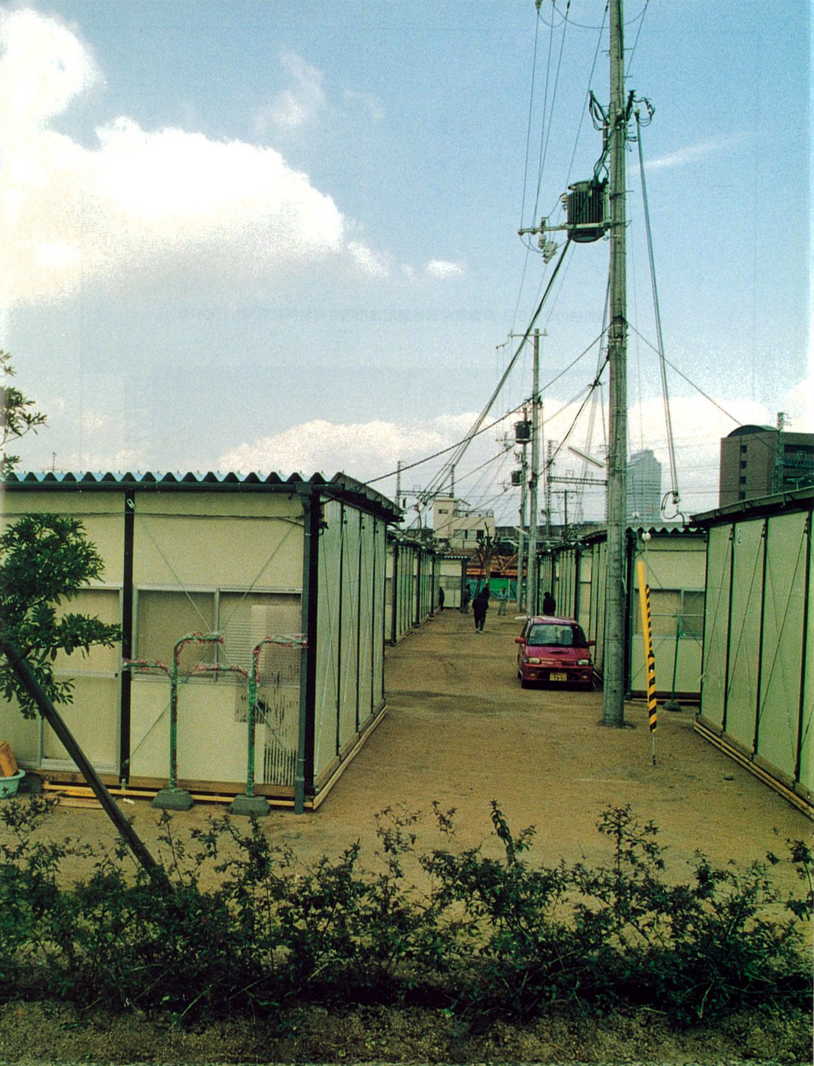
市内50か所に2,218戸の仮設住宅を建設
