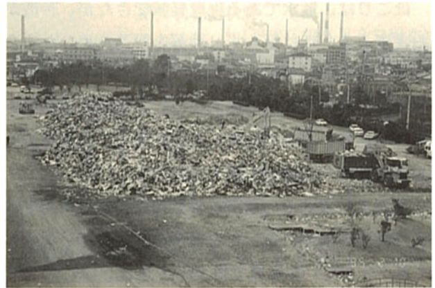
震災大型ごみの仮置
