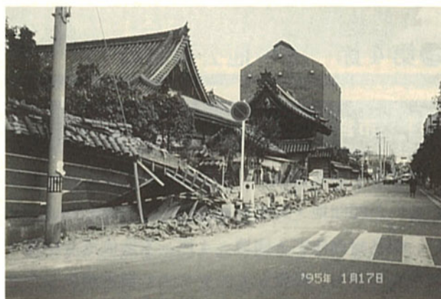
本興寺（寺町地域内）の被害
