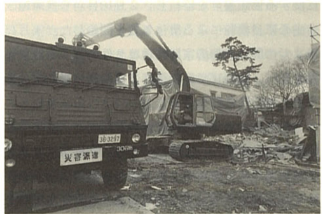
自衛隊による解体
