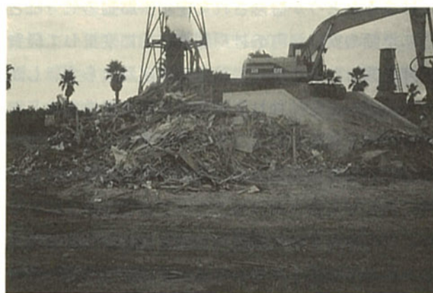
仮設焼却炉(その2)の作業
