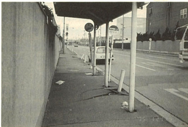
高洲バス停留所の被害
