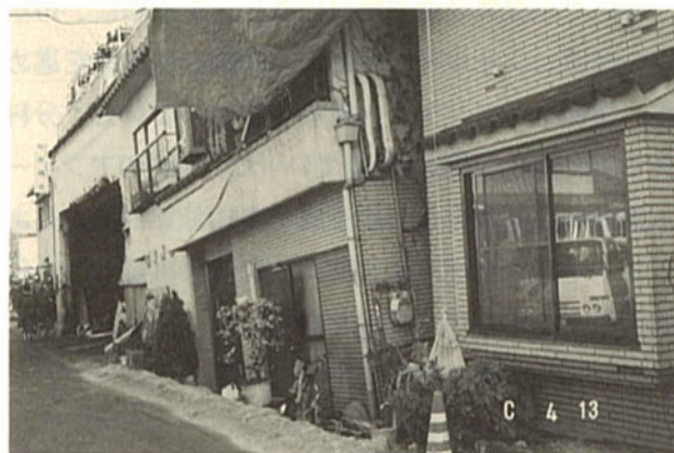
液状化で傾いた家屋
