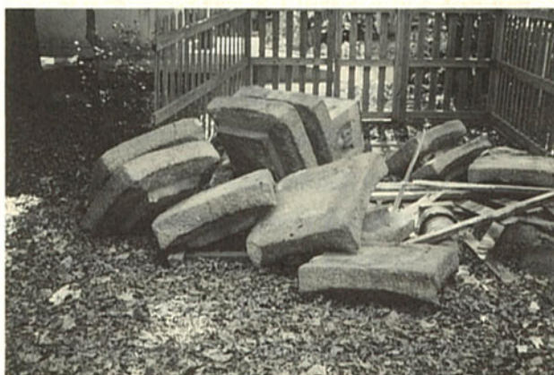
崩壊した十三重塔（西武庫須佐男神社）
