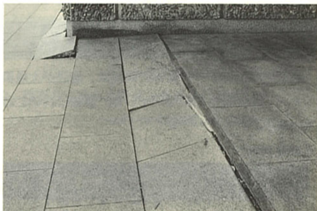
ホール棟1階コンコース正面玄関前
