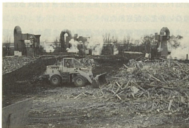
仮設焼却炉(その1)の作業
