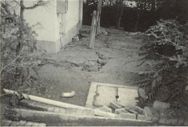
環境事業部での地盤沈下の状況
