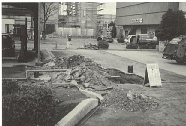
環境事業部での上水の仮配管施工
