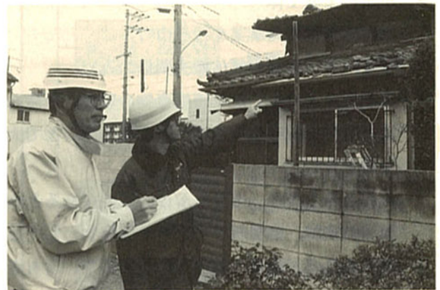
応援職員による損壊度調査
