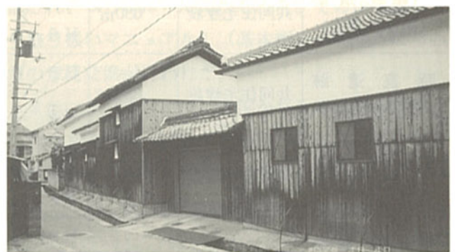
形成建築物の修復
