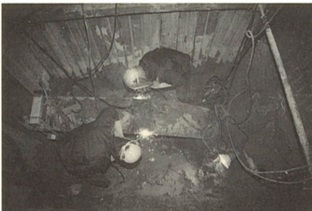
配水管工事現場
