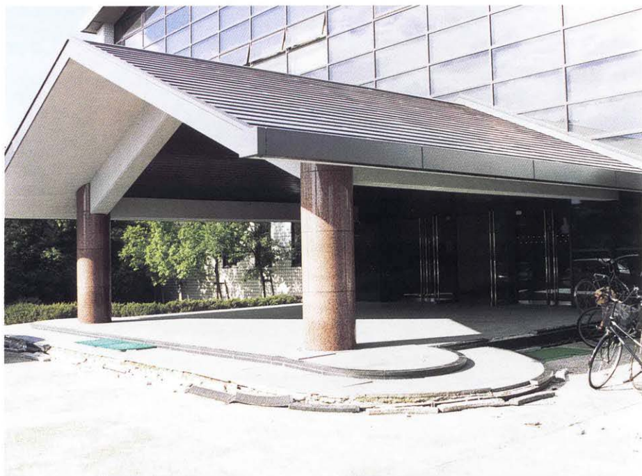
体育館正面入口
