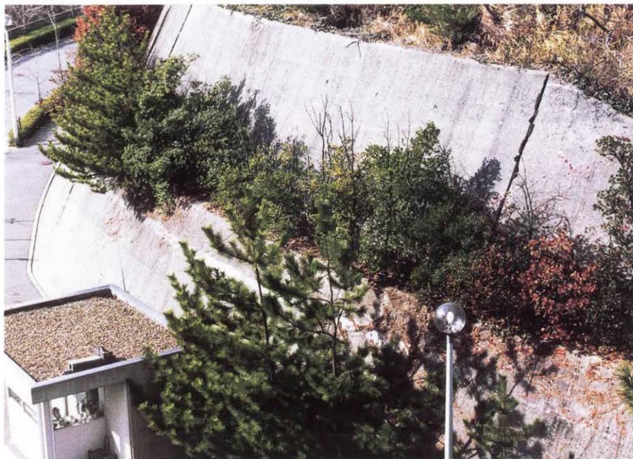
守衛室上部のコンクリート壁
