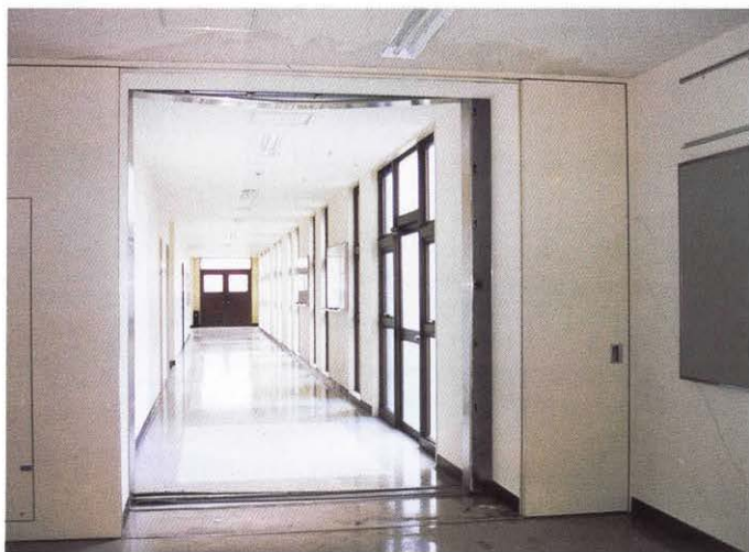
東校舎第二棟と第三棟の接合部
