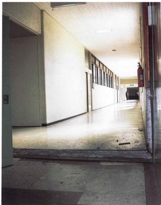
芸術棟と体育館奥の接合部
