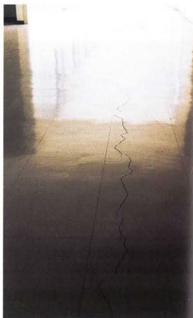
研究室棟三階廊下
