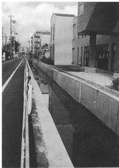
森具川（改修後） 1996. 12. 1
