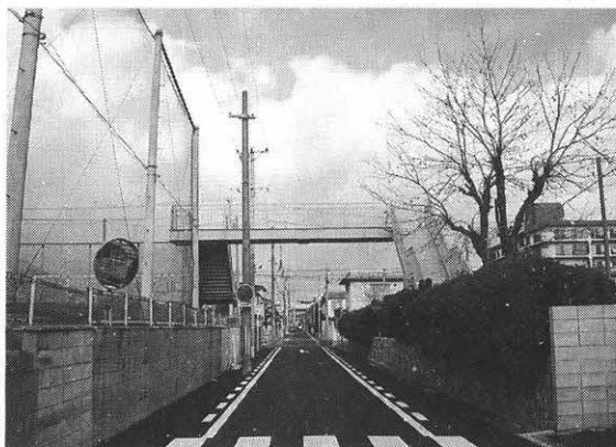
オーバブリッジグランド・西校舎ー 1996. 12. 1
