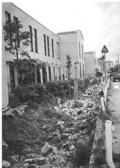
森具川改修工事 1996. 3. 21
