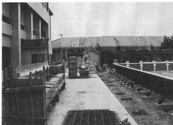
プール工事中 1995. 5. 20
