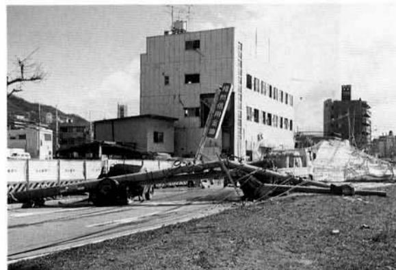
足場が倒れ電柱の直撃を受け破壊された車両（神戸市東灘区内）
