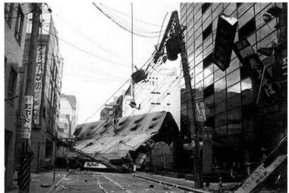
倒壊し道路を塞いだビル（神戸市中央区内）
