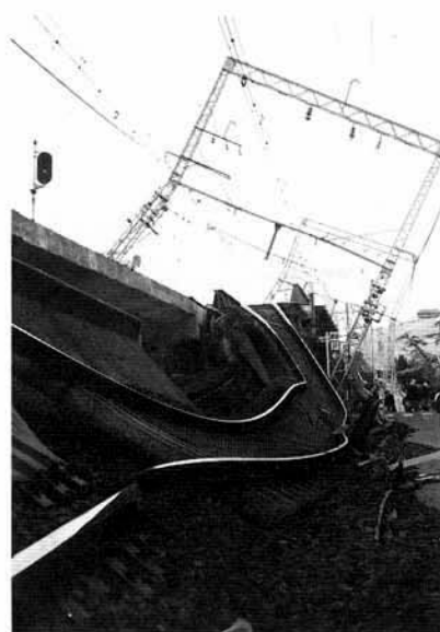
阪急電鉄 高架の倒壊（西宮市内）
