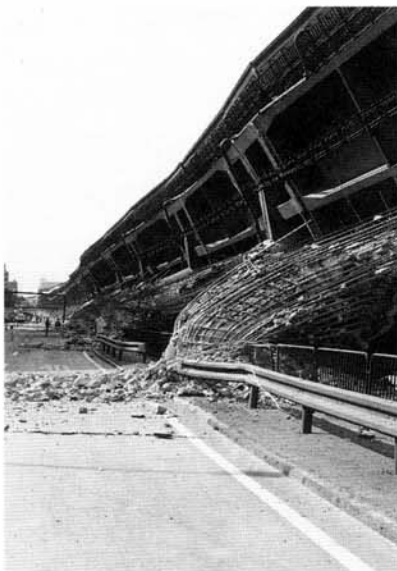
阪神高速3号神戸線の倒壊（神戸市東灘区内）
