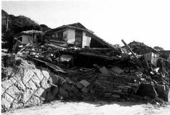
木片の山と化した家屋（淡路北淡町内）
