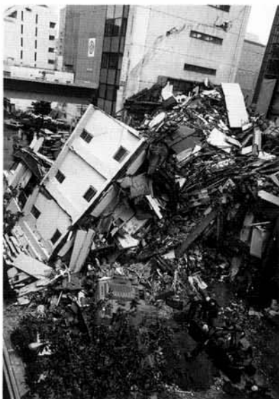
倒壊したビル (神戸市中央区内)
