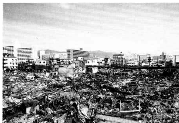
長田区の火災跡
