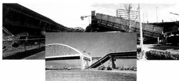
倒壊・脱落した高速道路
