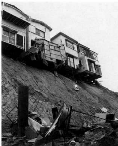
地震による崖崩れ
