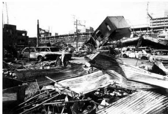
ガレキの山と化した火災跡(神戸市長田区内)
