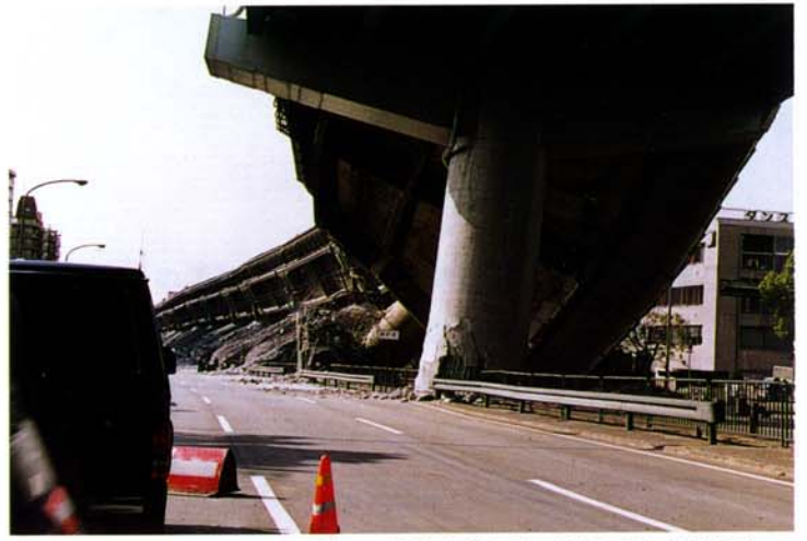
倒壊した阪神高速道路3号神戸線（東灘区）
