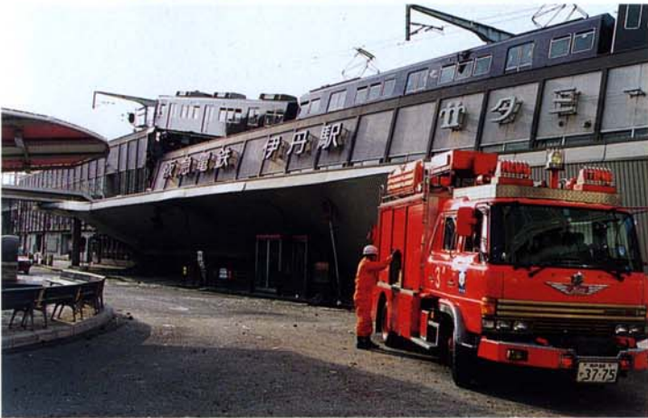
倒壊した阪急伊丹駅（伊丹市）
