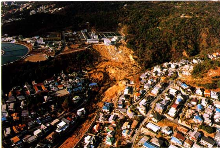
地滑りを起こした住宅地（西宮市仁川百合野町）
