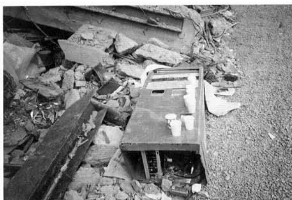
倒壊したパーキング・チケット発給機器
