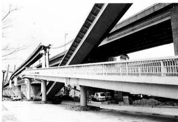
落下した六甲ライナーの高架橋 (神戸市東灘区六甲アイランド内)
