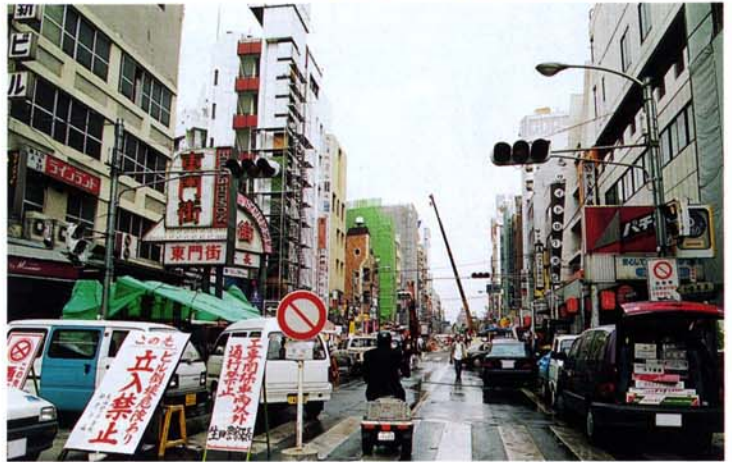
ビルの倒壊が激しい生田新道（中央区）
