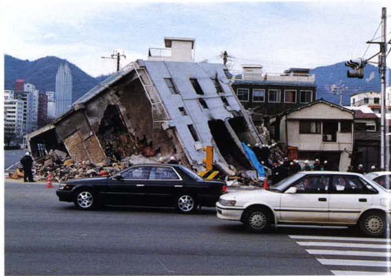
▲倒壊したビルを捜索中の警視庁機動隊員
