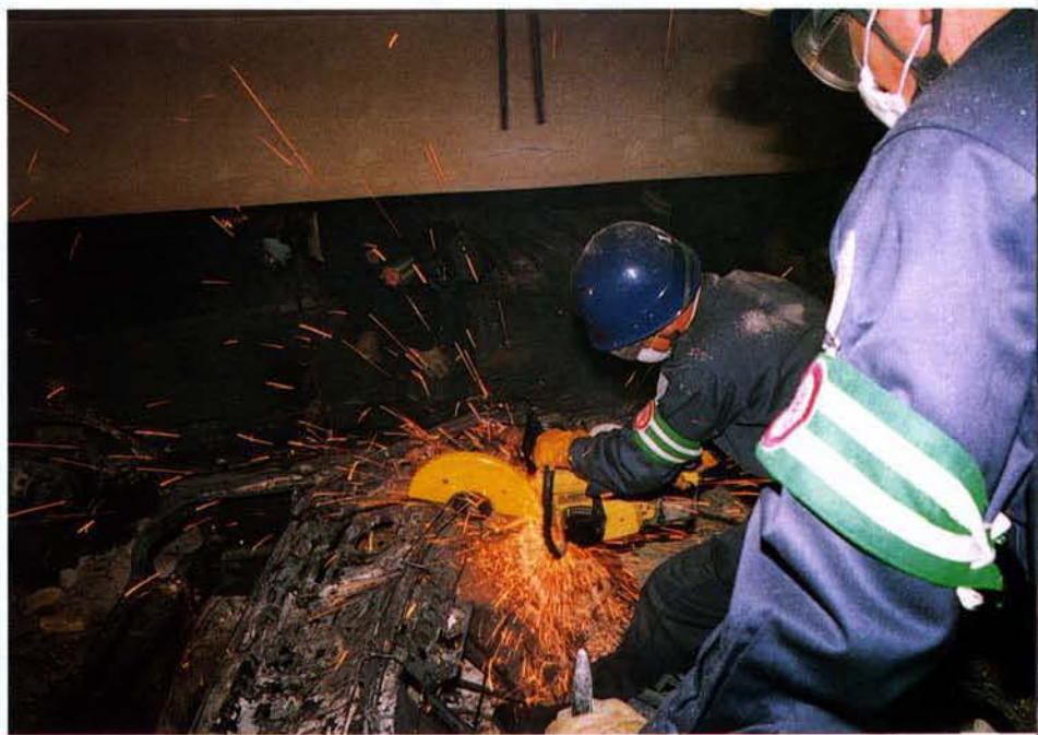
◀エンジンカッターによる障害物切断作業▶ (兵庫県警察機動隊・兵庫区)
