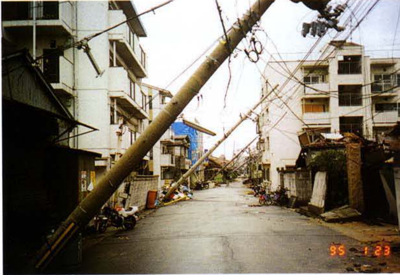
▲神戸市内の電柱倒壊状況▶
