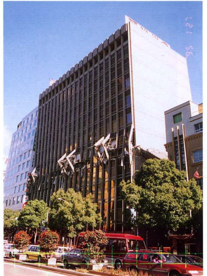
▲中央部分がつぶれたオフィスビル
