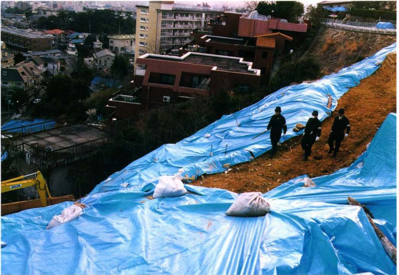
▲崖崩れ現場をパトロール（東灘区）
