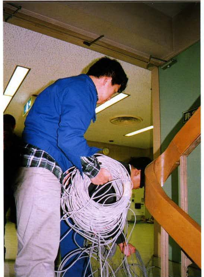
▲生田庁舎の配線作業
