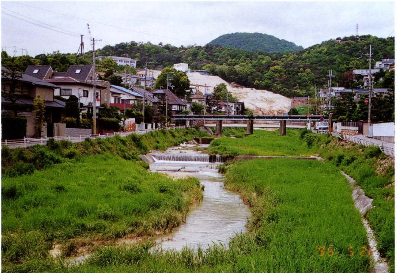
▲復旧作業が進む現場（5月20日）
