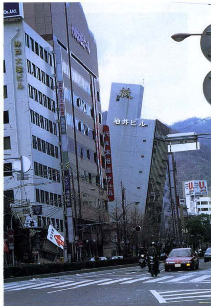
▲1階部分がつぶれて傾いたビル
