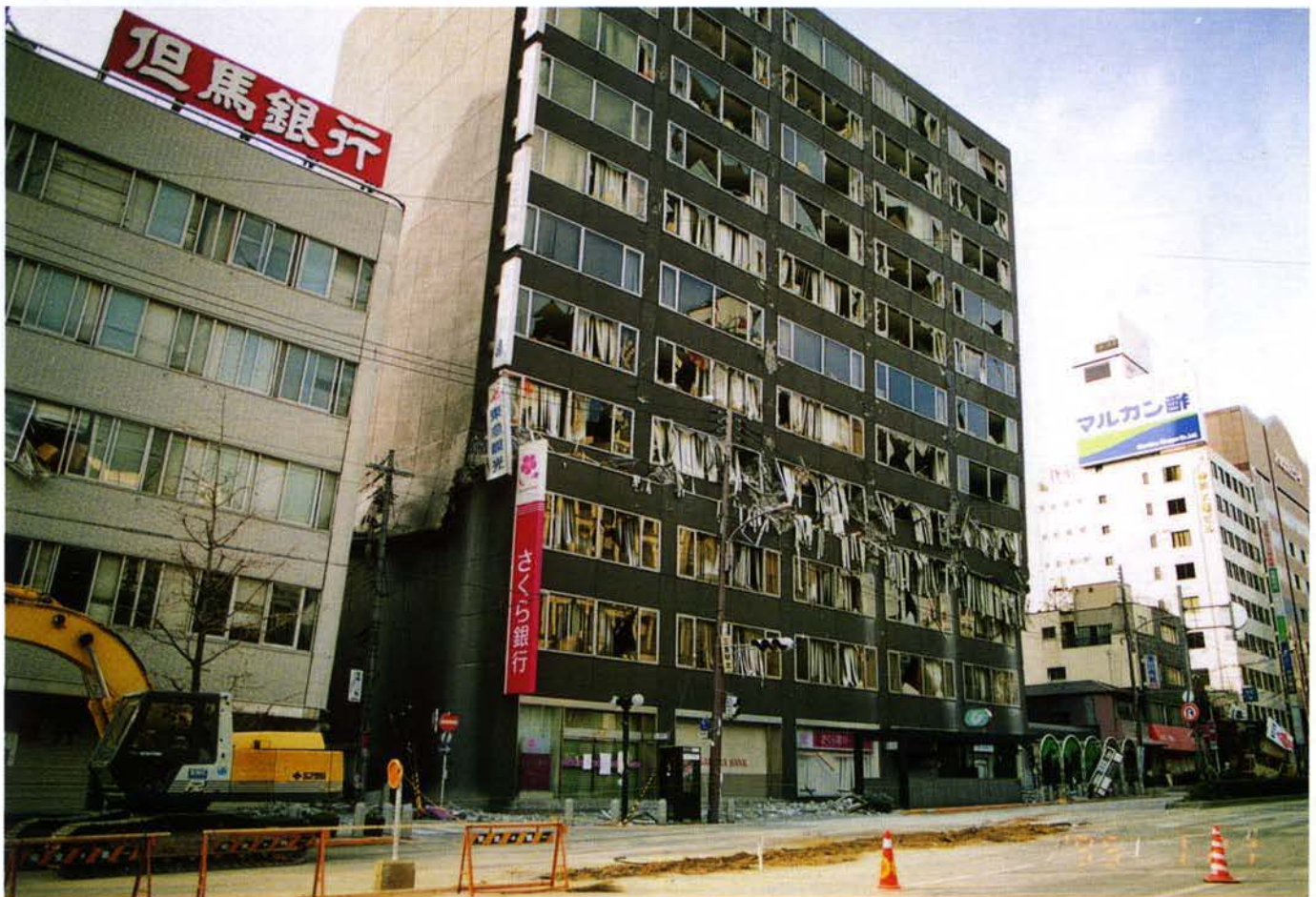
▲4階部分が崩壊したオフィスビル
