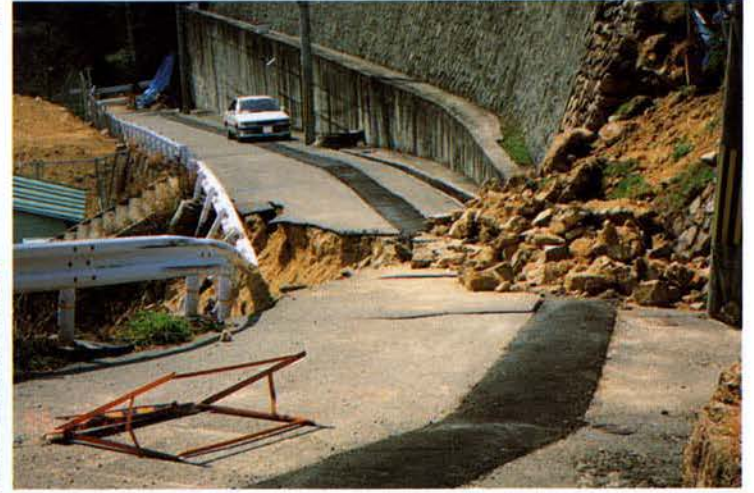
▲宝塚市内の道路を寸断した崖崩れ
