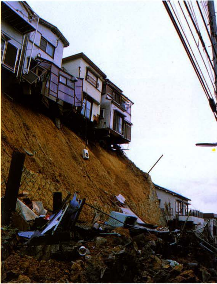
▲垂水区内住宅地の崖崩れ
