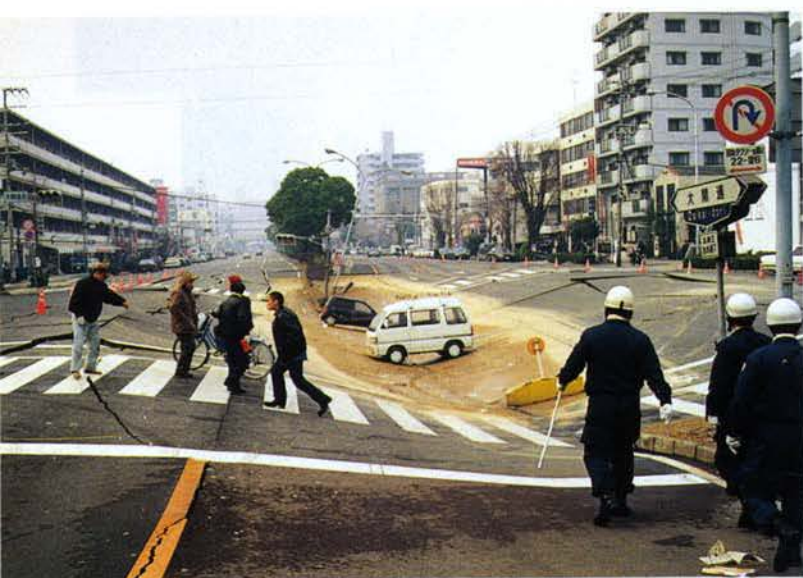
▲ 神戸高速鉄道大開駅（地下）崩壊による道路陥没
