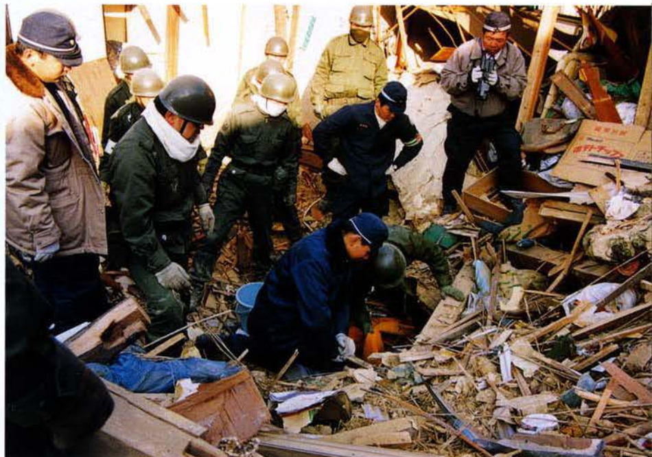
▲生存者の救出作業（西宮市） 43
