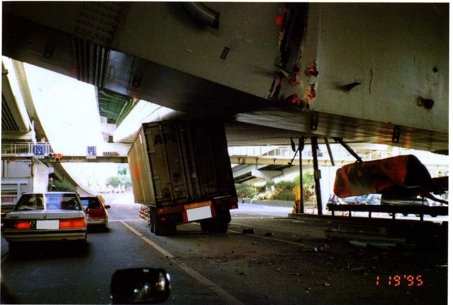
▲国道43号を走行中、阪神高速道路の下敷きになったトラック（西宮市市庭町）
