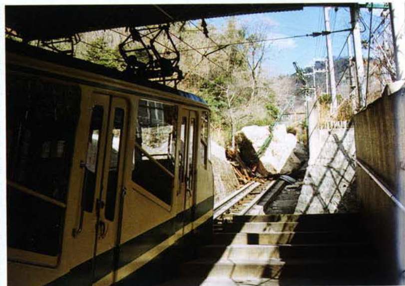
▲ 六甲ケーブル線路に落下した巨大石
