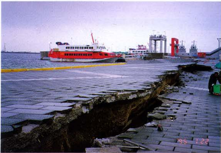
▲ポートアイランド：K-CAT付近の地盤沈下
