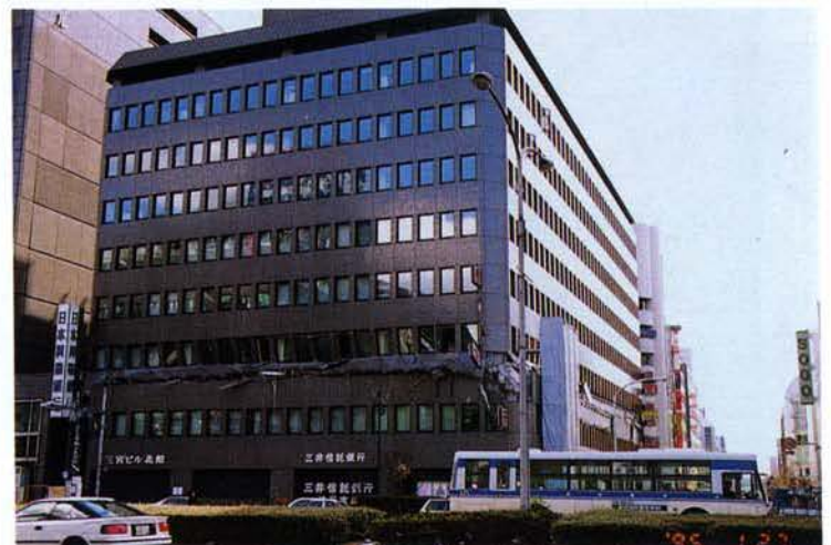
▲3階部分がつぶれたオフィスビル
