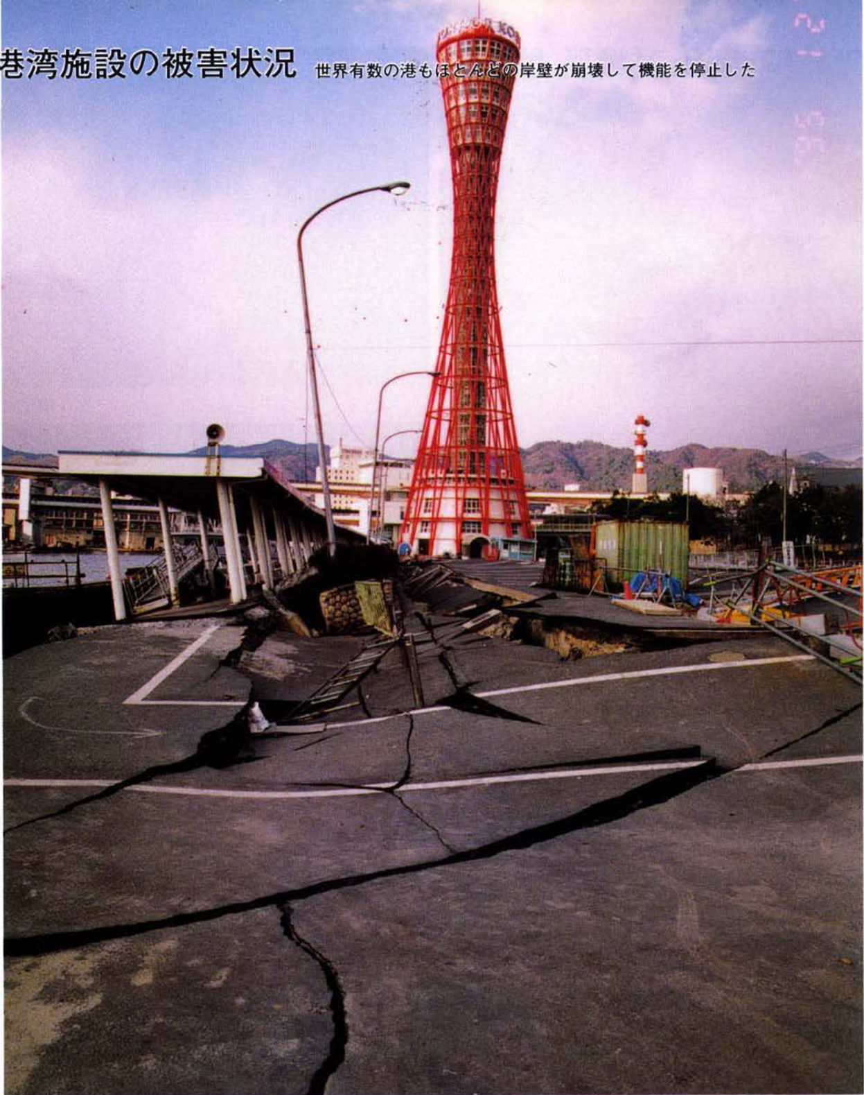
▲神戸港中突堤の亀裂
