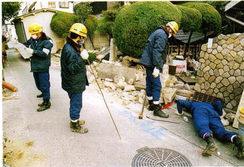
▲水道の復旧作業
