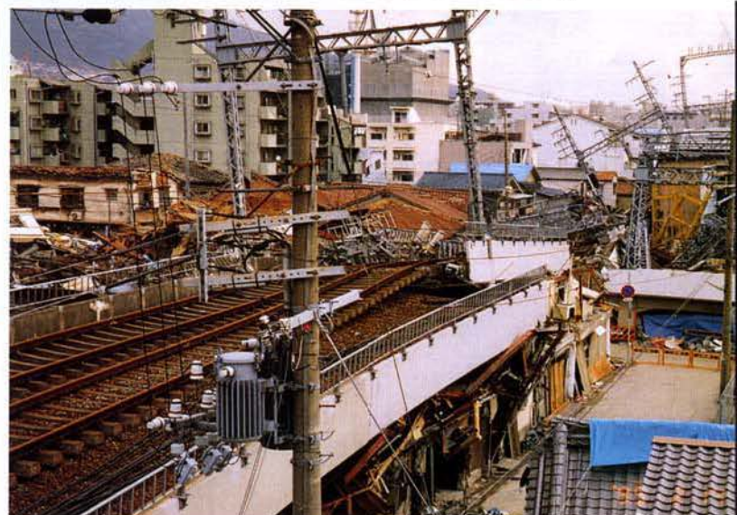
▲阪神電鉄高架の被害（灘区） 29
