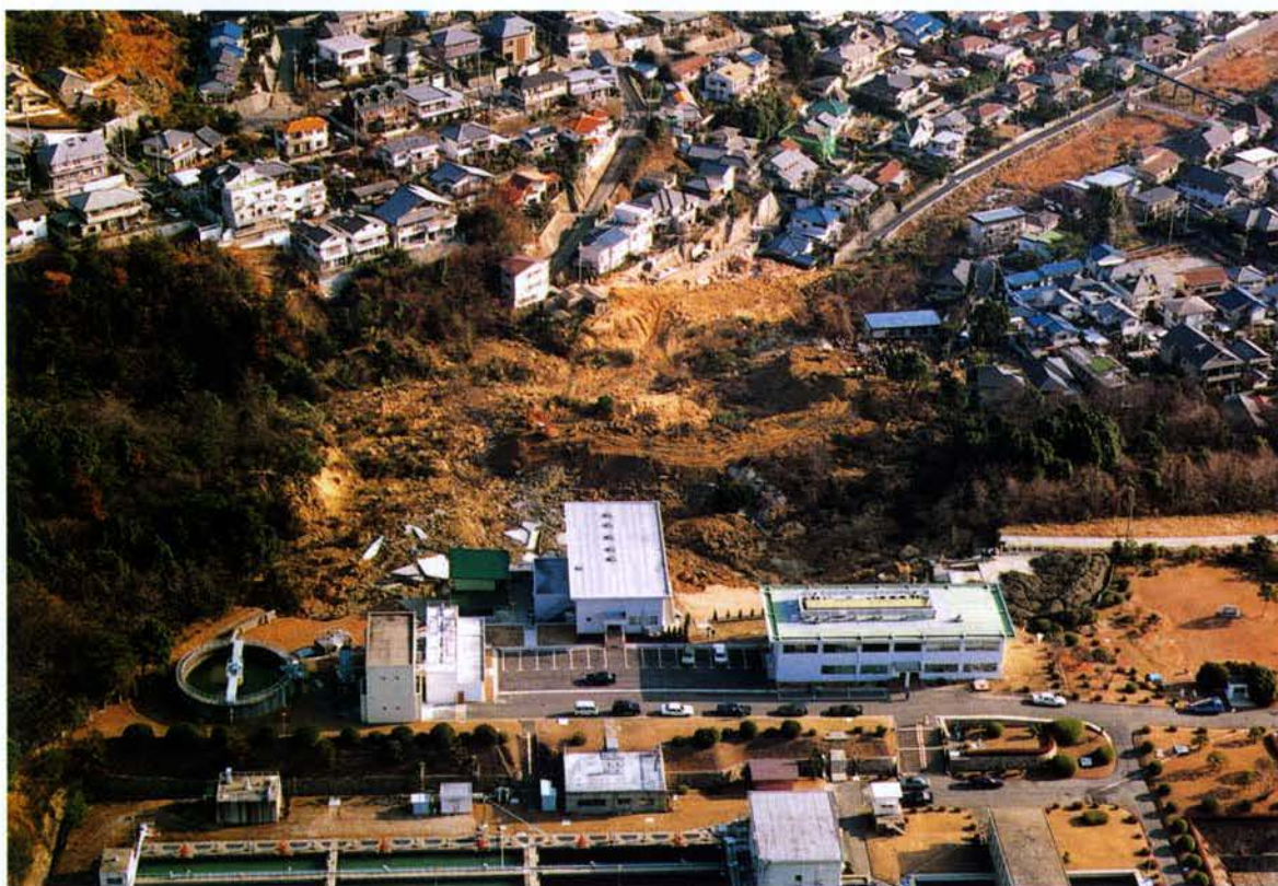
▲川を埋め、対岸の家をのみこんだ崖崩れ
