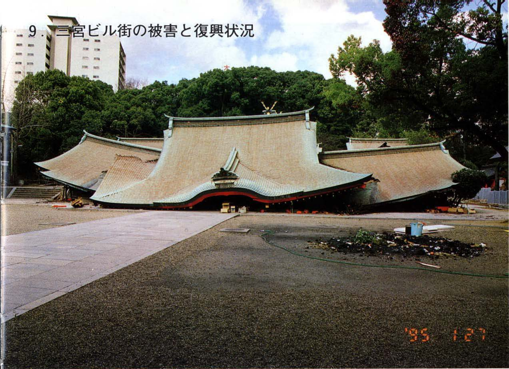
▲倒壊した神社（中央区）
