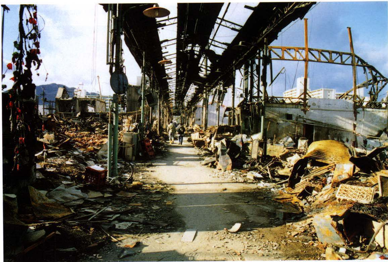
▲長田区菅原商店街アーケードの火災跡（2月）
