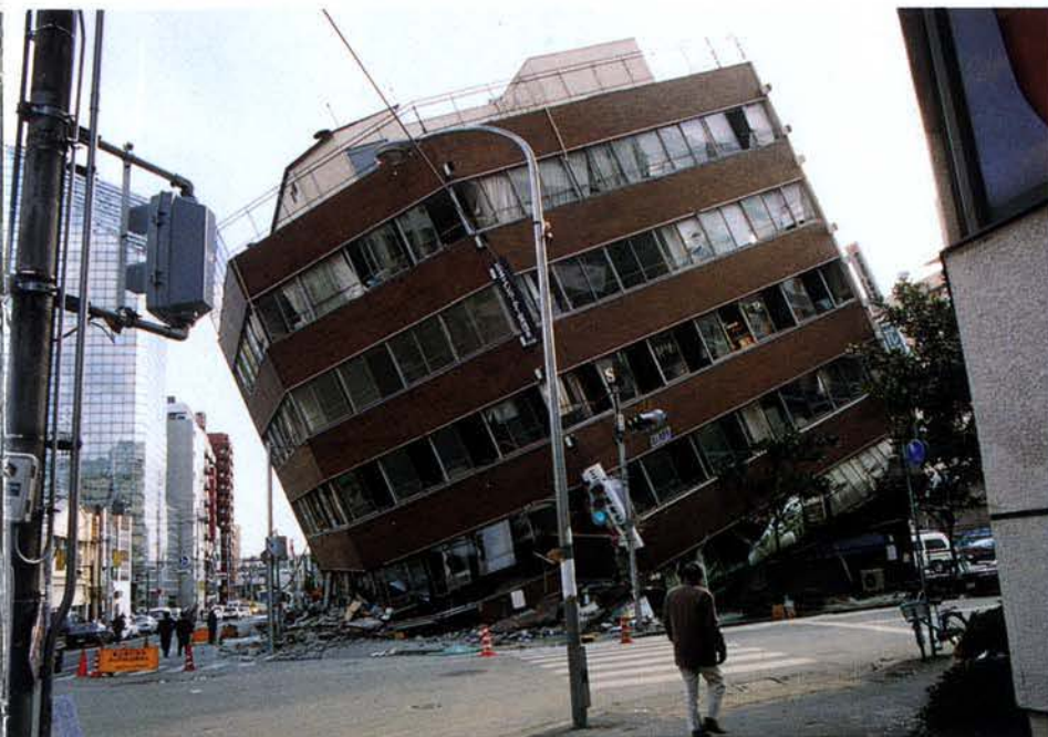
▲1階部分がつぶれて傾いたビル
