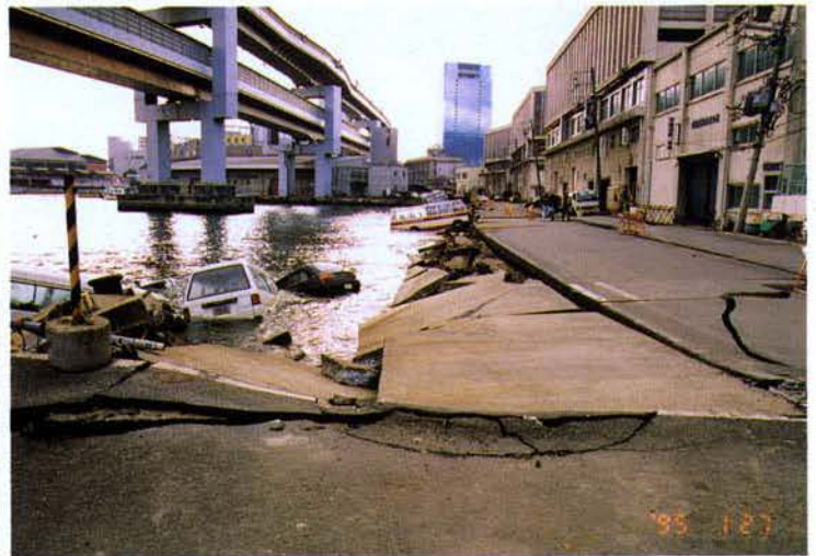
▲弁天浜付近の陥没した岸壁
