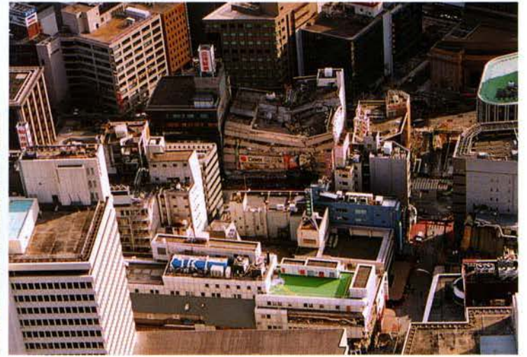
▲倒壊したスーパー
