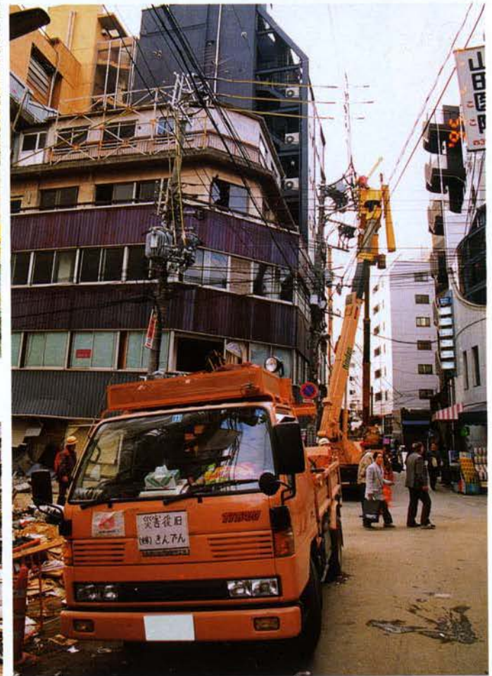
▲電気の復旧作業
