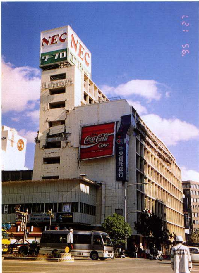
▲倒壊した劇場ビル
