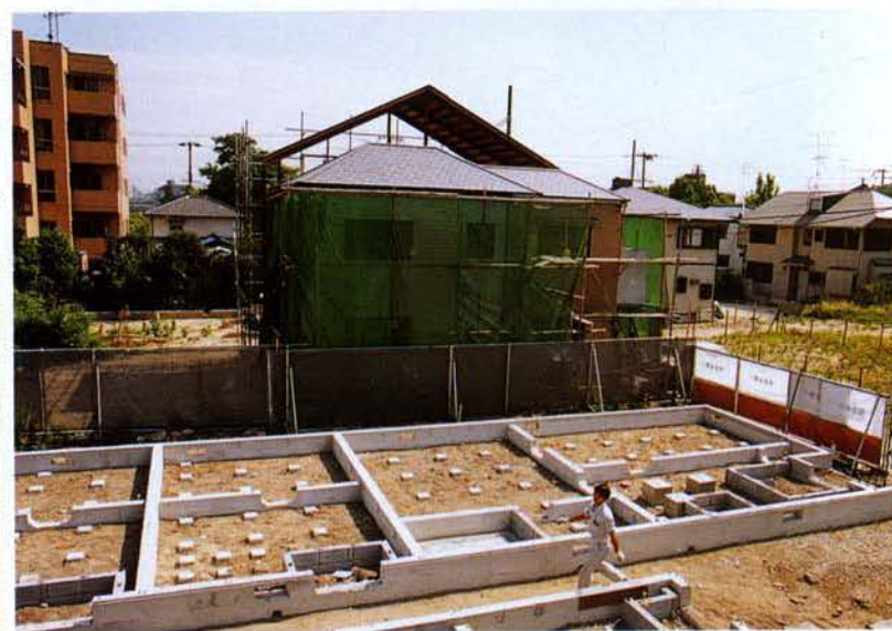
▲新築されつつある民家（東灘区）
