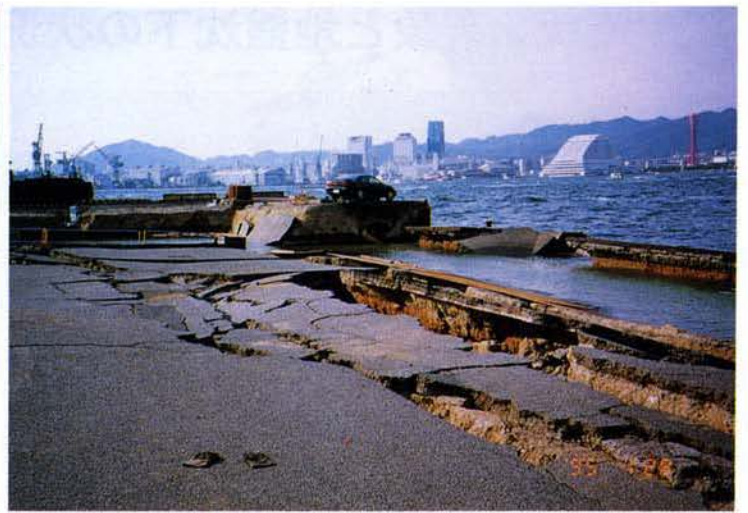
▲中央区港島の地盤沈下
