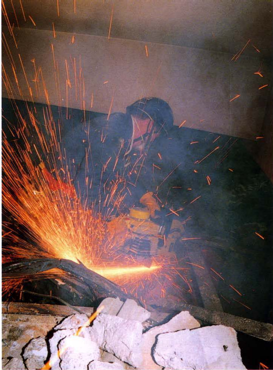
◀エンジンカッターによる障害物切断作業▶ (兵庫県警察機動隊・兵庫区)
