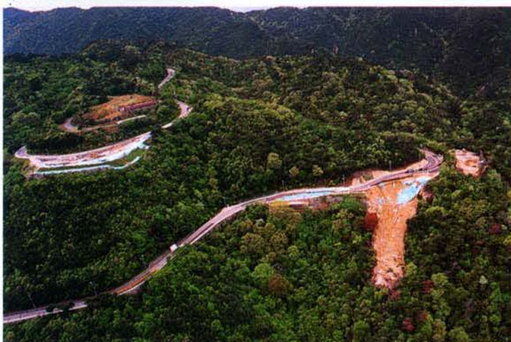
▲雨水が地割れに流入した崖崩れ
