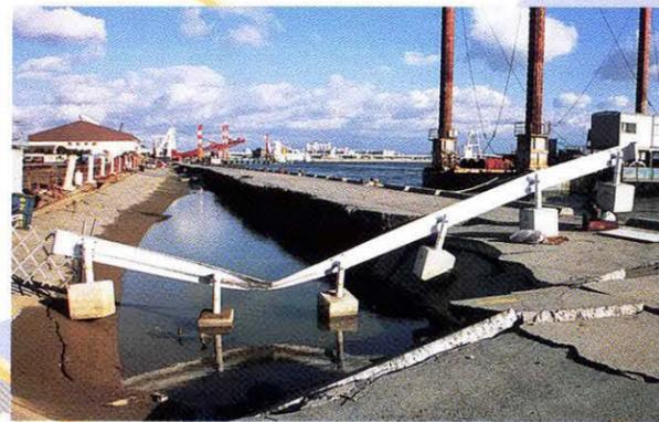
液状化による陥没した道路（西宮浜2丁目）
