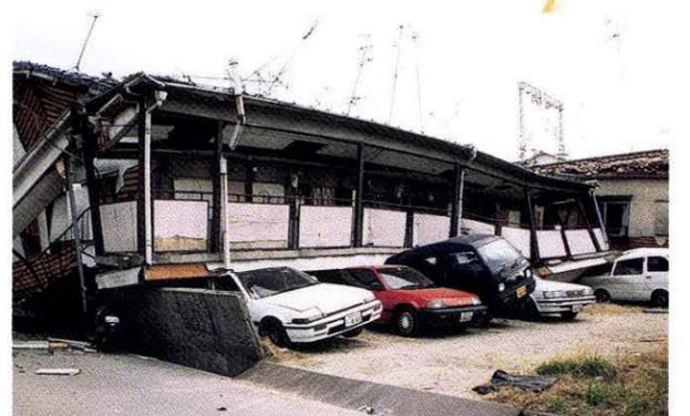
共同住宅の1階部分が壊れ駐車場の車両も破損（青木町）
