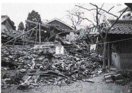
下坂部・常願寺
