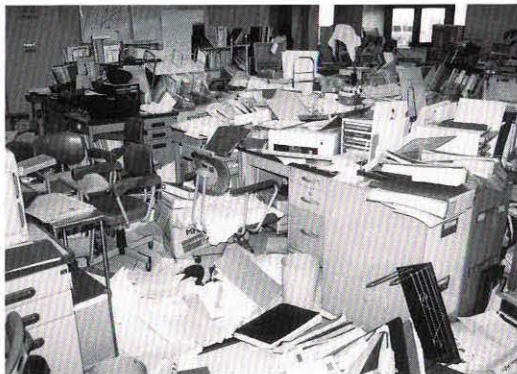
地震直後の防災センター5F事務所
