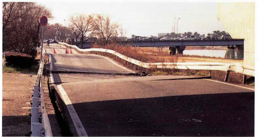
武庫川堤防 / 甲武橋北側
