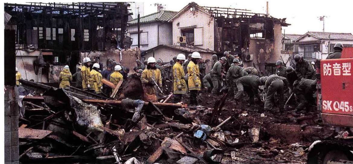
火災現場 / 立花町3丁目
