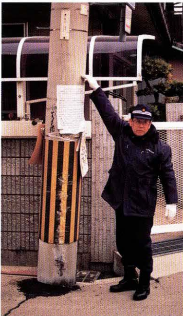
液状化により電柱が沈下 / 築地
