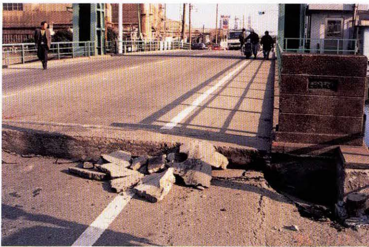
大高須町 / 東高州橋 可動橋
