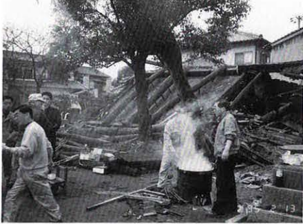
倒壊した初島大神宮境内での炊き出し
