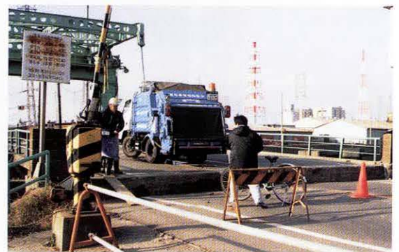
東高州橋 可動橋北側
