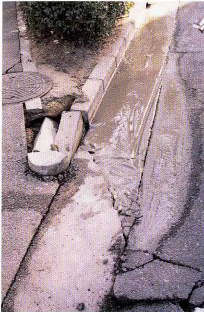
新幹線側道 / 常松 2 丁目
