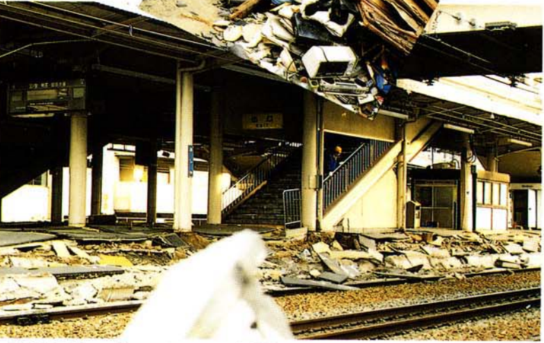
JR 芦屋駅のプラットフォームも崩壊していた
