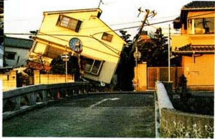
呉川町宮川付近の倒壊家屋
