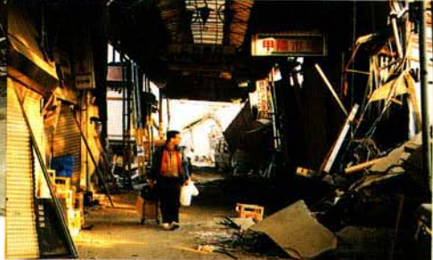
商店街などに大きな被害を受けた本通り商店街・甲陽市場西入口付近
