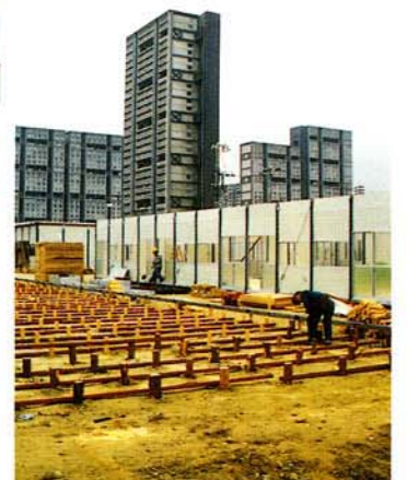
急ピッチで進められる仮設住 宅建設準備
