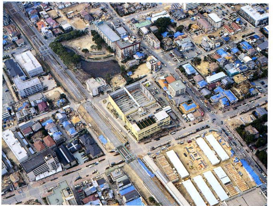
屋根が落下した体育館・青少年センター競技場
