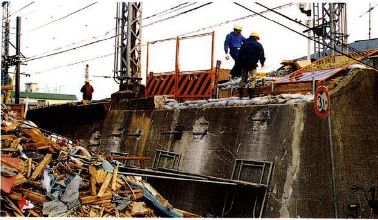
懸命に行われる線路の復旧工事・阪神電車
