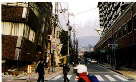
倒れかかるビル J R 芦屋駅北ラポルテ西館付近
