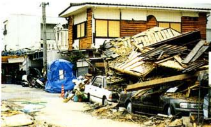
茶屋之町付近の倒壊家屋に押しつぶされた乗用車
