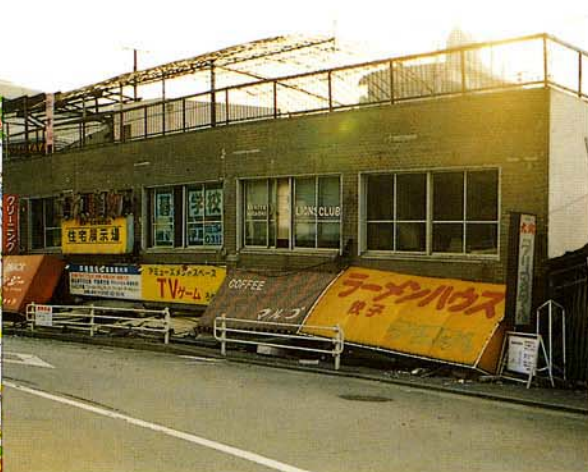
J R 芦屋駅南側のビルは1階が崩壊した
