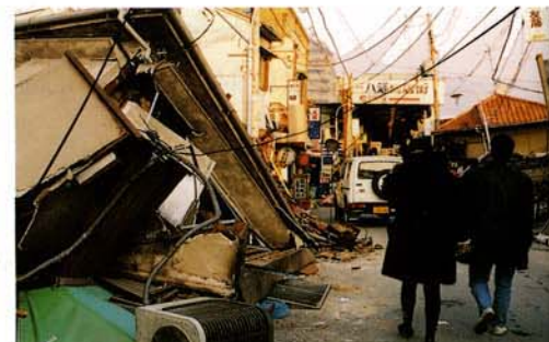
大きな被害を受けた 三八通り商店街南入口付近
