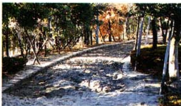
芦屋浜全域に液状化現象が 見られた。 潮見町西浜公園内の遊歩道
