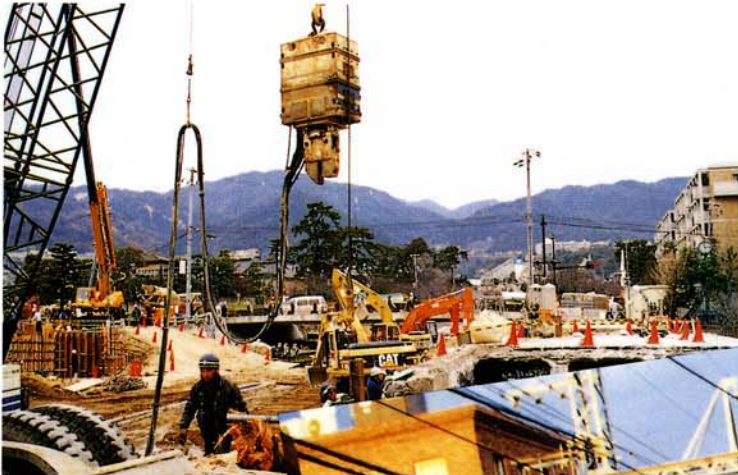
芦屋川トンネルの 解体復旧工事
