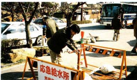
水道の仮復旧のため、市内各所に仮配管や応急給水所が設けられた
