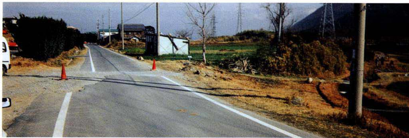
断層の運動によってずれた道路（北淡町梨本地区）
