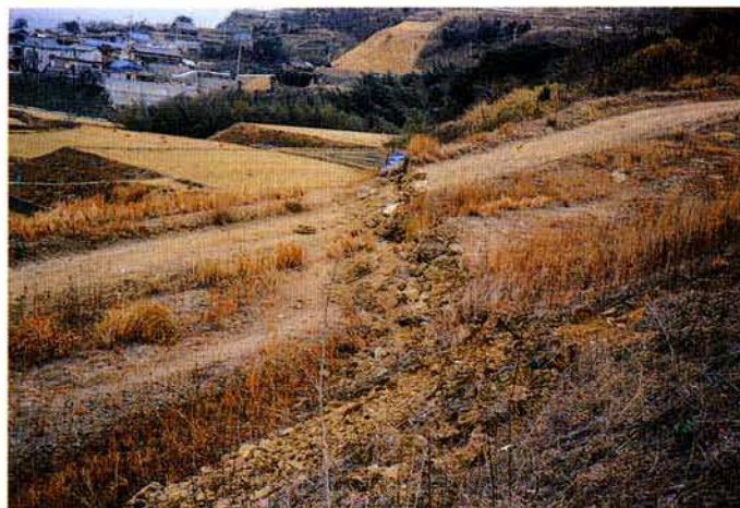
航空写真—1のA地点：左の写真の道路を斜面上方から望む。
