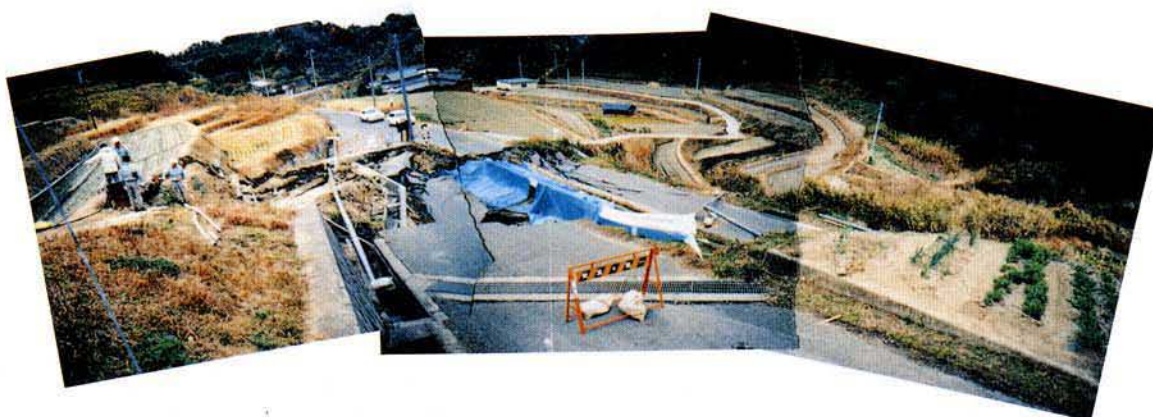
一般県道鮎原一宮線と一宮町道平田下道線（手前）の被災状況 一宮町高山地区
