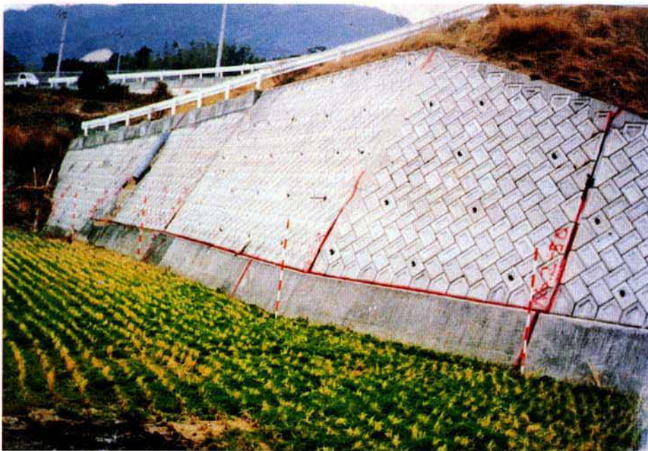
一宮町道上道3号線 一宮町新村地区
