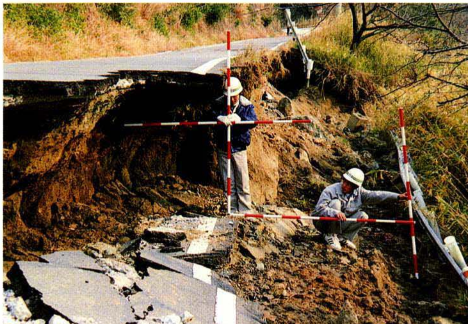
一般県道野島浦線 北淡町野島墓浦地区
