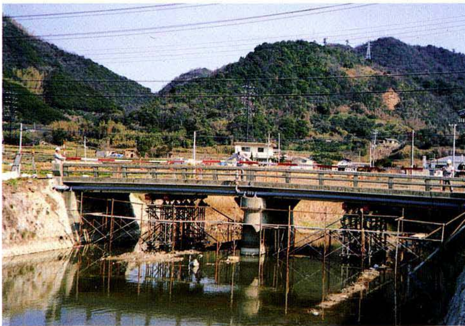
主要地方道福良江井岩屋線 野島橋 北淡町 野島地区
