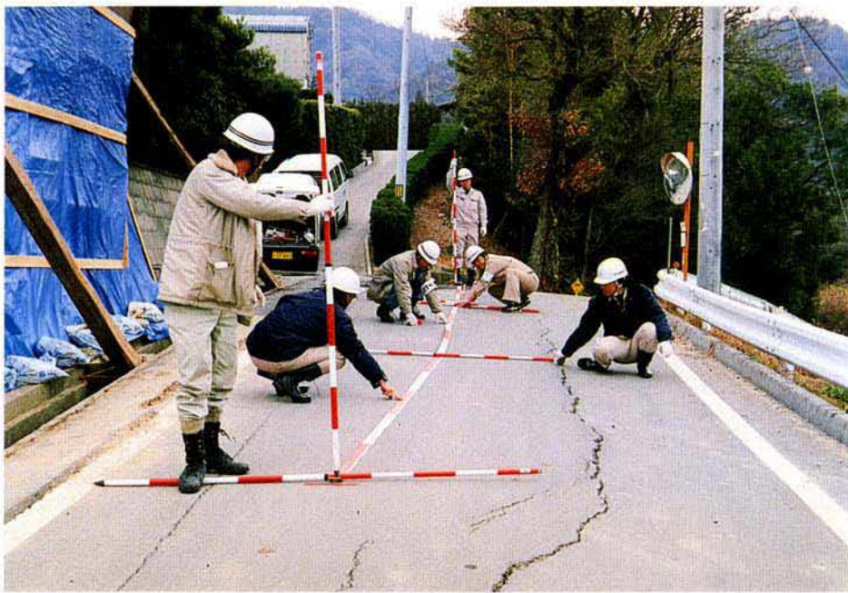
北淡町道撫線 北淡町黒谷地区
