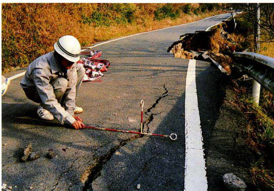
亀裂の深さの測定状況
