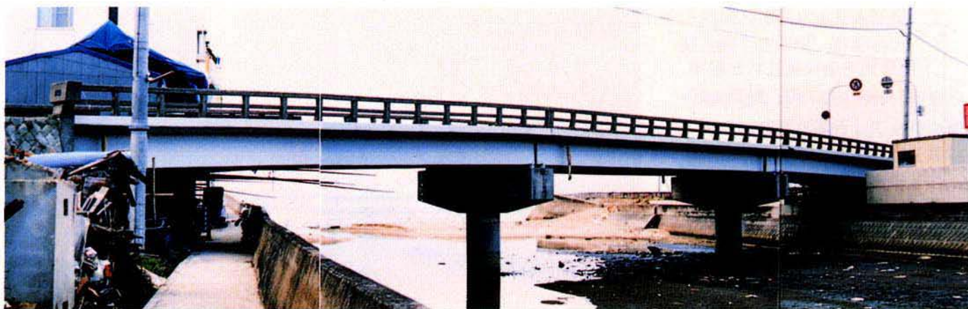
主要地方道福良江井岩屋線 新室津橋 北淡町室津地区
