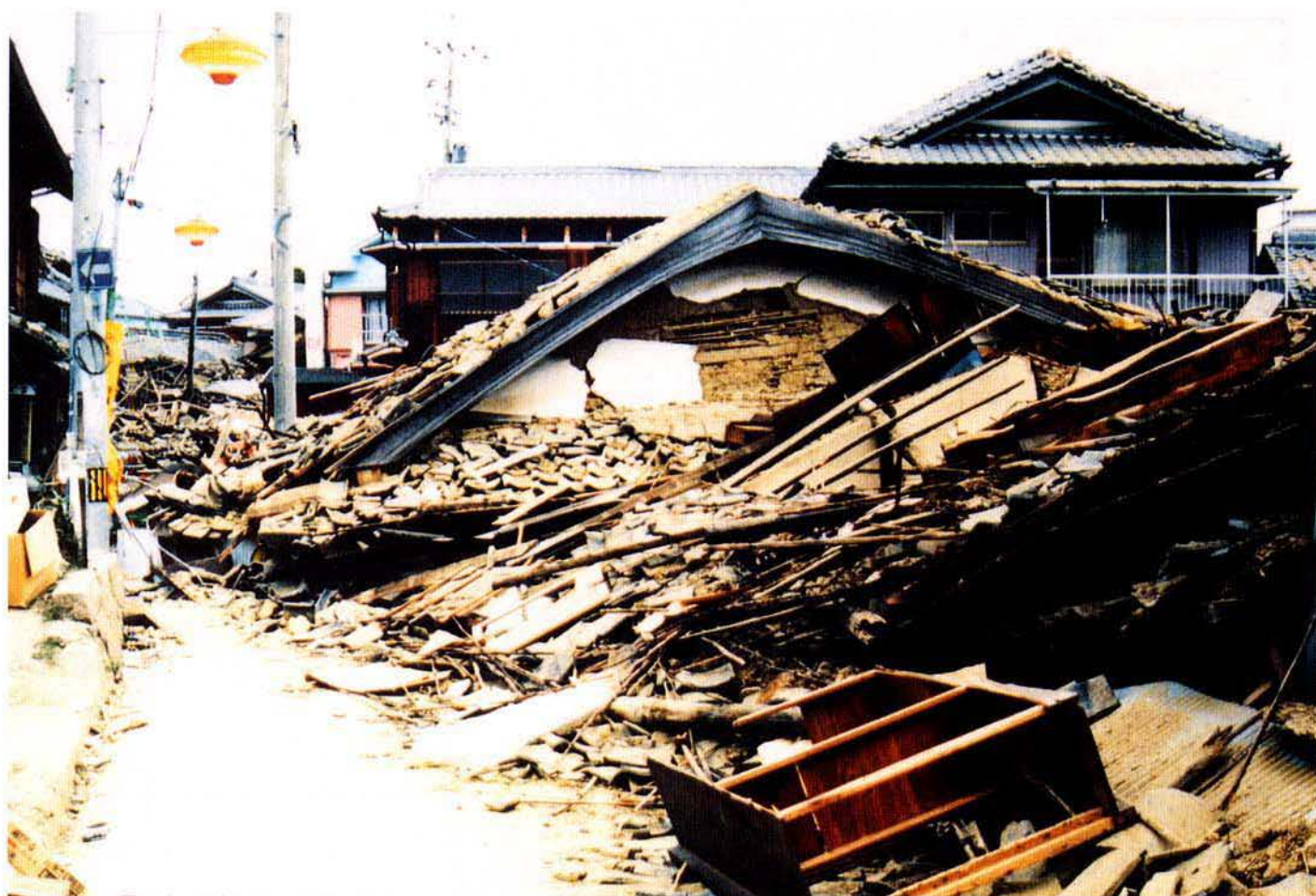
北淡町道 富島本町線 北淡町富島地区 家屋倒壊撤去
