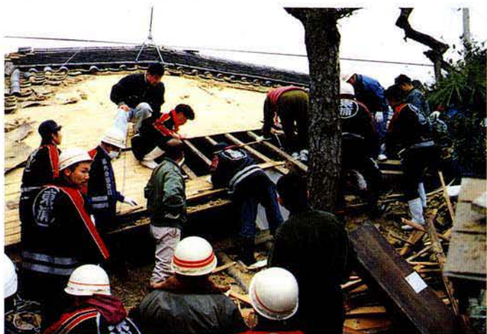
2. 横からだけでは無理なので屋根板も取り外して、内部を調べる。
