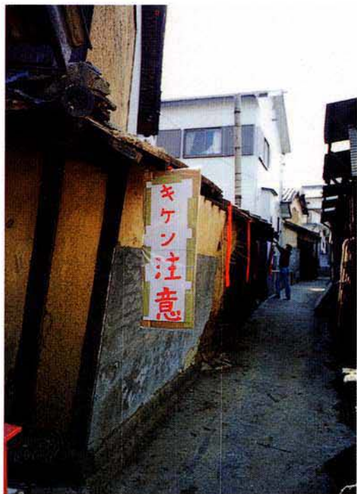
今にも倒れそうな建物に「キケン」の表示を自主的に行っている人（岩屋東ノ町地区）
