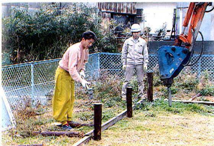
1. 基礎の杭打ちが始まる。(H.7.1.23)
