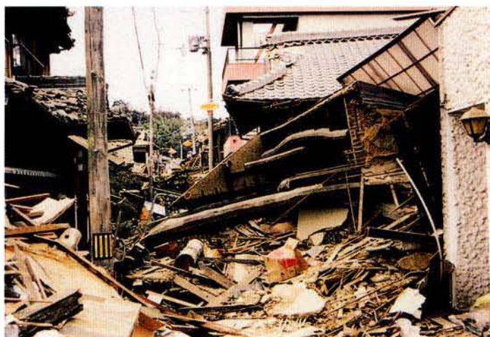
全壊して道路に崩れ落ちた家屋（富島地区 H.7.1.20）
