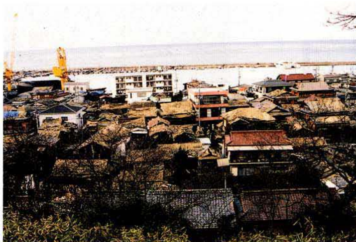
屋根瓦の落ちた家屋が多く見られる。 この後、これらの家屋の大半が撤去された。 （富島地区 H.7.1.20）
