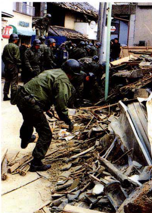
自衛隊によるガレキの撤去作業（志筑地区）
