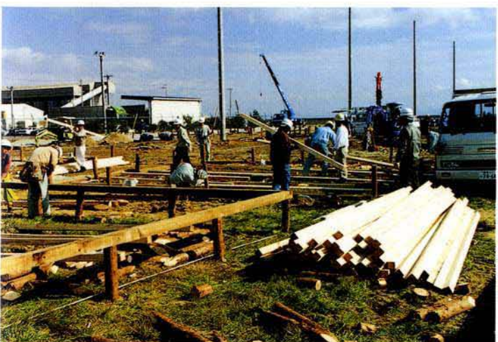
仮設住宅の建設の様子（志筑新島地区 H.7.1.）
