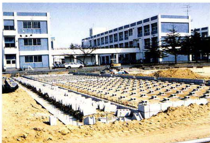
震災により校舎が使用不能となり、仮設校舎の建設が急がれた。 (東浦中学校で H.7.3.12)
