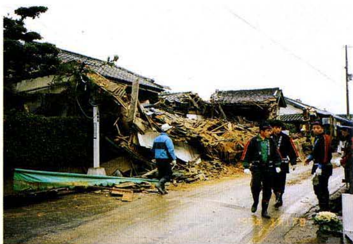
震災当日の様子。すでに消防団が出動し、活動に入っている。(H.7.1.17)
