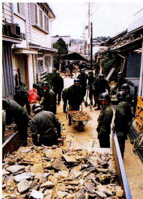
自衛隊によるガレキ撤去作業
