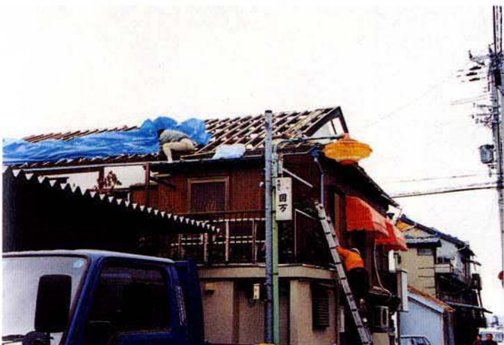
瓦が落ちてしまった屋根にビニールシートをかけているところ。今でもビニールシートのままの家屋が残っている。（岩屋東ノ町地区）
