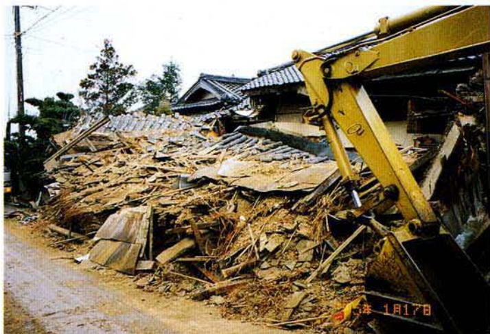
即日重機が投入され、道路の整備が行われた。(H.7.1.17)
