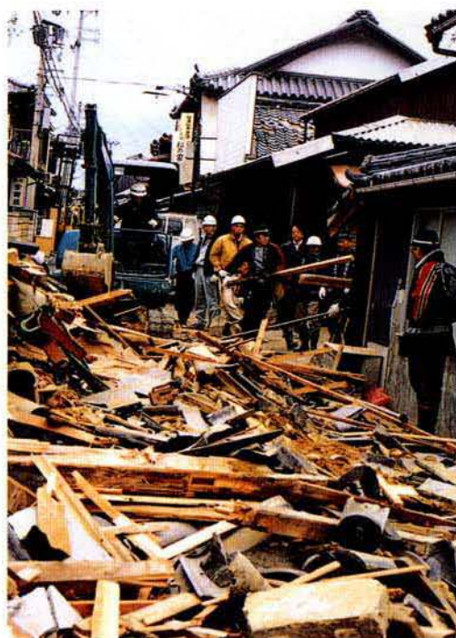
消防団による倒壊家屋の撤去
