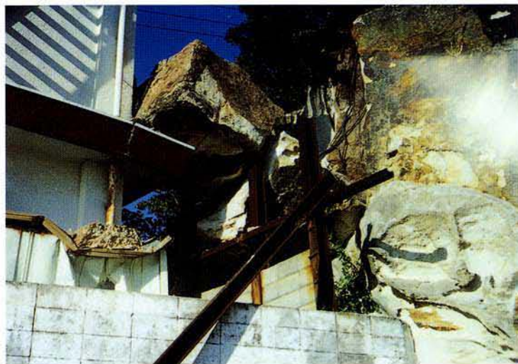
住宅の底を巨大な岩が直撃した。(岩屋、大和島付近)
