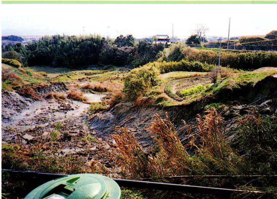
地震動に起因して発生した高滝 地区の地すべり。
