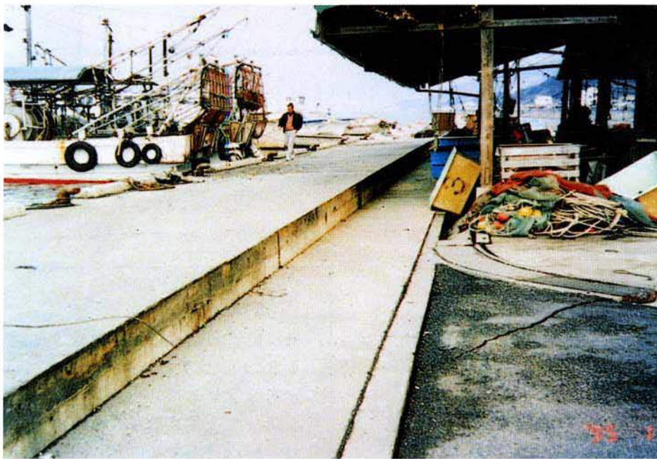
郡家港 物揚場（－2 m） 全景（直立消波ブロック式）
