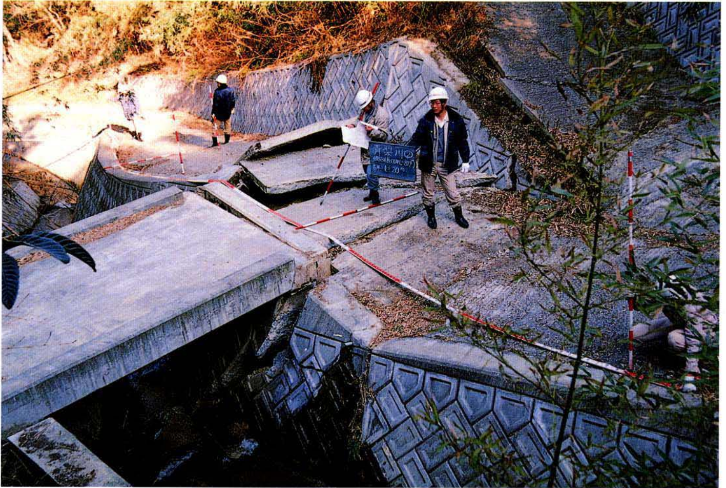
普通河川青梨川 北淡町野島平林地区
