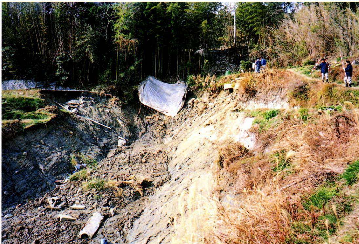
津名町生穂地区 高滝地区緊急地すべり
