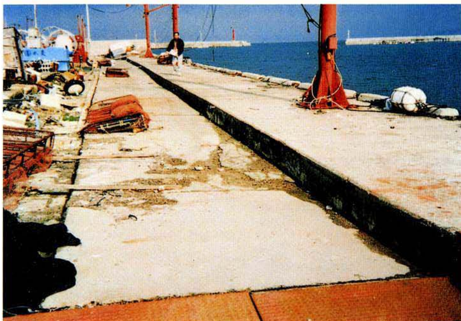
江井港 物揚場（－2 m） 全景（直立消波ブロック式）
