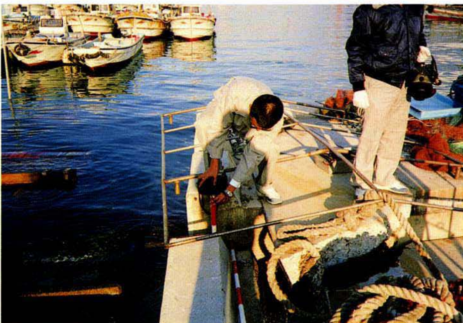
本体ブロックの移動により、地面まで隙間が生じている。舗装コンクリートも割れている。
