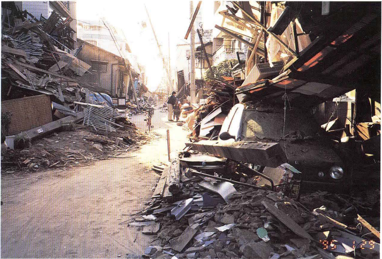
倒壊した家屋（神戸市長田区）
