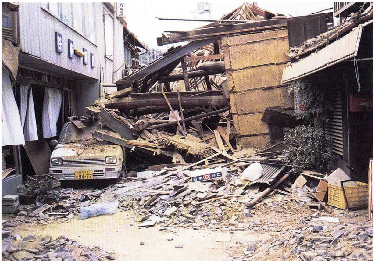
倒壊した家屋（津名郡北淡町）
