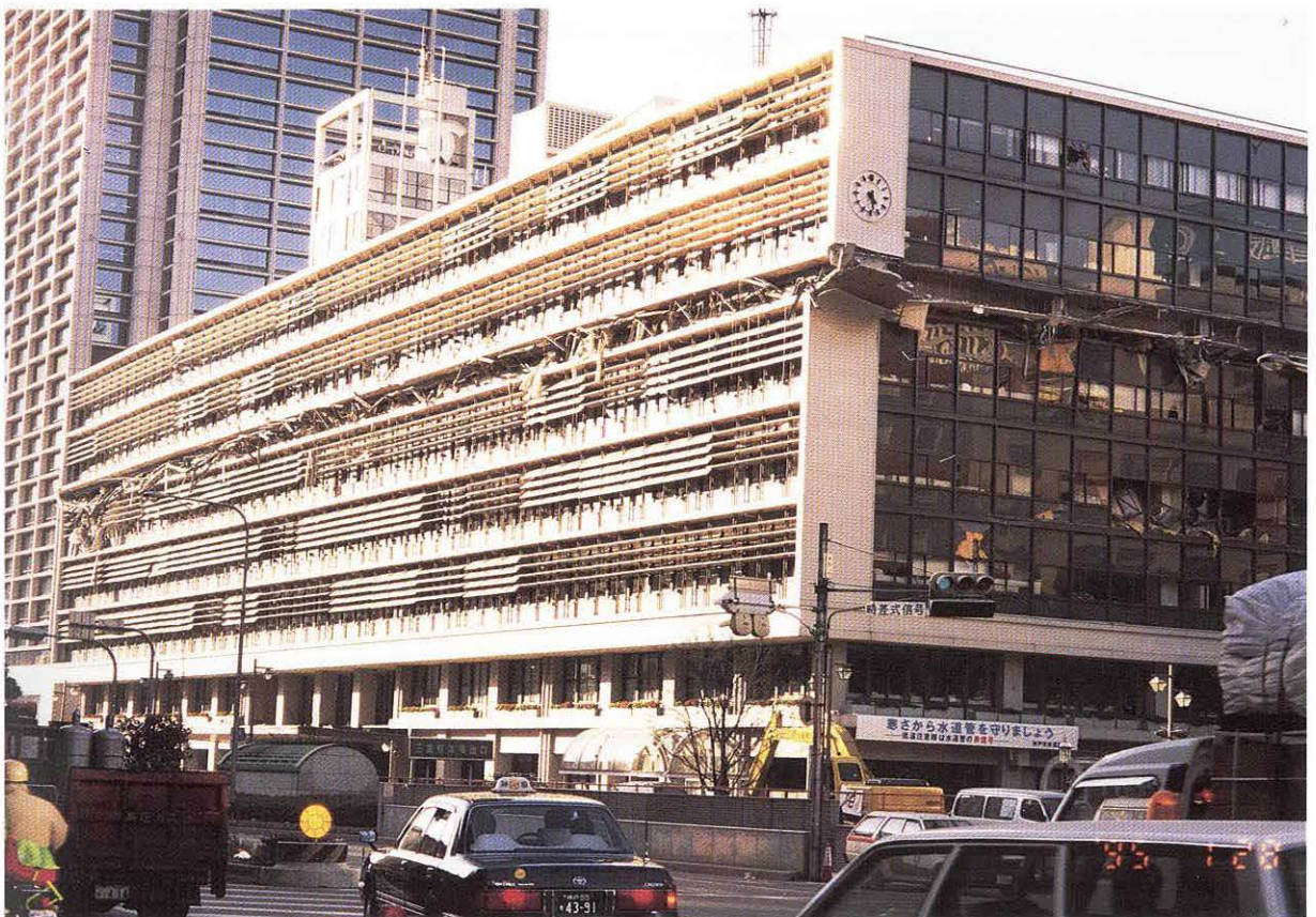
6階部分が押し潰された神戸市役所旧庁舎（神戸市中央区）
