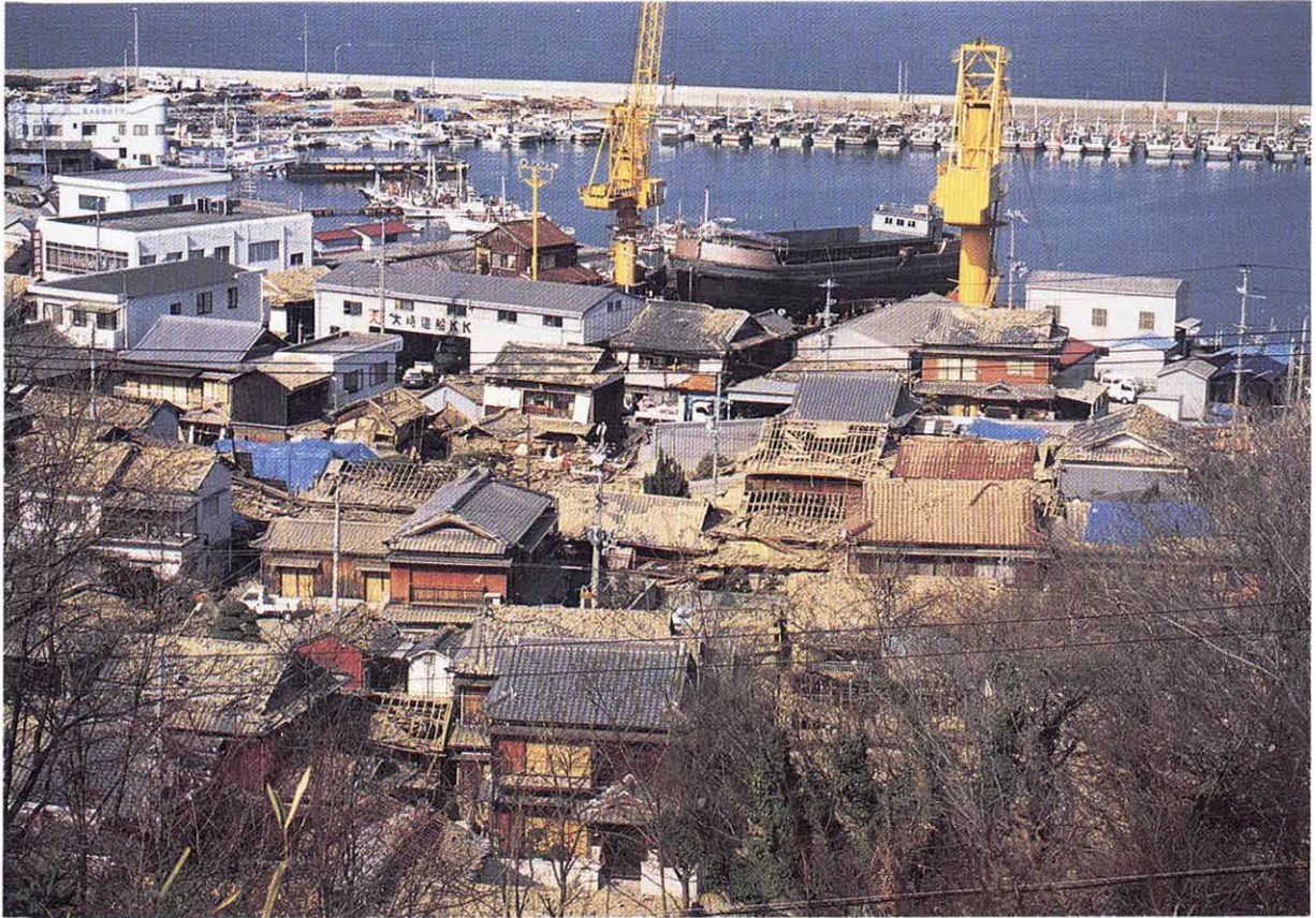
ほとんどの屋根瓦が落ちている（津名郡北淡町）
