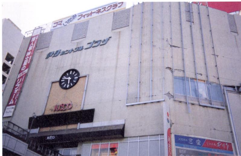
外壁の亀裂部はピンネット補修及び一部
