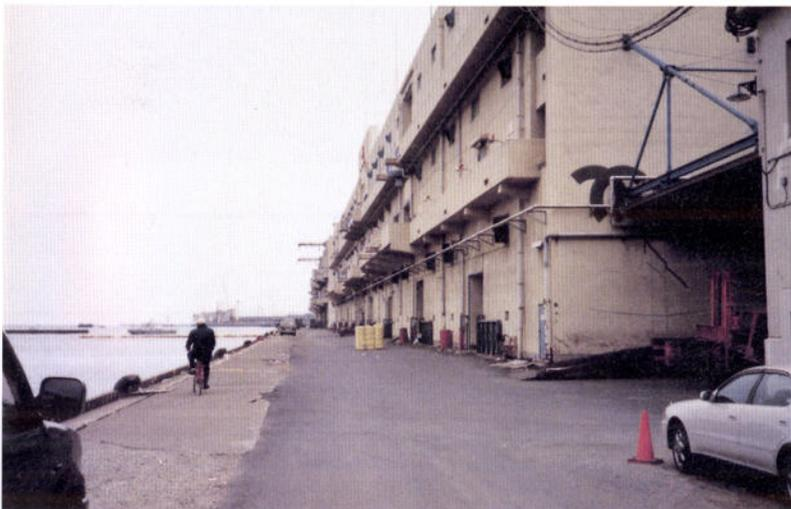
緊急輸送ルートとしての車両走行可能なように、海上輸送による碎石を沈下したヤードに盛土し、アスファルトで仮舗装を行った。
