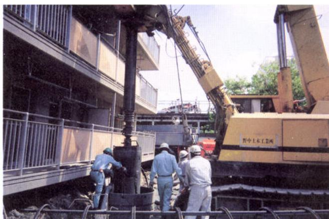
既設建物の基礎部に地中梁を新設の上、建物周囲にアースドリル杭を造築。杭を反力の支持としてジャッキUPを実施。
