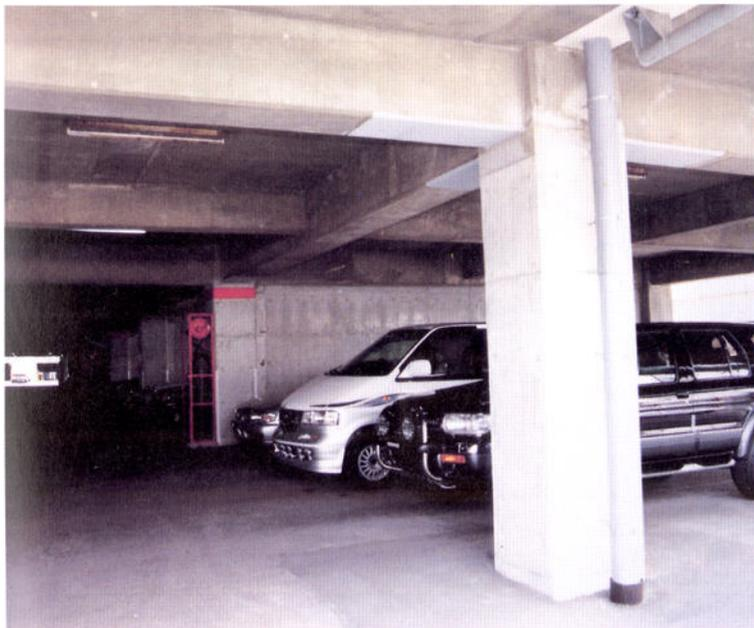
新耐震基準に適合させる1階柱のコンクリートを打替え、1～3階に耐震壁を新設。
