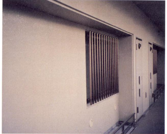
柱は一部コンクリート打替え及び鋼板巻き補強。また耐震壁及び雑壁の一部コンクリート打替え。
