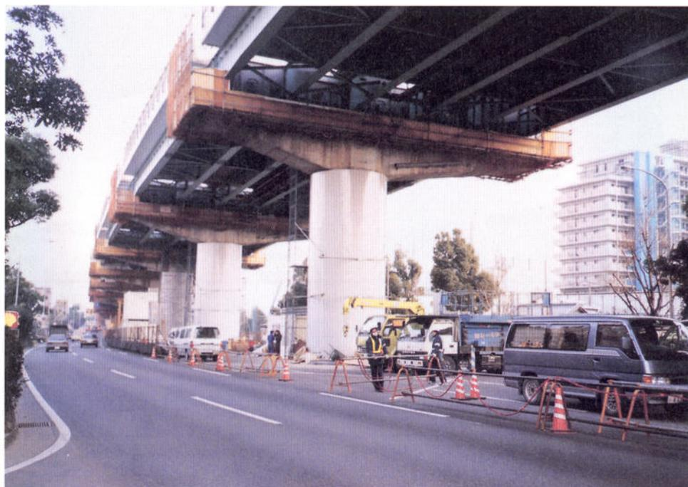
挫屈や亀裂のいったRC単柱46橋脚を補修・断面拡大鉄板巻き補強、10橋脚を全面解体撤去し再構築し、とくに橋脚張出し梁の解体には重量運搬車を利用したFMCD（フジタミックキャリアダウン）工法を開発して安全・短期施工を実現し好評を得た。
