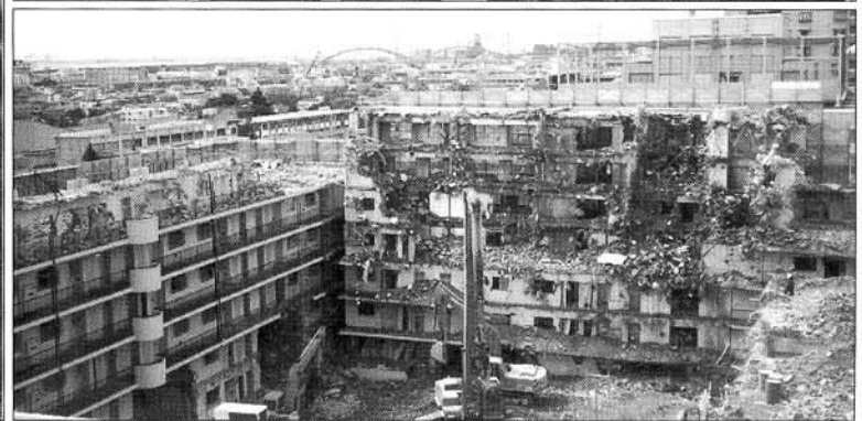
マンション解体風景
