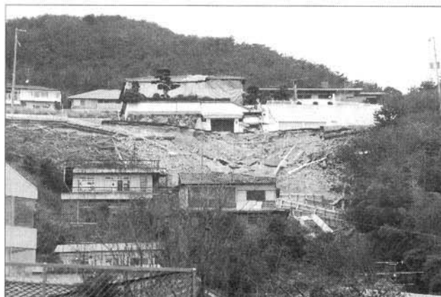
西岡本地区の地滑り現場
