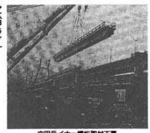
六甲ライナー橋桁取付工事
