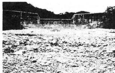
昭和42年豪雨後、約12万㎡もの土砂をせき止めてこの通り
