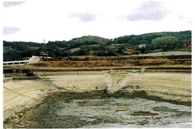
底に亀裂のはいったため池（仁井地区）
