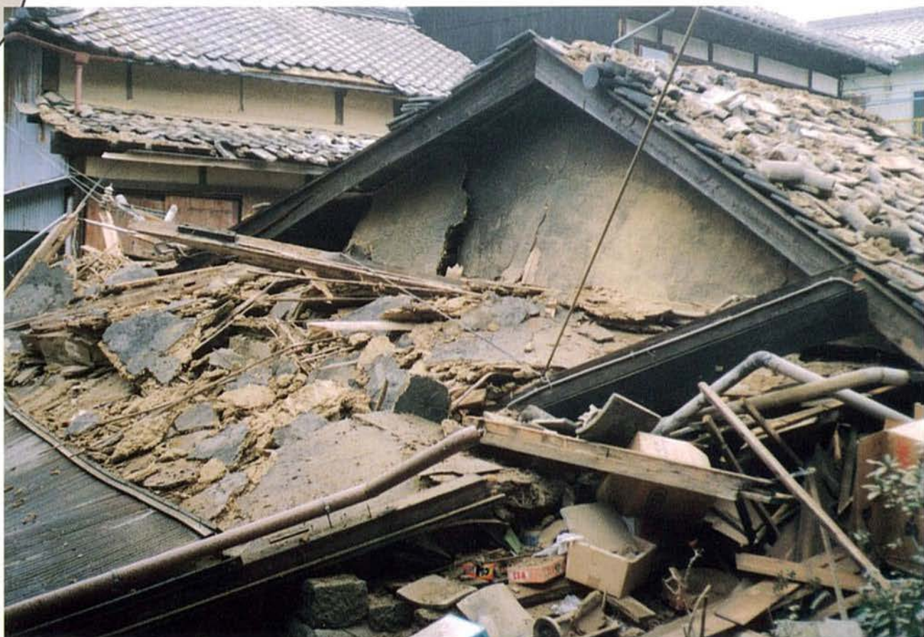
瓦葺きの家屋の倒壊（富島地区）
