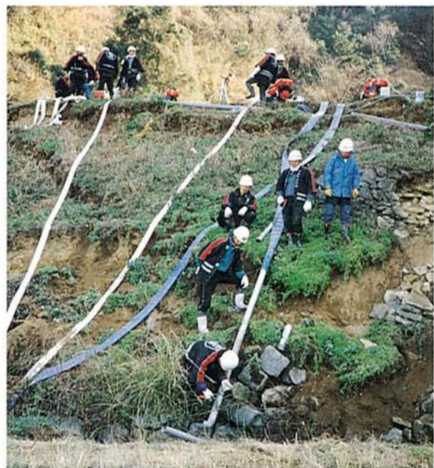
ため池決壊を防ぐため作業を行う消防団員
