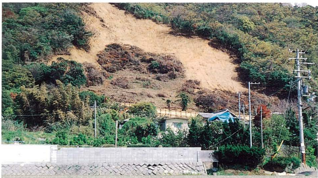
地震により大きく崩れた大石地区の現場
