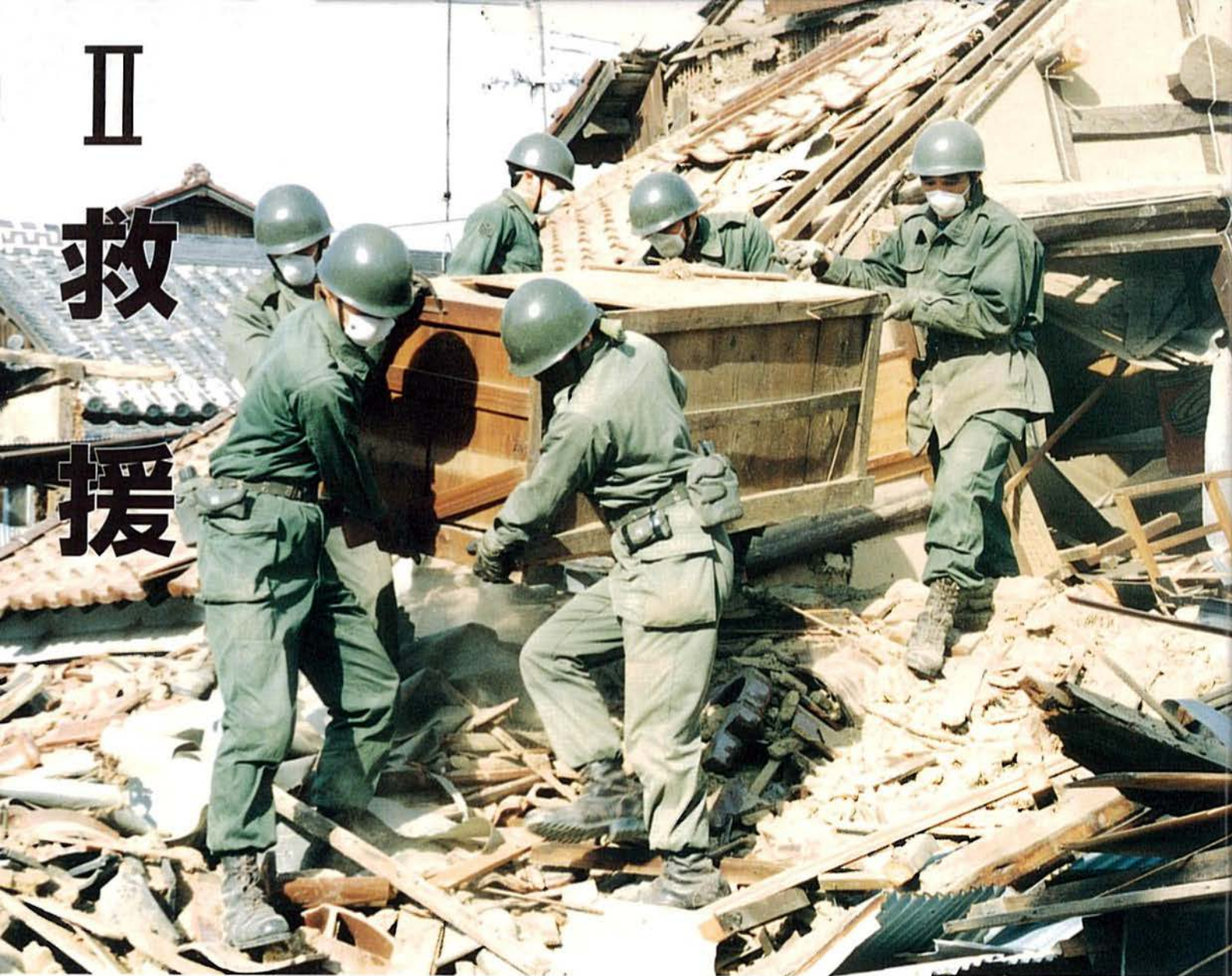
撤去作業中、倒壊家屋から住民の要望により家具を持ち出す自衛隊員。
