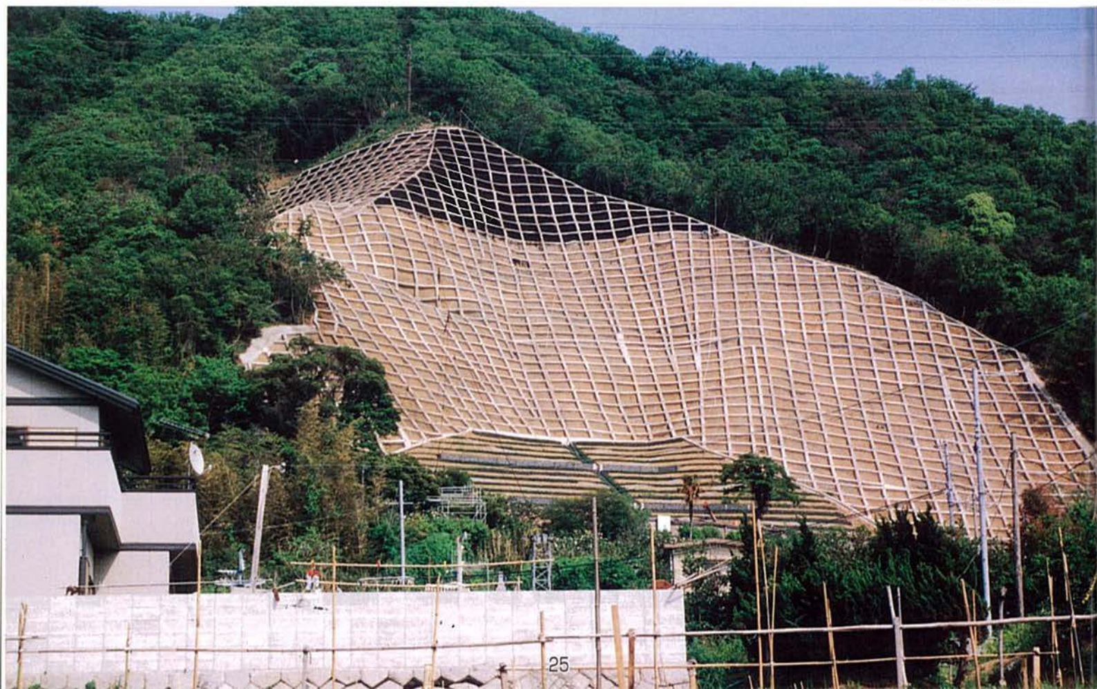
復旧後の同地区
