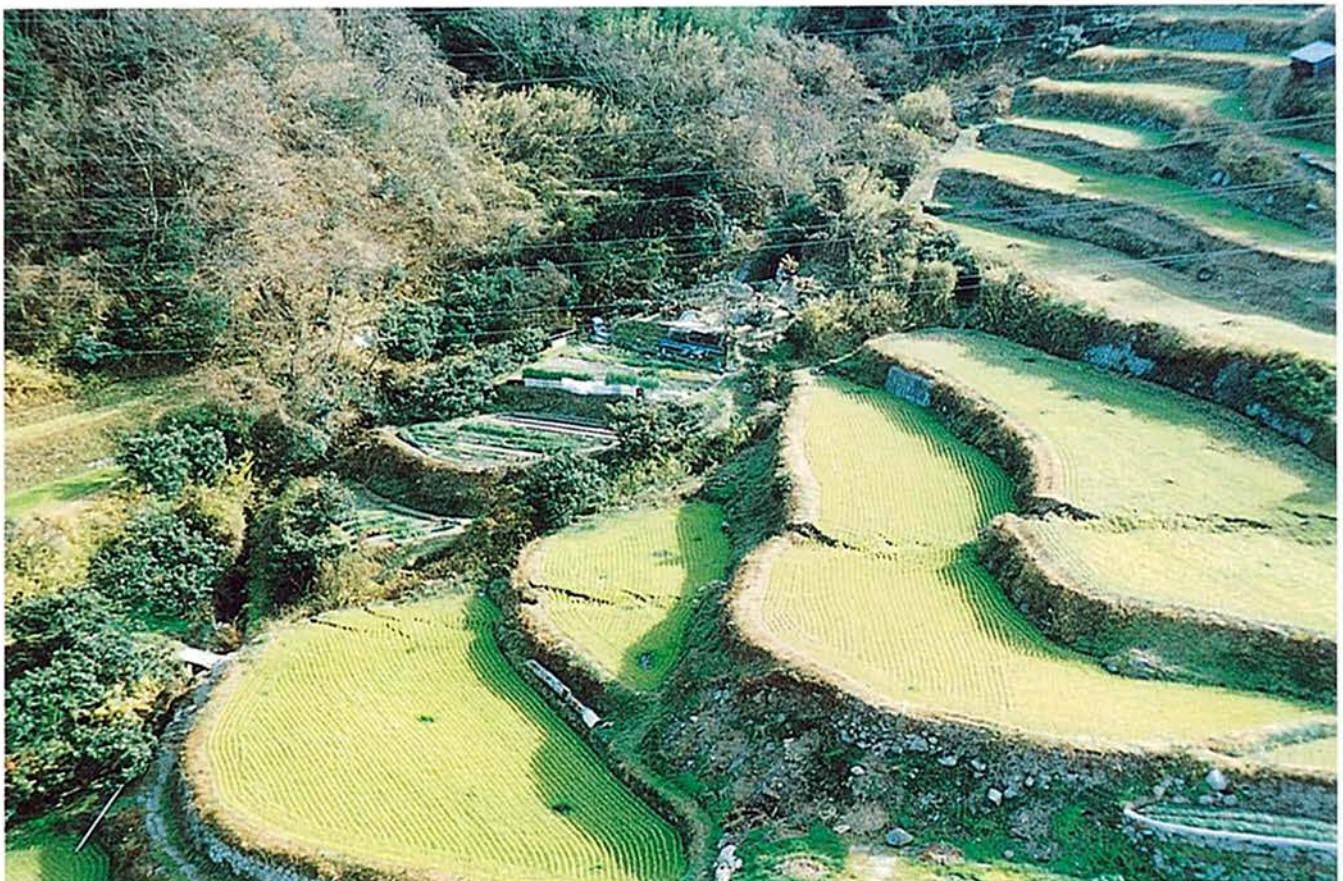
江崎地区の水田のずれと亀裂(撮影:広島大学教授 中田 高氏)
