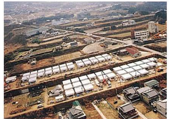
建設中の背山1.2団地
