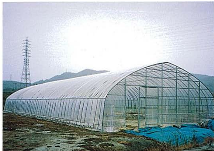
小倉地区 仮保存用ビニールハウス(H.8.6~)
