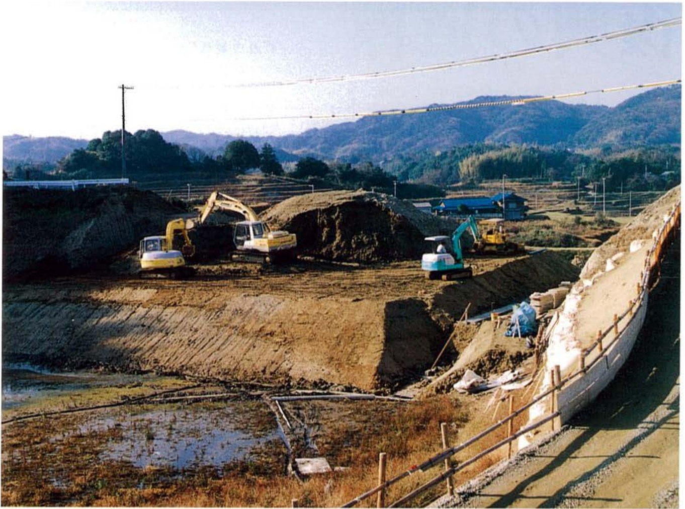
生田・葛原池の復旧工事現場。町全体では277ヶ所のため池が被害を受けました。地下水位の異常な低下と、ため池の亀裂により、農業用水の確保が難しく、作付不能になるところがありました。
