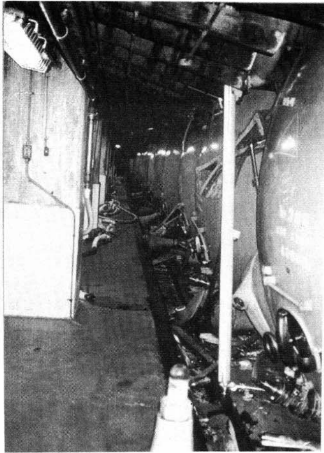
写真4.5-10 酒造工場の横置きタンクの転倒
