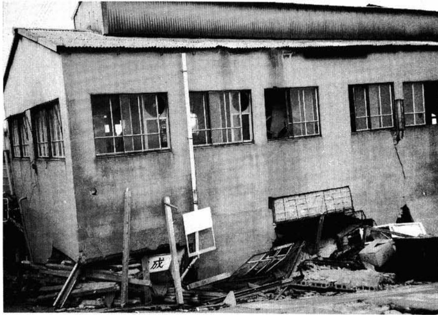
写真4.4-3 神戸市長田区の小規模工場の圧壊
