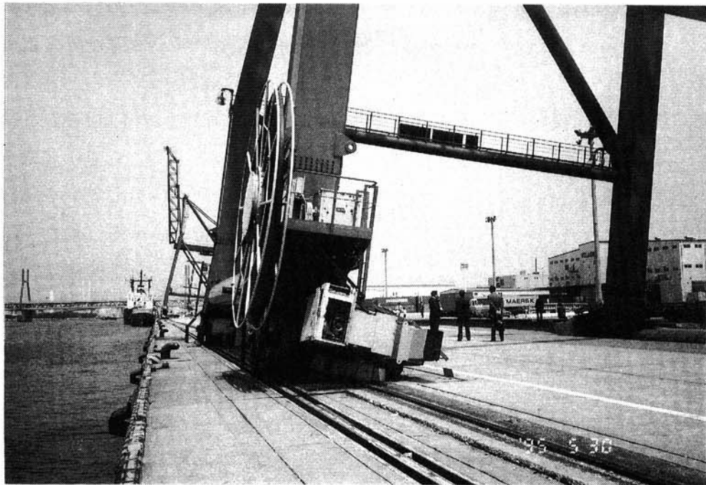
写真4.3-2 液状化・側方流動によるコンテナクレーン 走行装置の損傷
