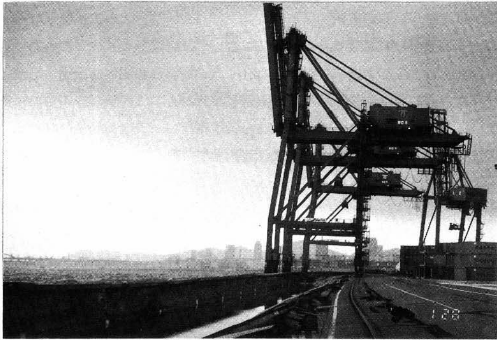
写真4.3-1 神戸港人工島岸壁のコンテナクレーンの損傷
