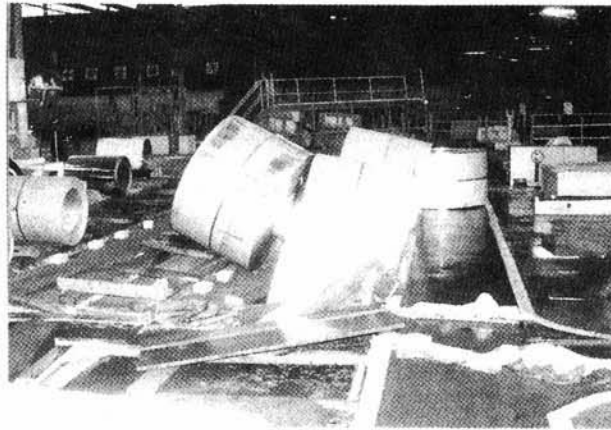
写真5.6-4 床が陥没し、傾いたコイル 神戸
