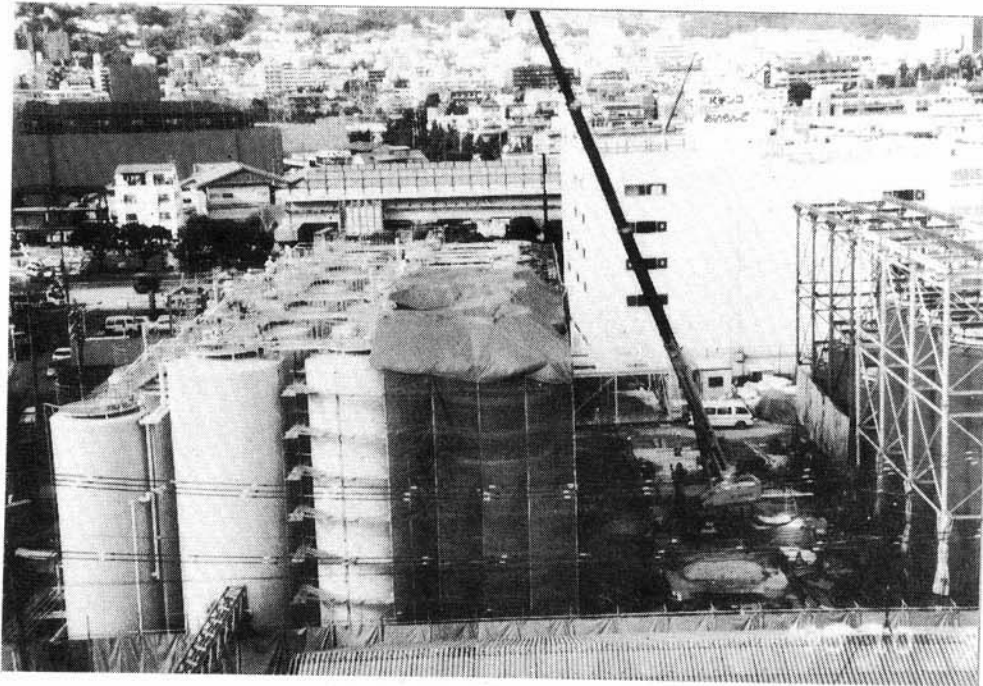
写真5.5-8 新しく建設中の屋外円筒形縦置きタンク
