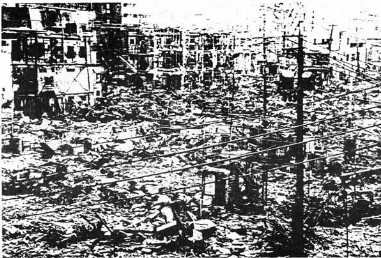
長田区菅原通の火災現場
