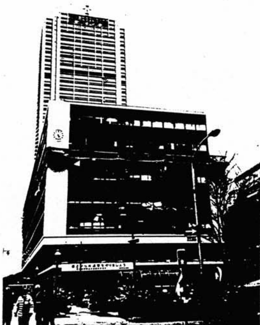
⇐ 今回の地震における崩壊の特徴として中間階の層崩壊があげられ、神戸市役所旧館は下層部のRSC造、上層部はRC造との接合構造部で圧壊した。
