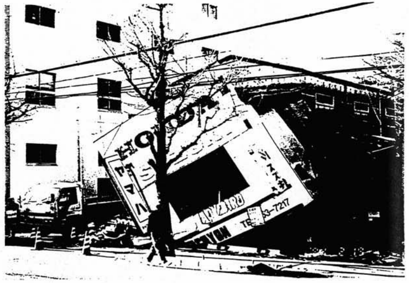
東灘区本町 国道2号線沿いの一階店舗部が全壊した木造建物。
