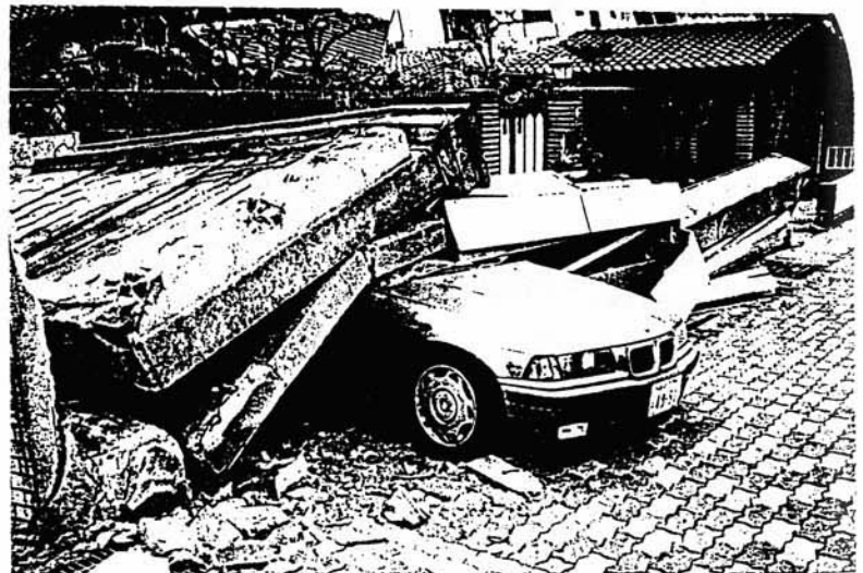
倒れてきた塀に押しつぶされた乗用車
