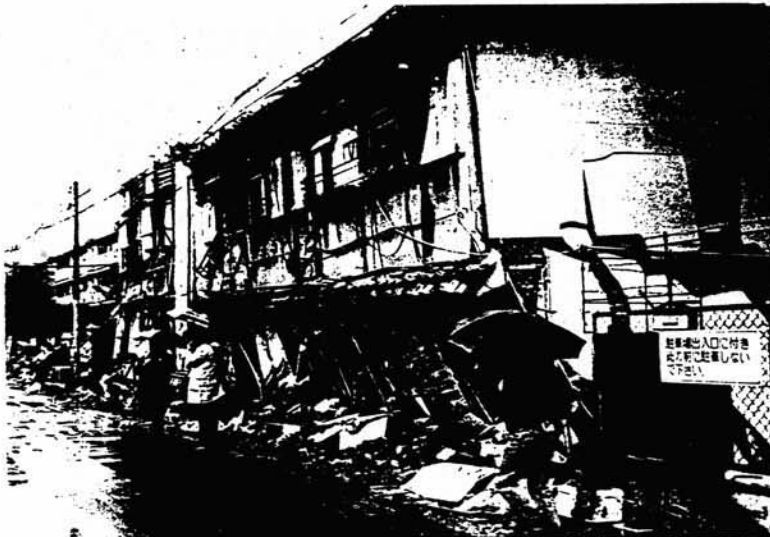
東灘区阪神電鉄石屋川車庫北側の 一階部分が大きくせんだん変形を起こした文化住宅。
