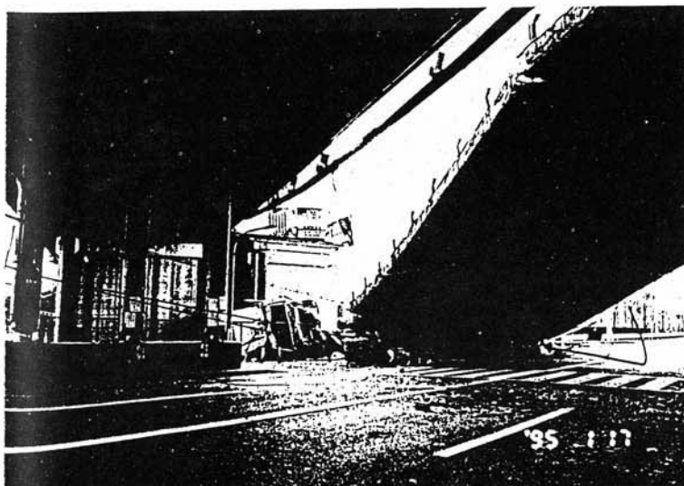
名神高速道路上り線の西宮市高畑町付近の橋梁において円柱RC橋脚ヒンジ部が破損したため橋桁が落下した。
