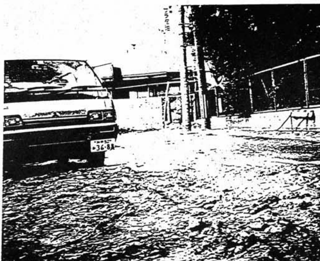
埋立て工区内の道路上を覆った液状化による噴砂・泥
