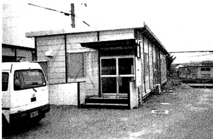
仮設住宅地域にある集会所“ふれあいセンター” =津名郡一宮町=
