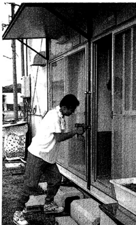
仮設住宅改修に汗を流す社協職員 =津名郡一宮町=
