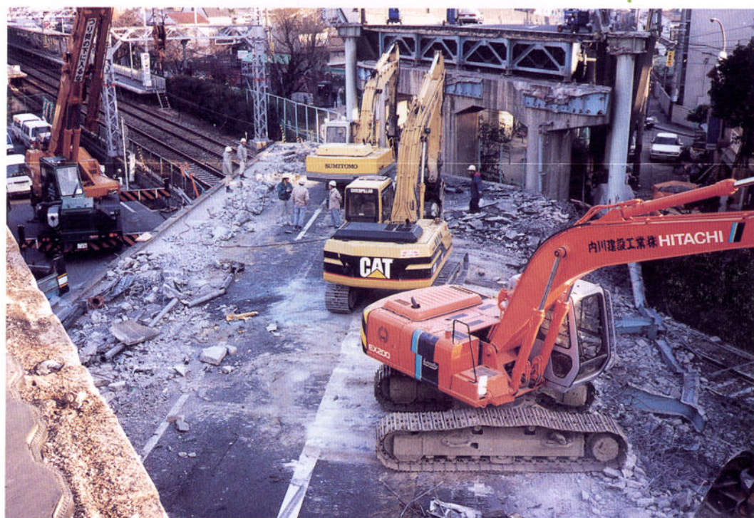
一般国道171号門戸高架橋
