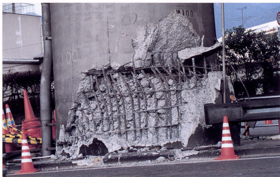
阪神高速道路3号神戸線（芦屋市宮川町）神 P-100
