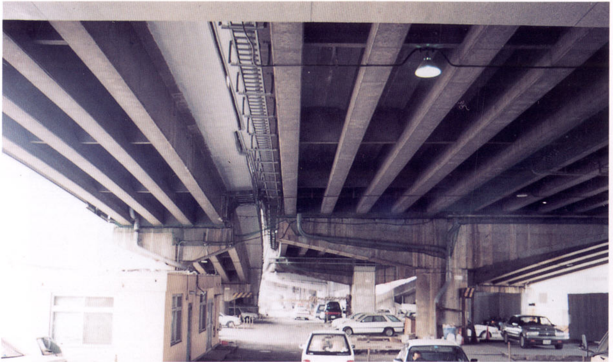
阪神高速道路3号神戸線（神戸市中央区京橋） 京橋地区
