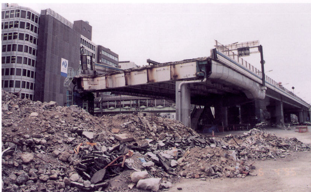
阪神高速道路3号神戸線（神戸市中央区波止場町）
