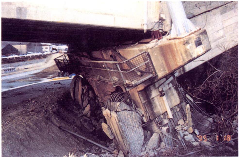
山陽新幹線 伊川高架橋
