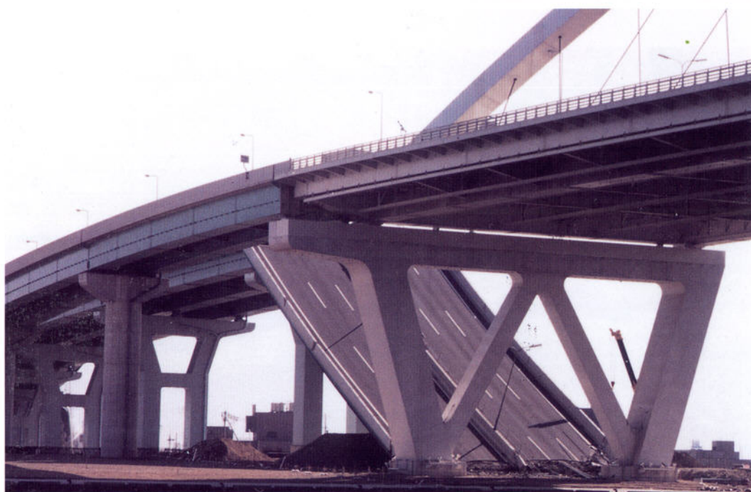
阪神高速道路 5号湾岸線西宮港大橋
