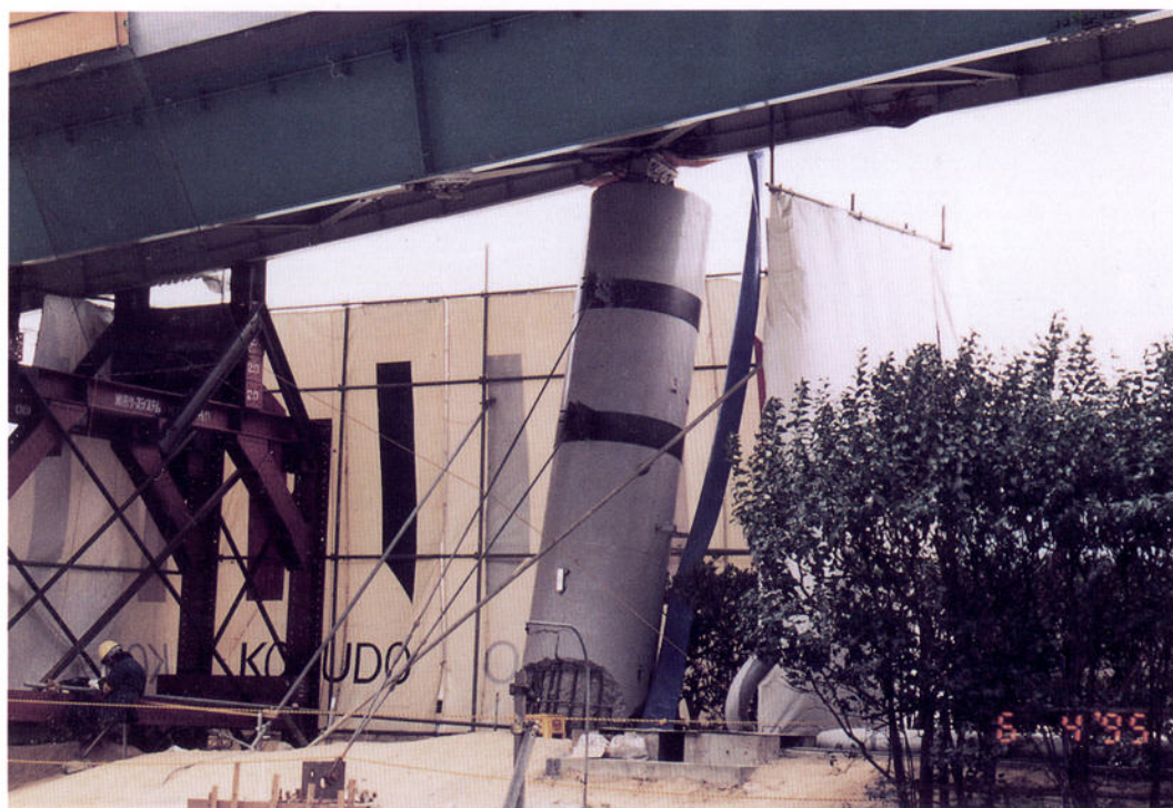
阪神高速道路 3 号神戸線 芦屋入路
