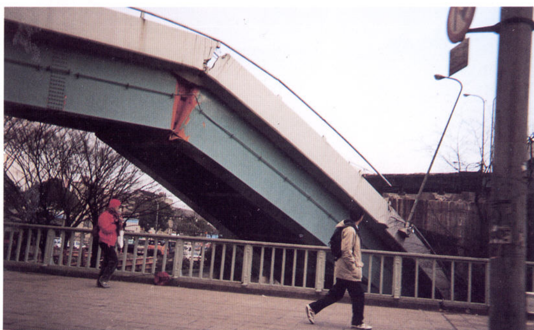
阪神高速道路 3 号神戸線湊川ランプ
