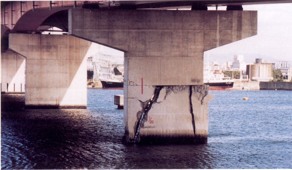
西宮大橋（西宮市西宮本町－西宮浜間）
