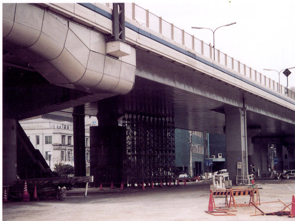
阪神高速道路3号神戸線（神戸市中央区波止場町） 京橋地区
