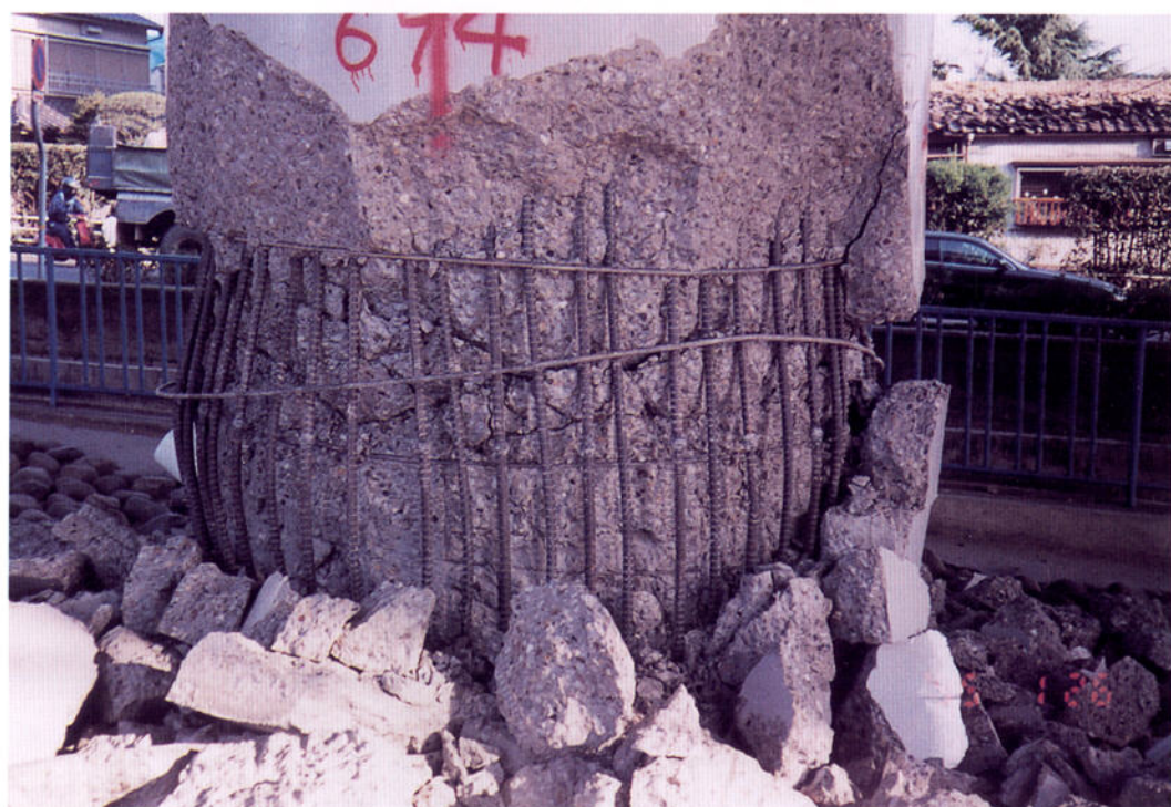
阪神高速道路3号神戸線（神戸市須磨区） 神P-694
