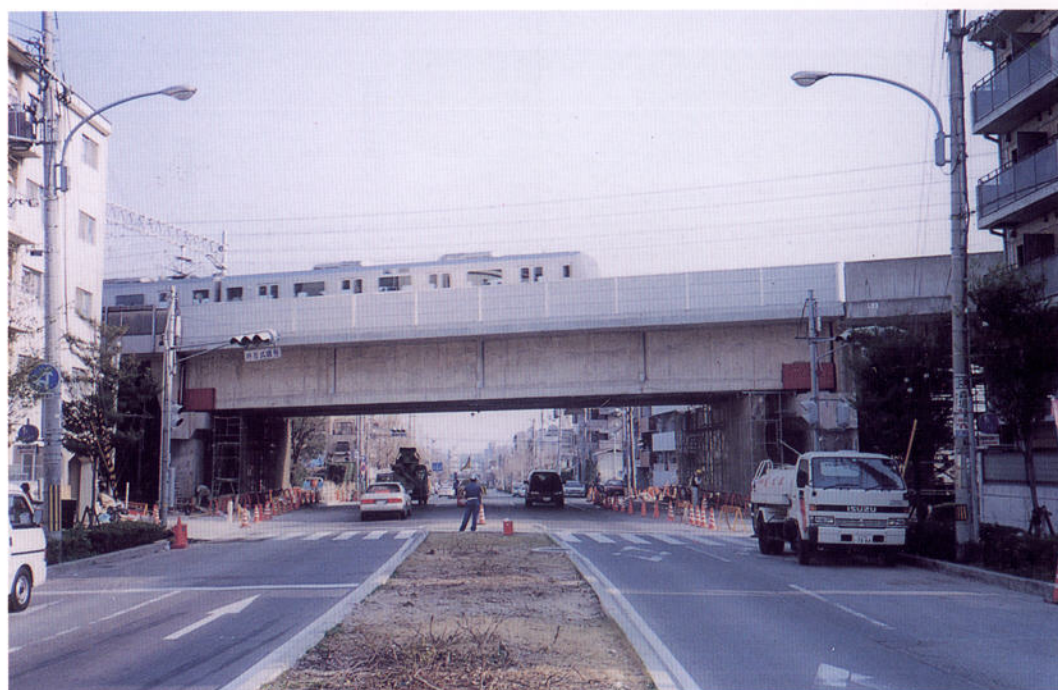
東海道本線 弓場架道橋
