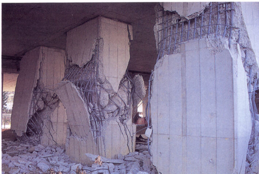
中国縦貫自動車道 宝塚高架橋
