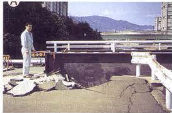
宮川の被害と復旧（護岸の側方流動→矢板護岸による復旧）
