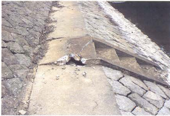
昭和池ダムの被災（上流面小段のクラック）と復旧
