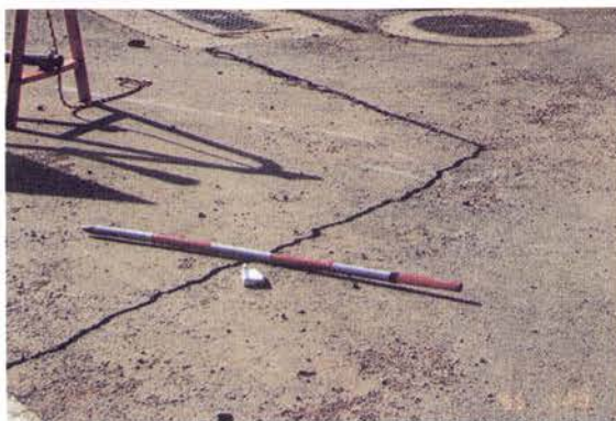
常磐ダムの被災（天端舗装面のクラック）と復旧
