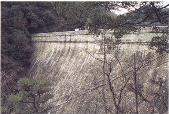
五本松ダムの状況（堤体下流面の状況：変状なし）とグラウチングの施工状況
