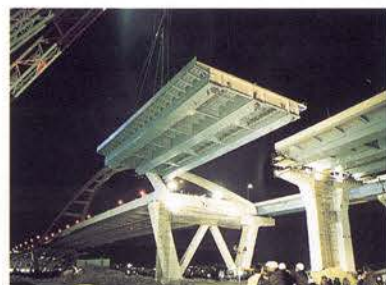
落下した桁をフローティングクレーンで吊り上げ架設する状況 ＝阪神高速5号湾岸線 西宮大橋（5月14日）
