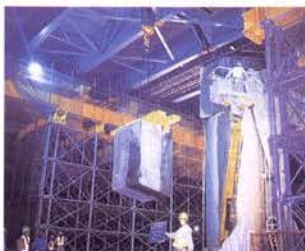
テルファー工法によるブロック撤去
