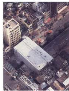
建物の倒壊 (神戸市中央区)
