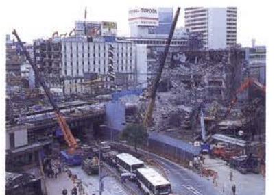
多数の映画資料を保存していた阪急会館も取り壊された =神戸市中央区(2月14日)
