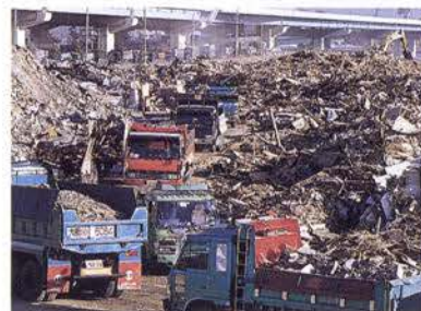
連日運び込まれ、山となった倒壊家屋のがれき ＝西宮市甲子園浜
