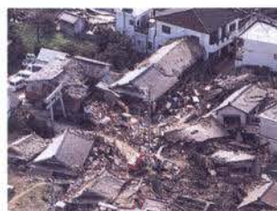
軒並み倒壊した民家 (淡路島一宮町)
