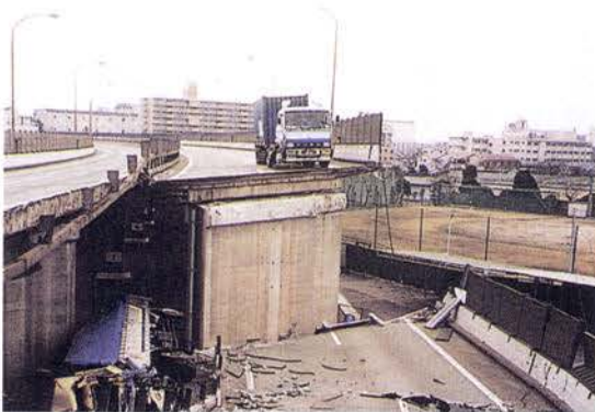
名神高速道路瓦木西高架橋の被災と復旧状況
