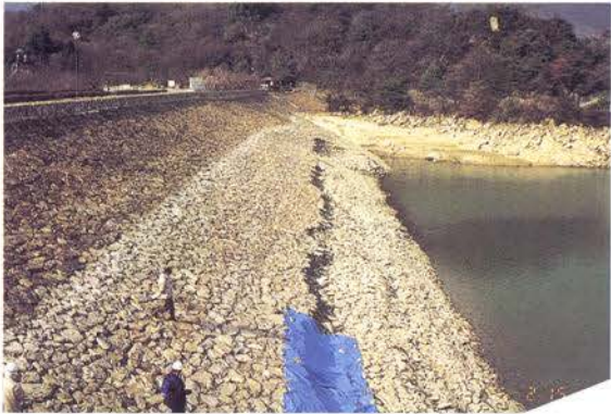
北山ダムの被災（第一ダム上流面張石の滑落）と復旧
