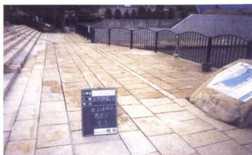
芦屋市仲ノ池緑地の被災状況（板石舗装の破損）と復旧
