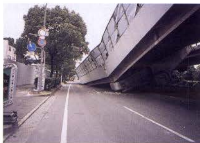
岩屋高架橋の被災と復旧
