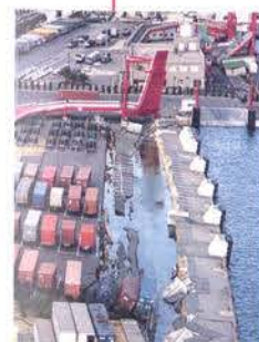
水没したコンテナヤード (六甲アイランド)
