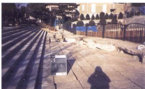
芦屋市仲ノ池緑地の被災状況（板石舗装の破損）と復旧
