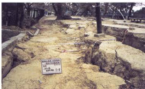
西宮市夙川河川緑地の被災状況（園路（河川堤体）の破損）と復旧
