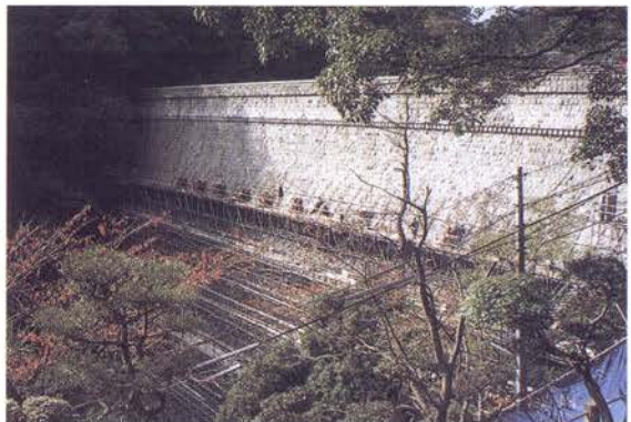
五本松ダムの状況（堤体下流面の状況：変状なし）とグラウチングの施工状況
