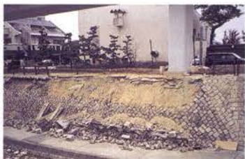
住吉川の被害と復旧（空石積護岸の崩落→在石使用の練石積による復旧）
