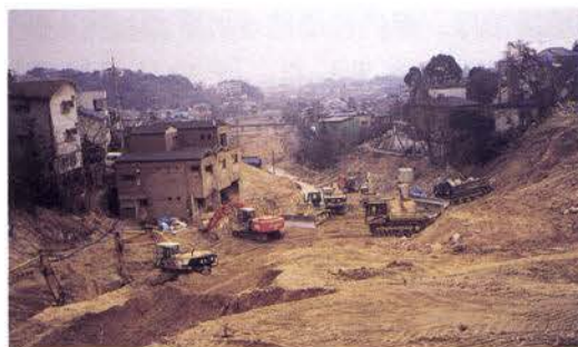
仁川百合野地区での緊急河道掘削
