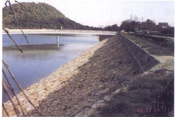
北山ダムの被災（第一ダム上流面張石の滑落）と復旧
