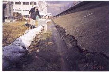
中島川の被害と改良復旧（特殊堤防の沈下→耐震構造の護岸による復旧）
