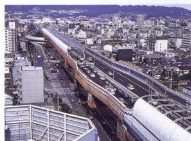
復旧工事が完了、全面開通した阪神高速3号神戸線 （1996年9月）
