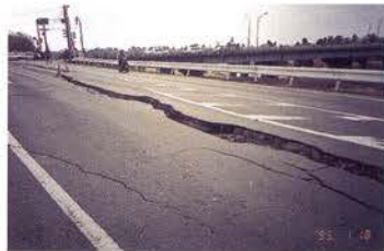
武庫川の被害と復旧（盛土堤防の円弧すべり→盛土による復旧）
