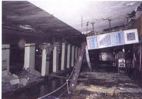
神戸高速鉄道大開駅の被災（開削トンネルの中柱座屈、頂版陥没）と復旧
