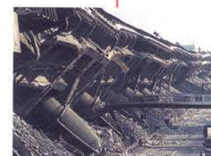
倒壊した高速道路 (神戸市東灘区)
