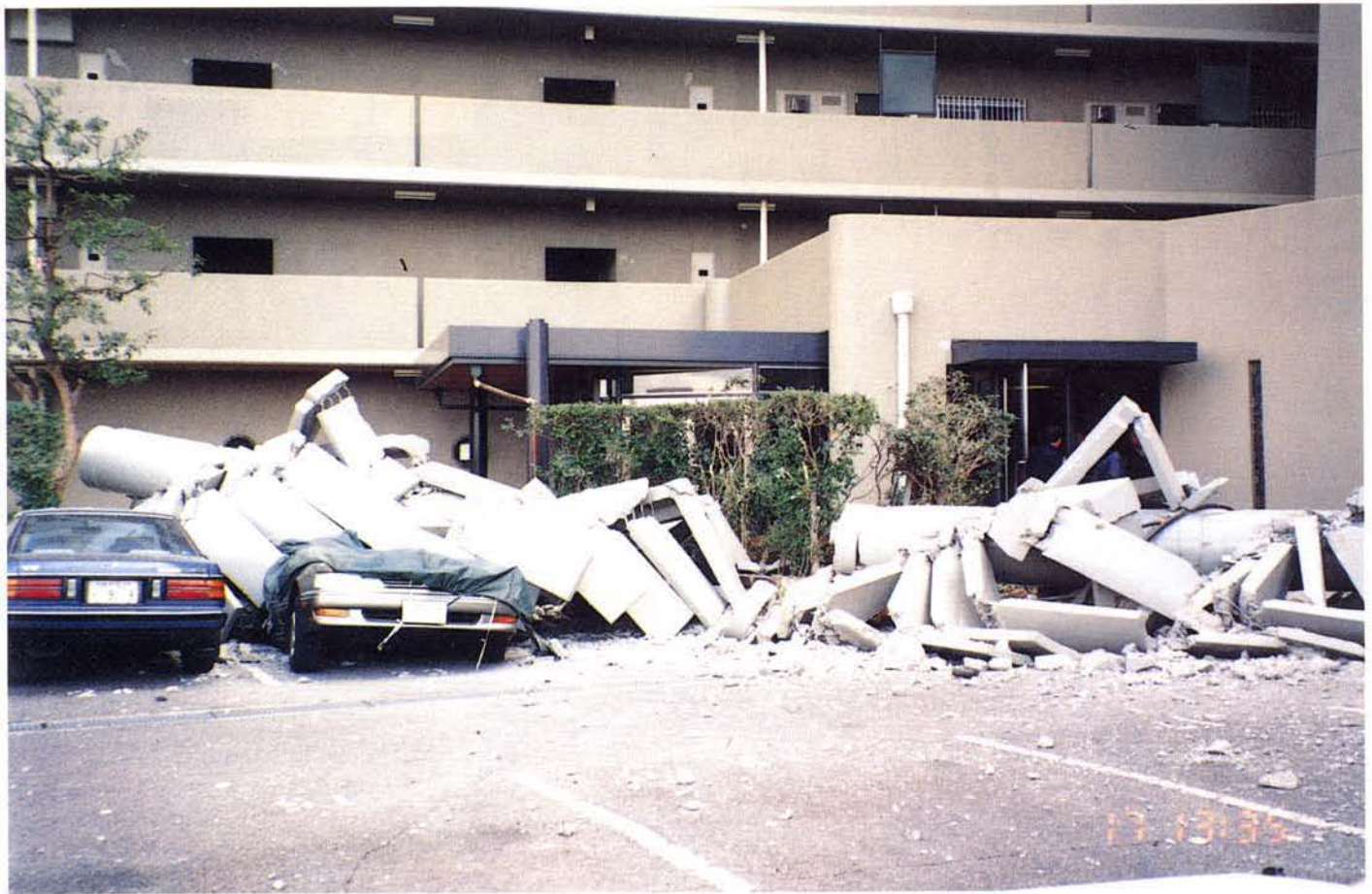
▲マンションの外部階段も崩壊した(中崎2丁目)
