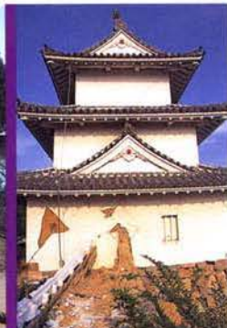
▲白壁にひびが入り、崩落した明石城・巽櫓
