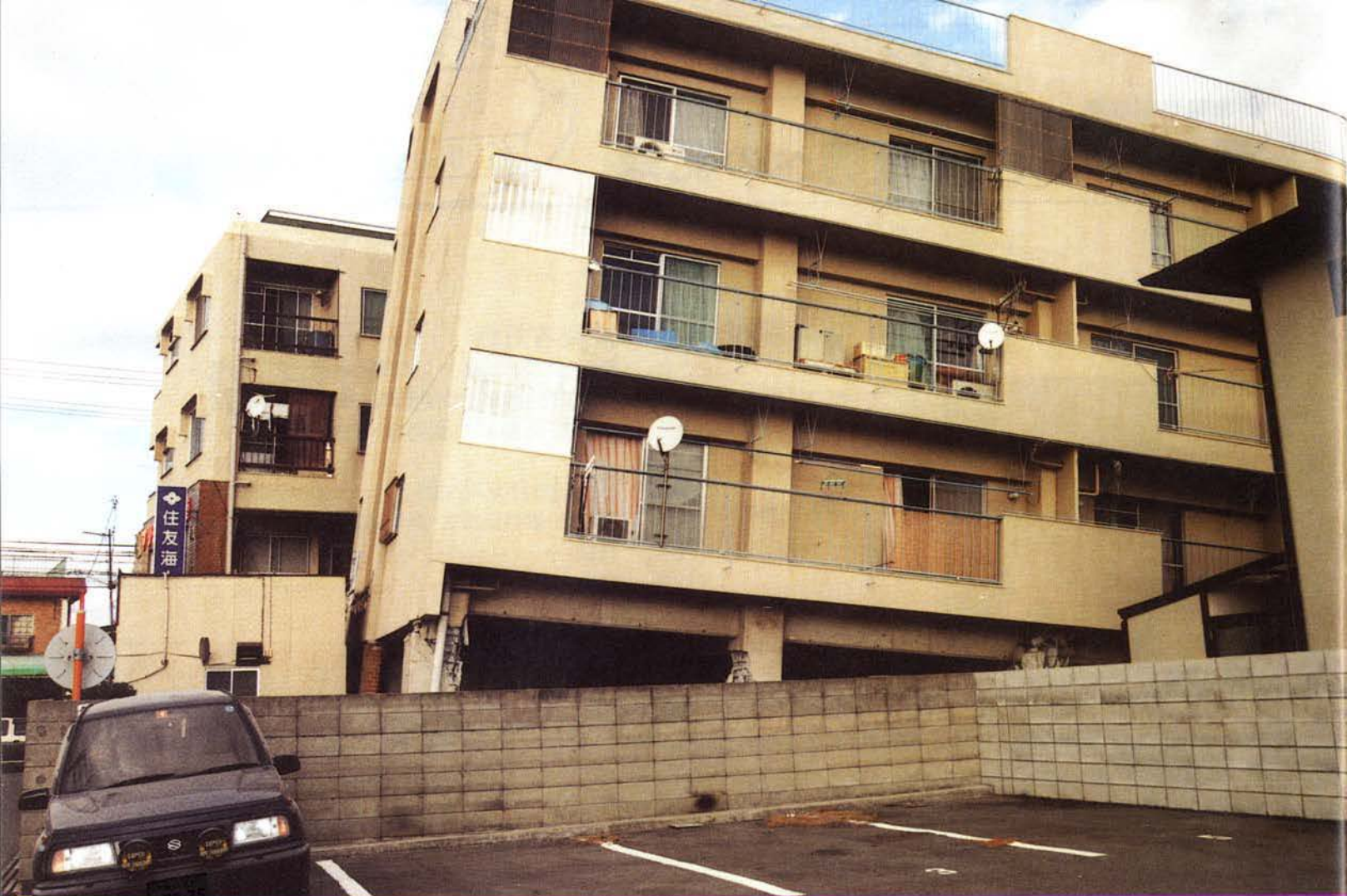
▲柱が崩れ、大きく傾いたマンション(太寺大野町)
