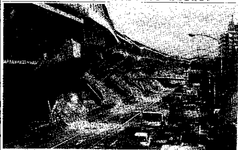
市道に倒壊した、幹線高速道路＝17日午後、神奈川東横地区深江本町
